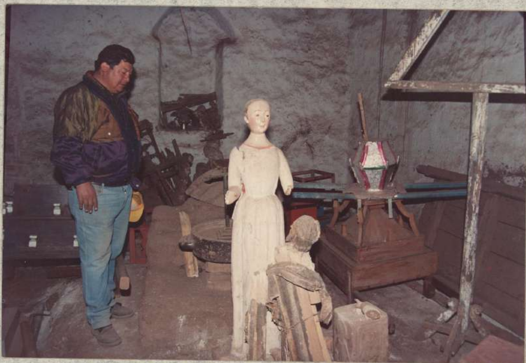
SALA DE BAUTISMARIO EN COMPLETO DETERIODO I LA PUERTA PRINCIPAL DEL TEMPLO DE PACCARECTAMBO.
