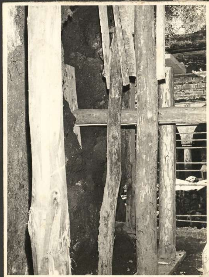
A-118 : Interior vano, apuntalamiento excesivo y torzoso por falta de conservación en sus elementos.
