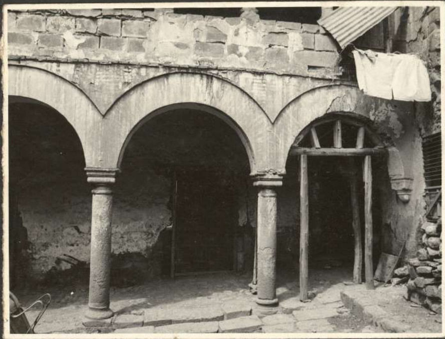
A-104 - Apuntalamiento del arco y protección provisional de los carnes del comedor Enero-76
