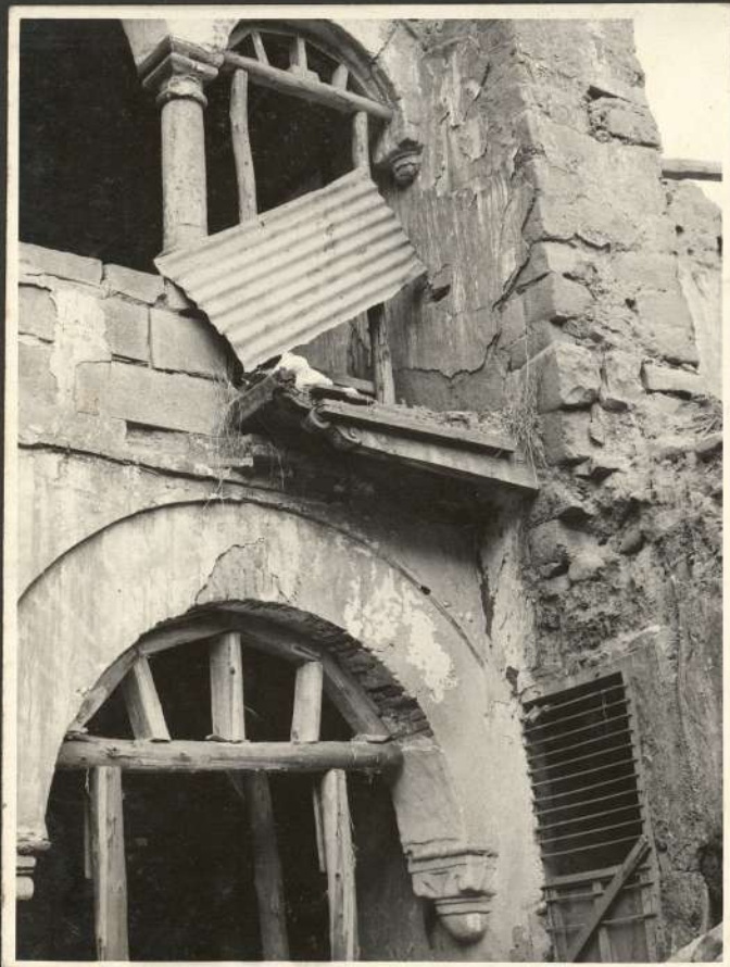
A-104 - Apuntalamiento del arco y protección provisional de los carnes del comedor Enero-76
