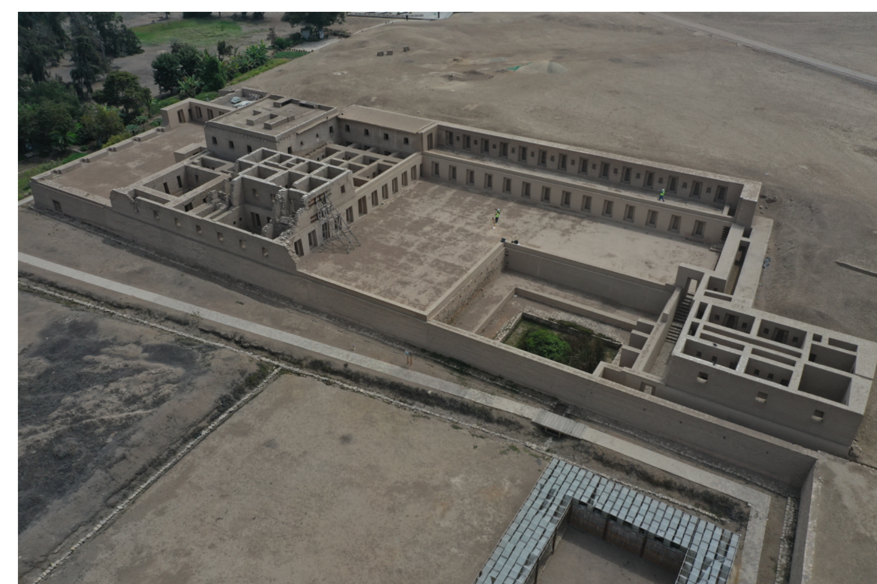
Vista general de las estructuras.
