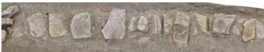
Figura 19.- Detalle de las tapas de piedra y argamasa original del canal de abastecimiento de agua.
