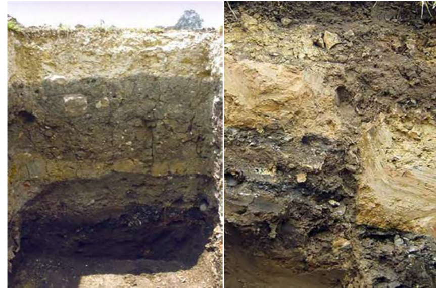
Foto 6. Izq.: estratigrafía atípica hallada en uno de los muestreos de Navas y Barranco (2013), que posiblemente corresponde al relleno de una zanja lateral. Der.: Fractura en las capas de pavimento por el peso de los cargueros de materiales depositados encima.
