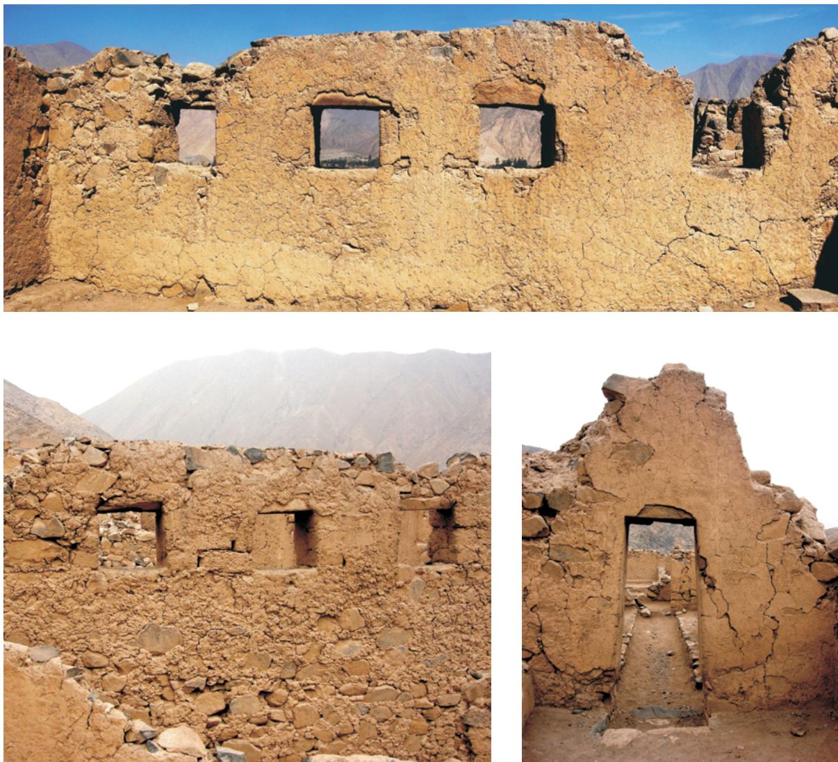
Foto 16. a. Muro de las ventanas en el segundo nivel de la unidad de acceso al Conjunto G; b. El mismo muro desde el exterior, donde se nota el empleo de adobes inca; c. Vano trapezoidal a un lado del patio-plaza asociado a la plataforma con rampa del Subconjunto G1, en el Conjunto G (fotos por Edgar Centeno Farfán)
