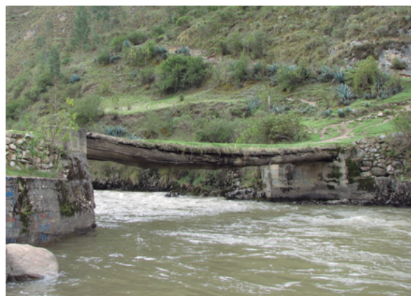
Foto 3. Puente sobre el río Vizcarra u Orqomayu; nótese los estribos de concreto (foto por Carlo Ordóñez Inga)
