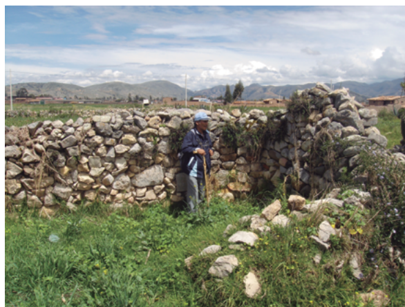
Foto 6. Restos de un edificio de planta rectangular, levantado con muros de piedra asentada con argamasa de barro, en el actual barrio Cusco del pueblo moderno de Sausa
