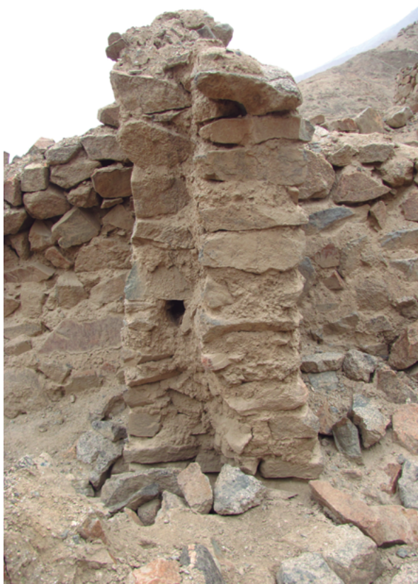
Foto 1. Vano de doble jamba
