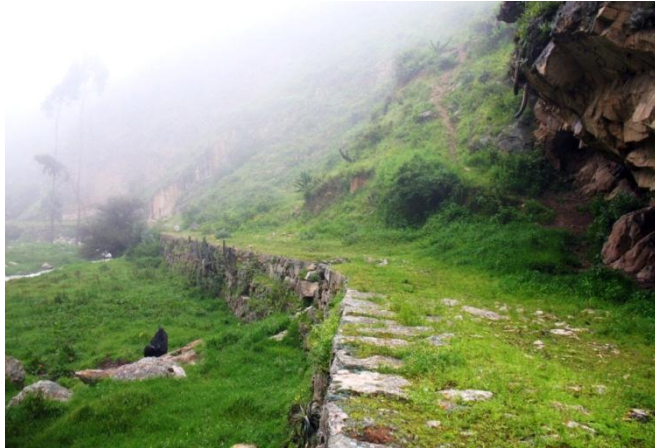
Sección de camino en plataforma que se emplaza en la margen derecha del río Pira entre las localidades de Uchupampa y Tambo en el subtramo Tinco – Tambo.
