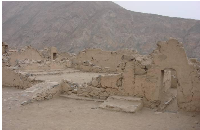
Foto de la Plataforma con Rampa en el Conjunto G (Ventanas)
