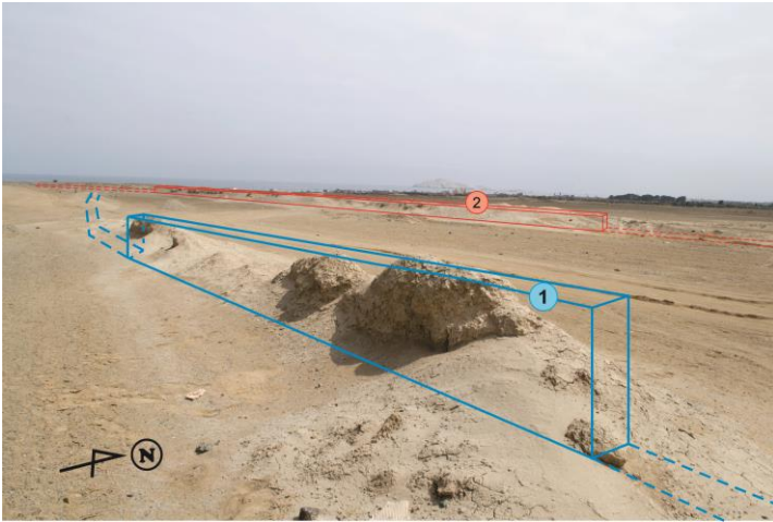
Foto 4. Detalle del trazado y técnica constructiva de tapiales de dos de los muros del sistema de paredones (foto de José Luis Matos; ilustración de Rodolfo Peralta, 2012).
