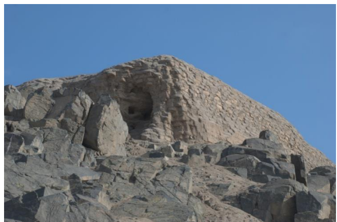
Foto 7. Edificio Oeste de El Salitre, en el valle próximo de Mala. Nótese el empleo de adobes paralelepípedos en su construcción. Vista al sureste (foto de Rodolfo Peralta, 2012).
