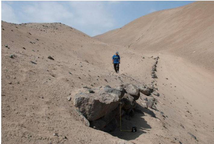
Foto 6. Detalle del muro de contención del tramo del Qhapaq Ñan identificado sobre la cima del Cerro Largo (Foto de J. L. Matos).
