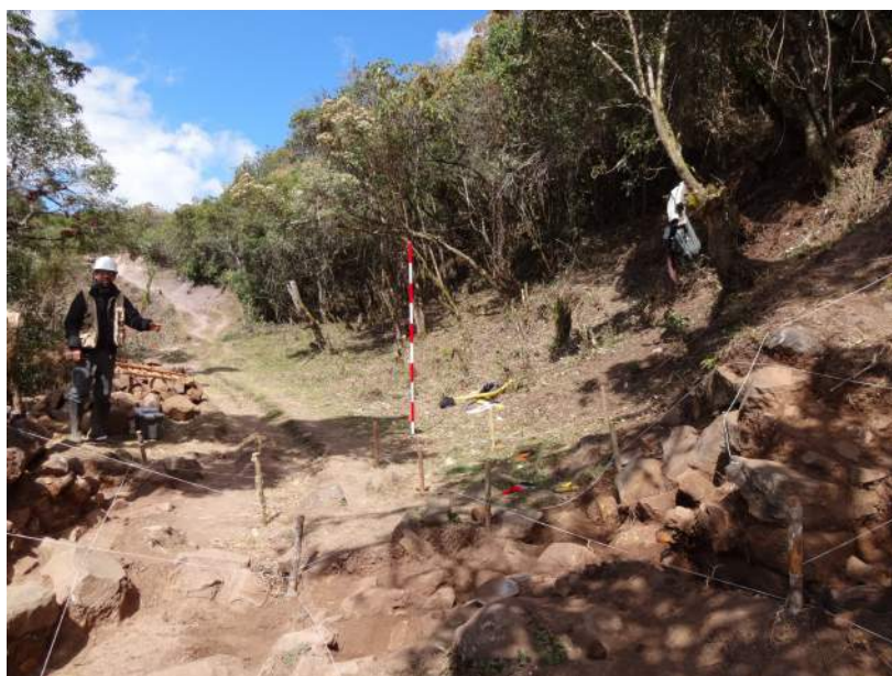
Fig.1 camino Inca, estructura de control
