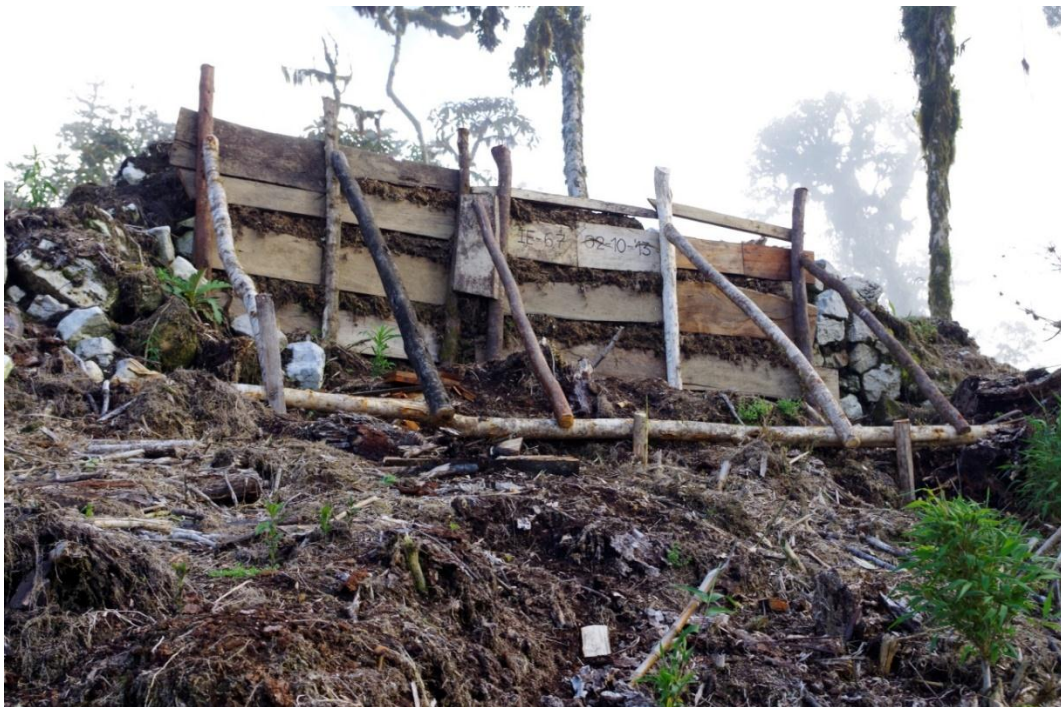
Apuntalamiento de muros
