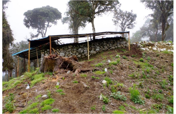
Cubierta de estructuras
