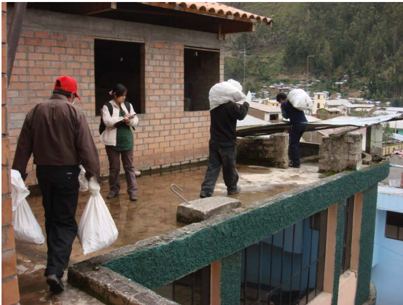
Fig. 07: Equipo del Proyecto Integral Huánuco Pampa recuperando los materiales del último piso de la Municipalidad Provincial de Dos de Mayo.
