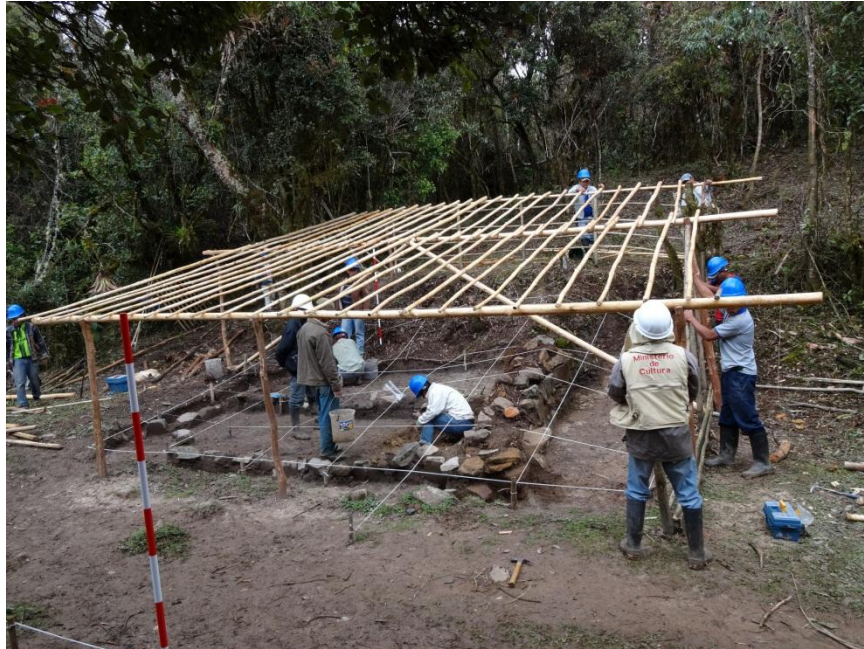
Fig.6: Tareas de conservación preventiva frente a las lluvias, colocación de coberturas.
