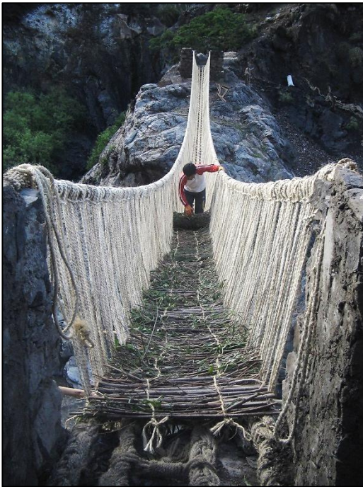
Colocación de la masta o piso del puente y la inauguración del puente de Pukayacu.
