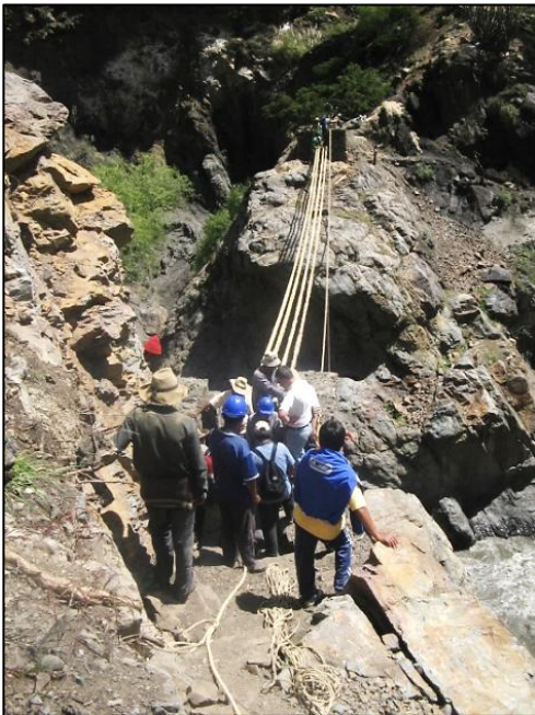
Trabajos de amarre de las sogas principales a los estribos del puente de Pukayacu
