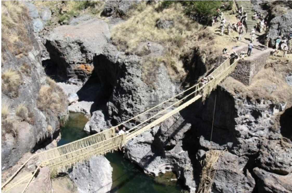
Figura 3. Puente Q'eswachaka en proceso de reconstrucción, Cusco. Fuente: Ricardo Chirinos Portocarrero. Proyecto Qhapaq Ñan.
