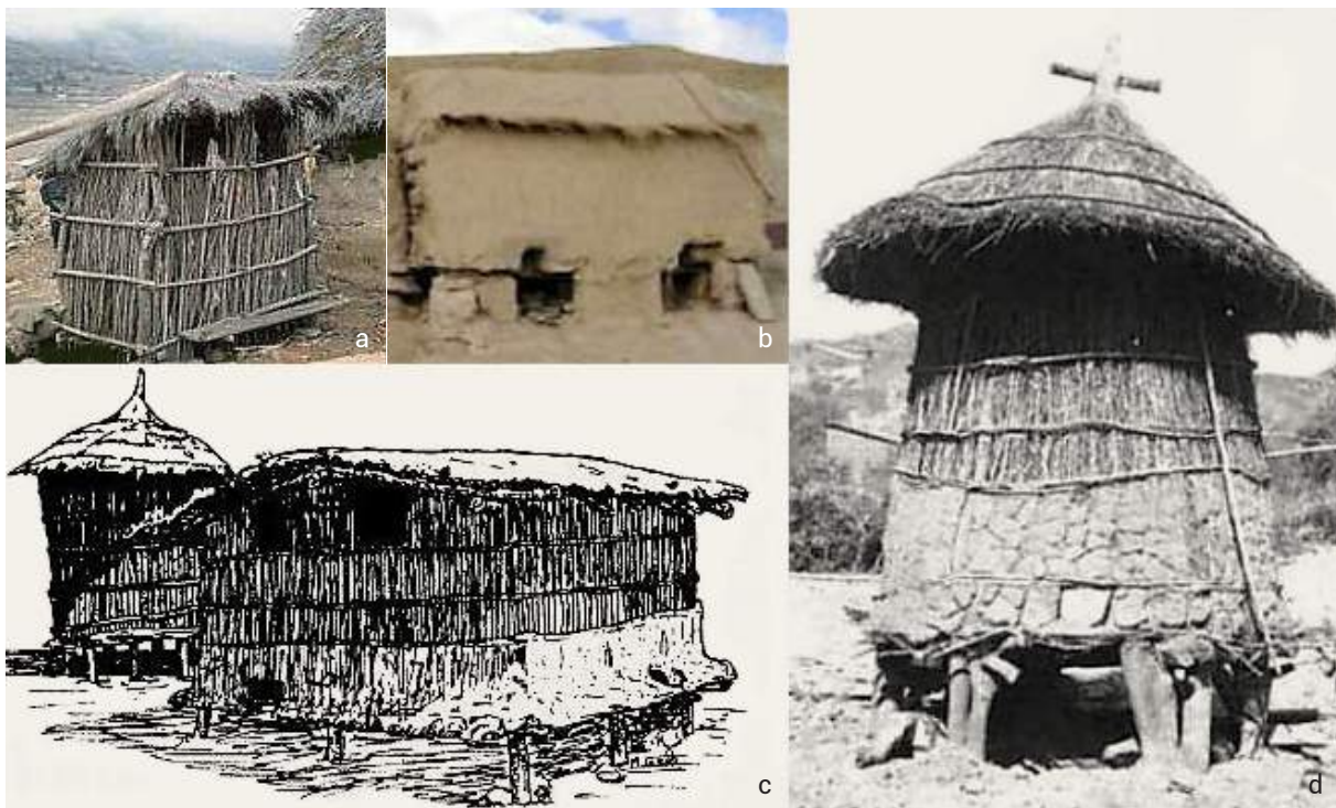
Foto1. Piruas de almacenamiento empleadas en la actualidad: a) Construida con ramas entrecruzadas para guardar oca, zona productiva de Colomi, Cochabamba (González et al. 2003: figura 14); b) Elaborada con piedras y enlucido de barro para almacenar tubérculos (papa y chuño) y gramíneas (cañihua y quinua), ayllu Majasaya Mujlli de la provincia de Tapacarí (Tapia 2005: foto 6); c) Confeccionadas con ramas para guardar papas, maní, trigo o cebada (cuadrangular) y maíz (cilíndrica), provincia de Mizque (Kent 1998: figura 4), y d) Construida con ramas y enlucido de barro para el almacenamiento de maíz, provincia de Mizque (Gyarmati 1998: figura 4)
