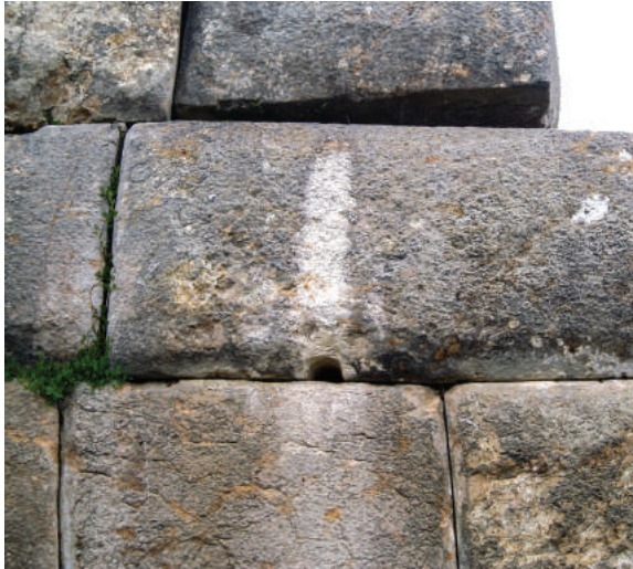
Foto 12. Desfogue del ducto de drenaje ubicado entre los niveles 4 y 5 del Muro Oeste del ushnu
