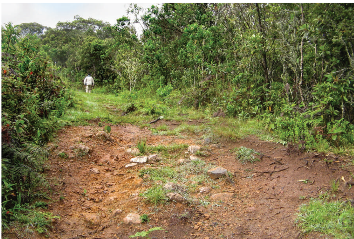
Foto 1. Calzada afectada por erosión (sector Aypate)
