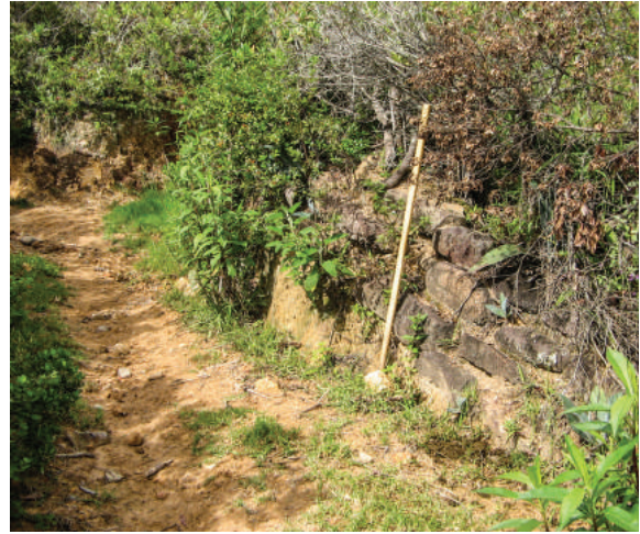
Foto 5. Muro lateral Este, nótese la calzada erosionada (sector Huaca Samanguilla)
