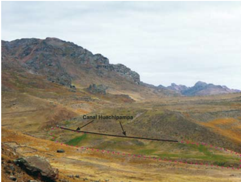
Canal Huachipampa y área irrigada
