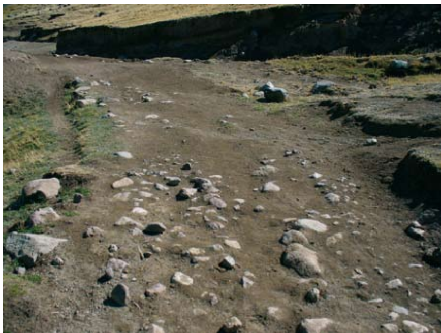
Detalle de la erosión de la calzada por tráfico de arrieros y falta de mantenimiento de la ruta a Miraflores
