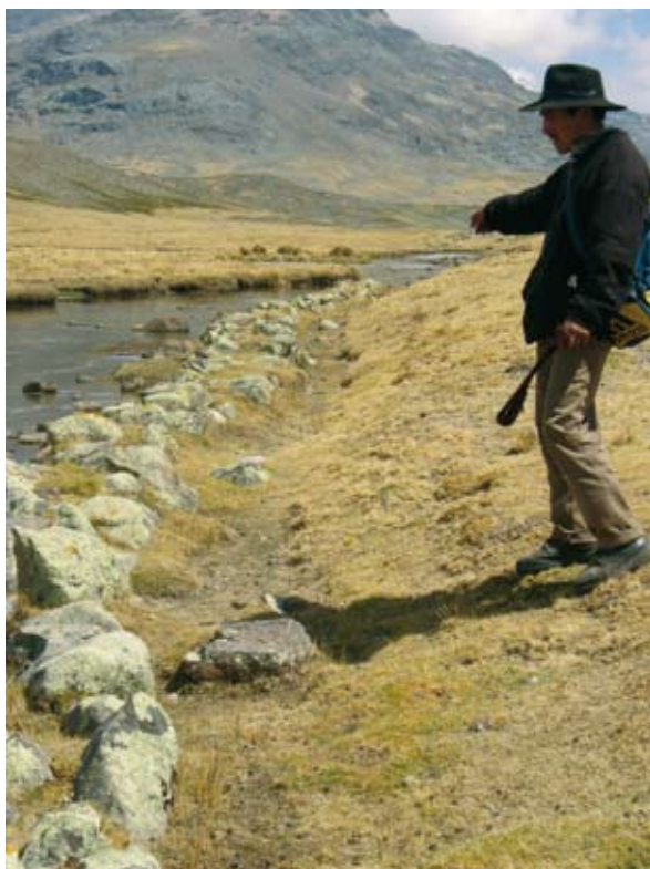
Bocatoma del Canal de Moya 2, ahora en desuso
