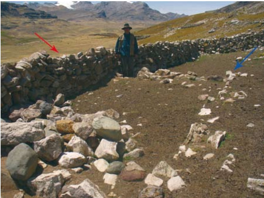
Tambohuay: nótese claramente los cimientos originales de muro desmontados para uso de grandes corrales modernos
