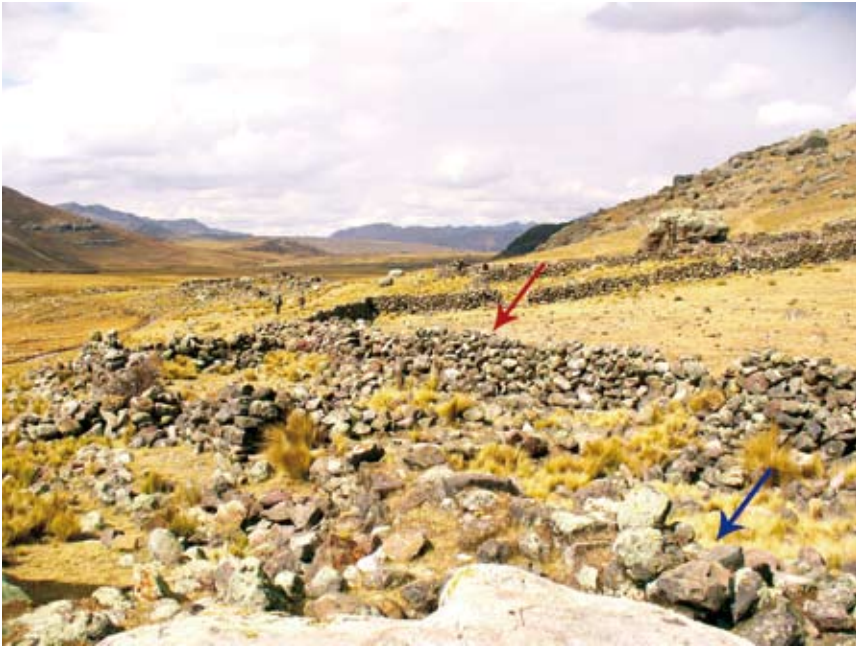
Tambo Real: muros originales desmontados (en azul) para hacer nuevos corrales de pastores (en rojo)
