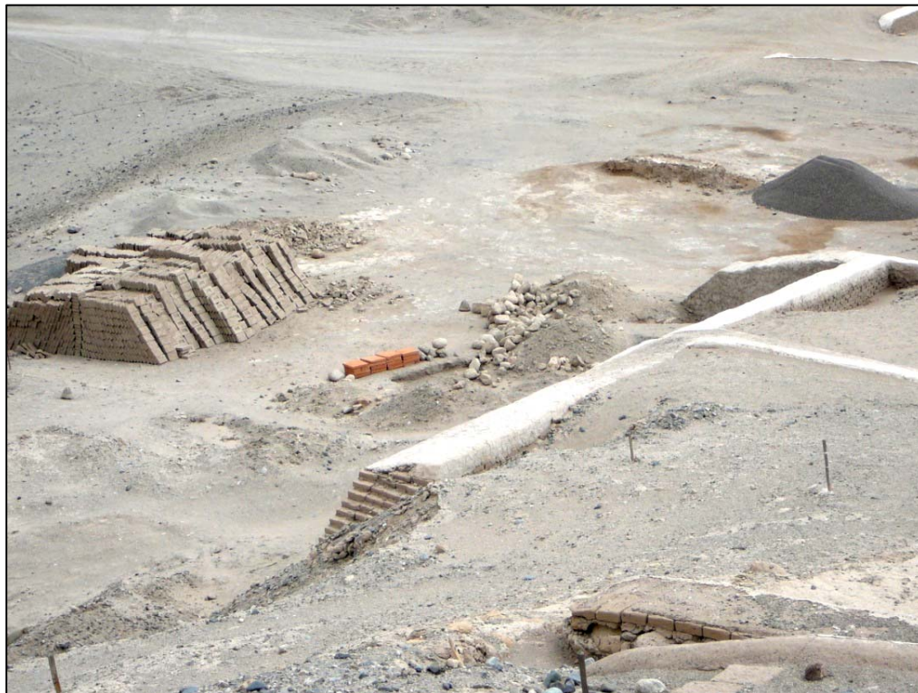
Area de trabajos reconstructivos muestra muros intervenidos, totalmente nuevos en su aspecto externo; se observan los materiales de aplicación (barro, adobes y ladrillos) y suelos salinizados debido a la humedad generada por la obra.
