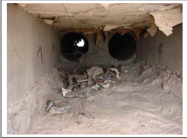
Alcantarilla 01 sección mixta (circular y cajón)
