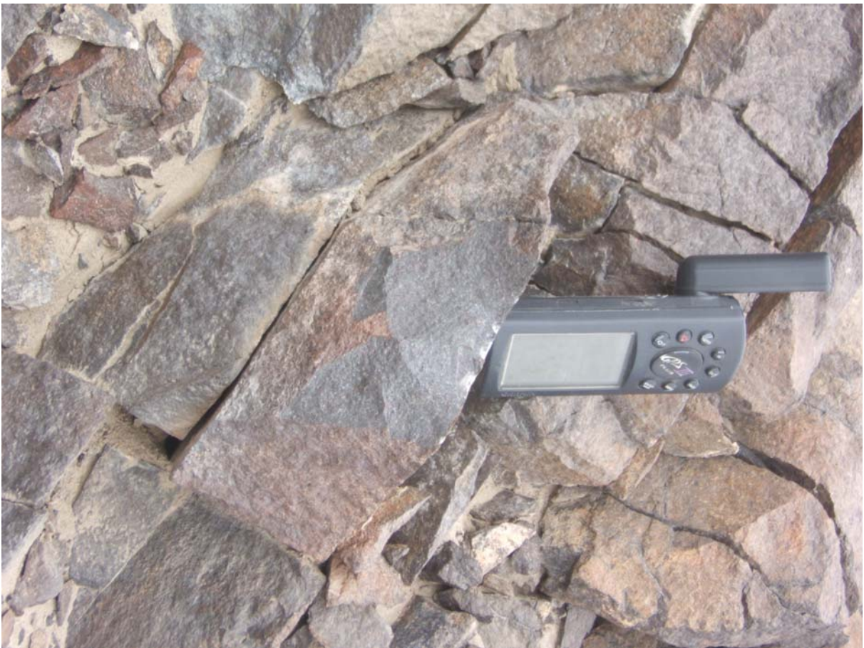
Vista de acercamiento del substrato subvolcánico porfirítico con alteración a gris violáceo y fracturado.
