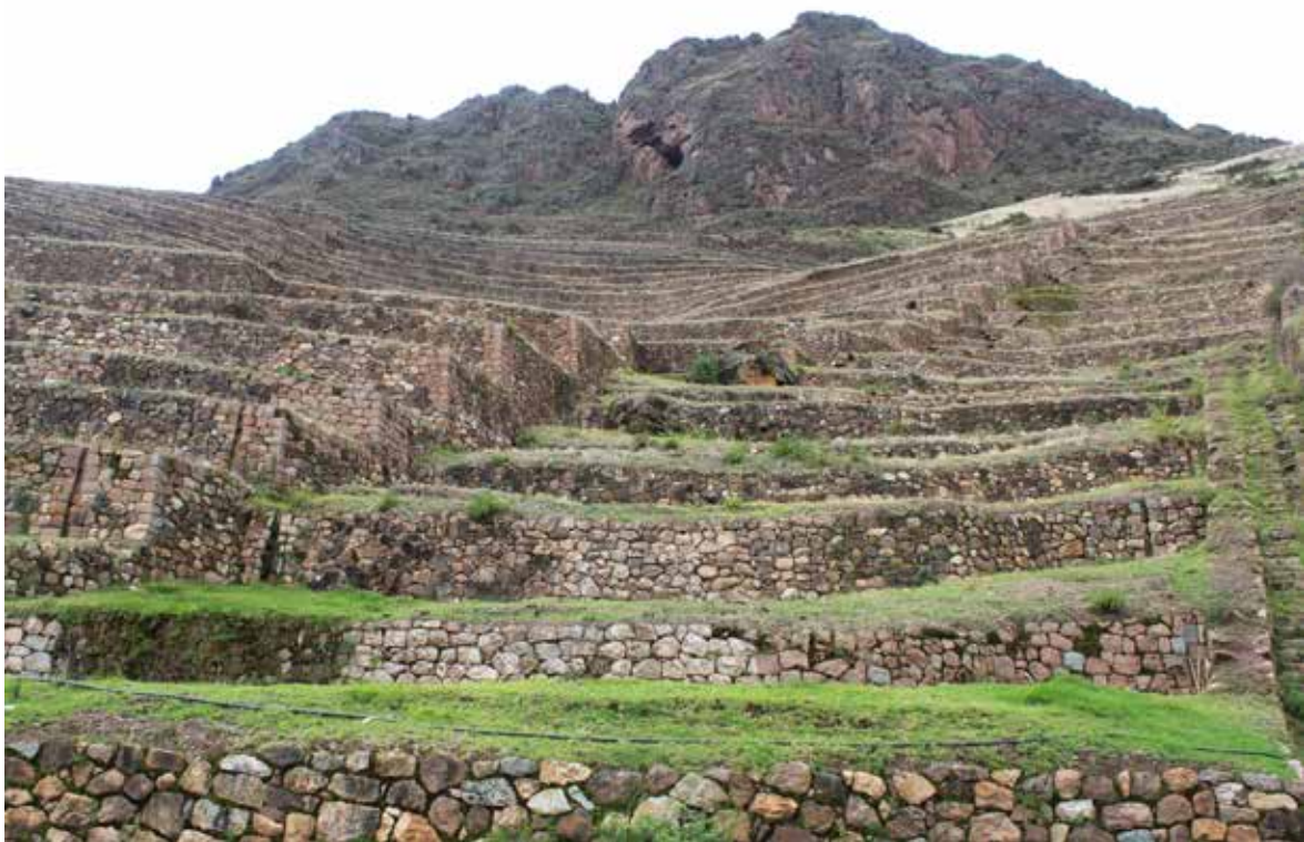
Figura 7. Estado actual de los sistemas de andenerías del sector Qhosqa post intervención.
