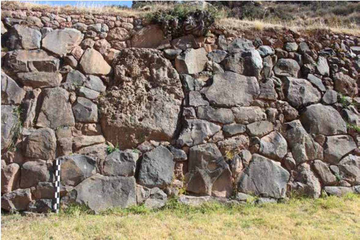
Figura 6. Muro de contención ciclópeo a manera de contrafuerte S. K'alla Qhasa. Fuente. Archivo fotográfico personal (2016).
