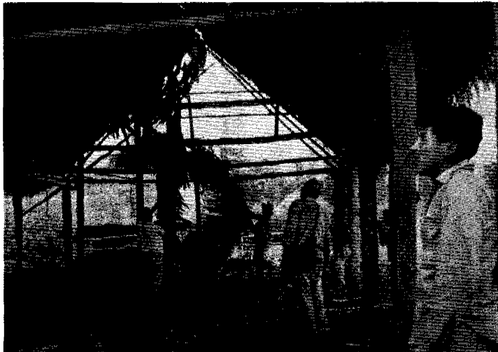
Foto 5. Los hombres nomatsiguengas trabajan juntos para construir un edificio comunal. Los soportes principales se labran a mano; los palos se amarran con bejuco. El techo es de hojas de palmera.
