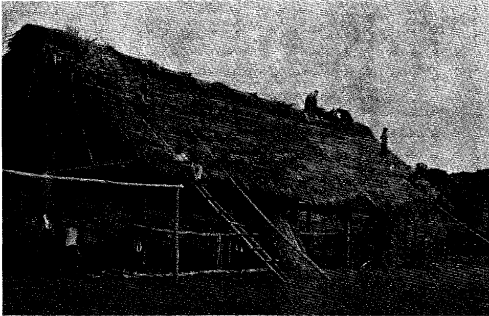
Foto 6. Los trabajadores terminan el techo de una nueva construcción.
