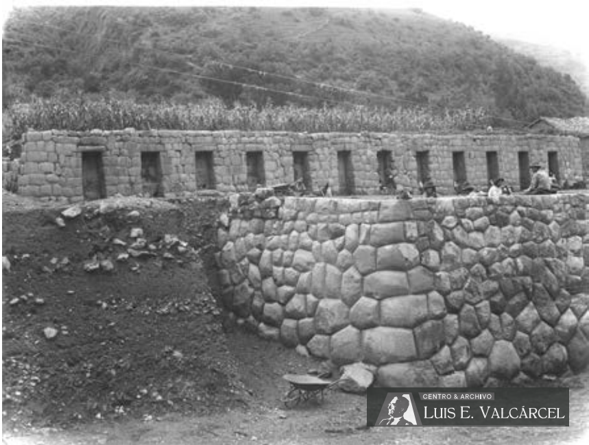
Tarahuasi (TA-037).jpg Trabajos de restauración
