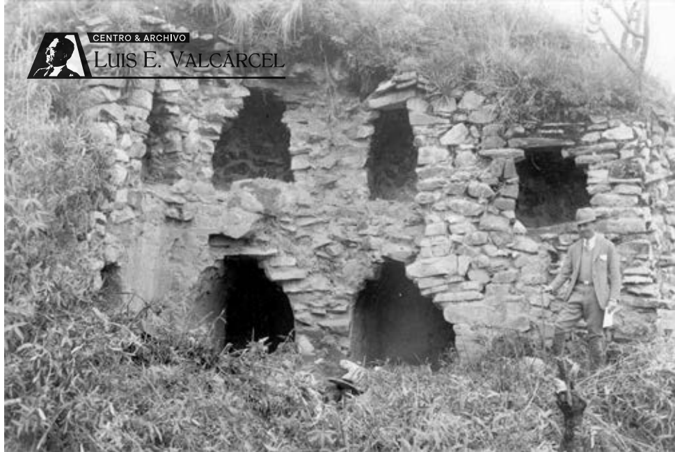
Huata - Cuzco (HT-002).jpg Construcción en piedra
