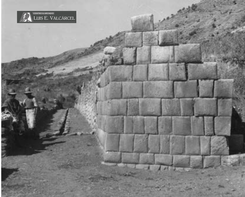
Pacaritambo (PR-004).jpg Muro y zanja
