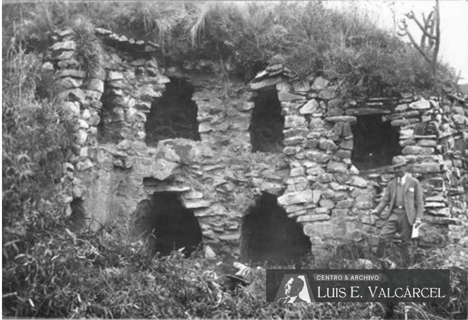
Huata - Cuzco (HT-001).jpg Construcción en piedra
