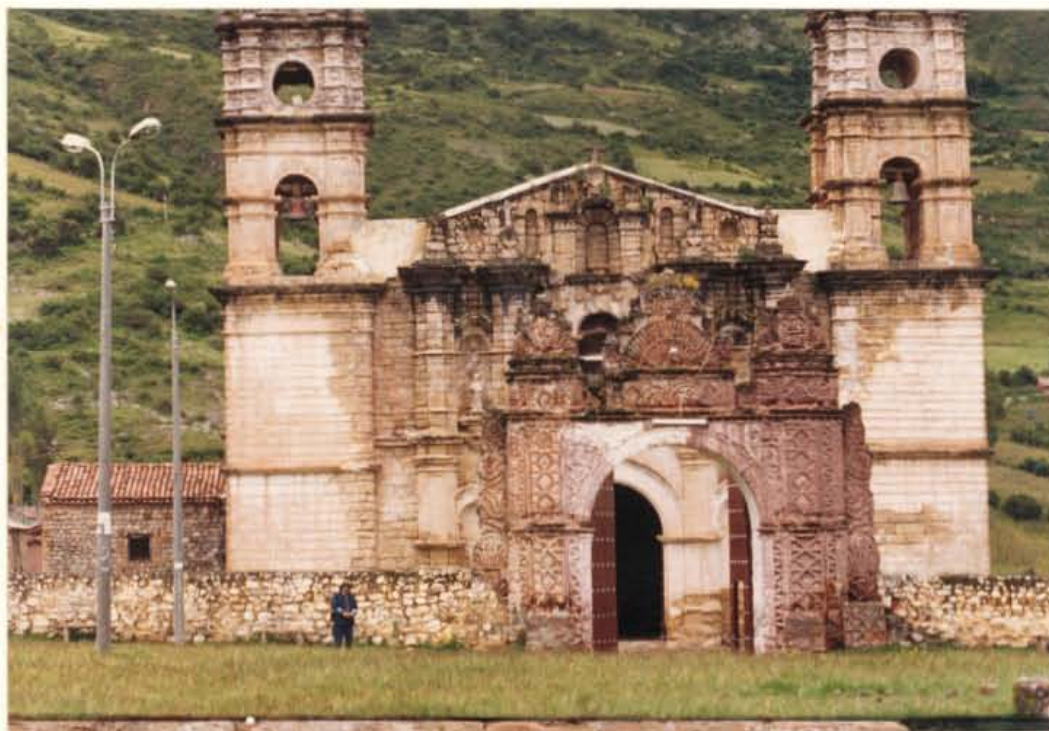
24-C PORTICO PRINCIPAL DE ENTRADA DEL CERCO PERIMETRICO DEL SANTUARIO, ORNAMENTACION DE LADRILLO PASTELERO.
