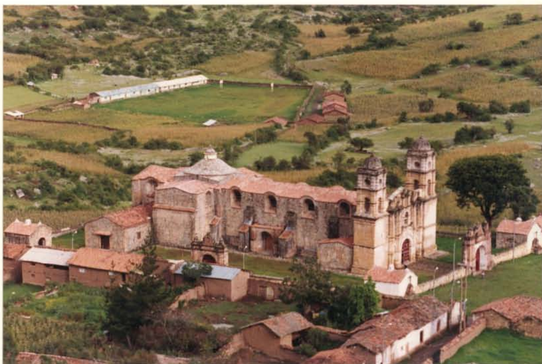
24-E EL PORTICO Y LAS TORRES DEL SANTUARIO MUESTRAN DETE- RIORO DE SUS ELEMENTOS LITICOS QUE SON MONTABLES Y SOBRE LOS QUE HAY QUE HACER INVENTARIO Y CALIFICACION DE SU ESTADO DE CONSERVACION.
