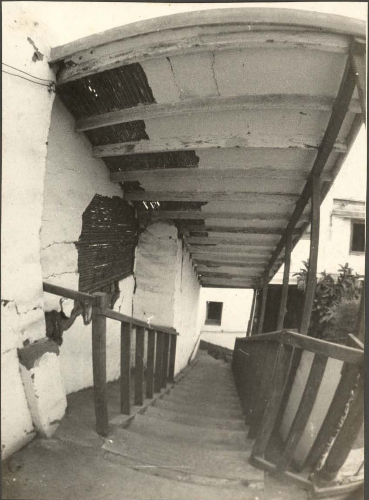
29.- Casa Mariscal Urbegodo- Escalera Agregada Segundo Patio
