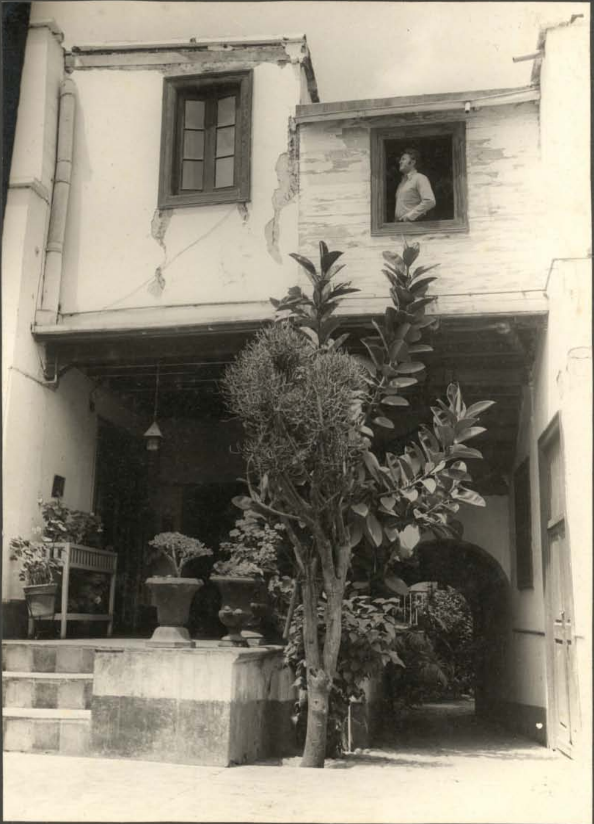
21.- Casa Mariscal Orbegoso- Agregados del segundo patio
