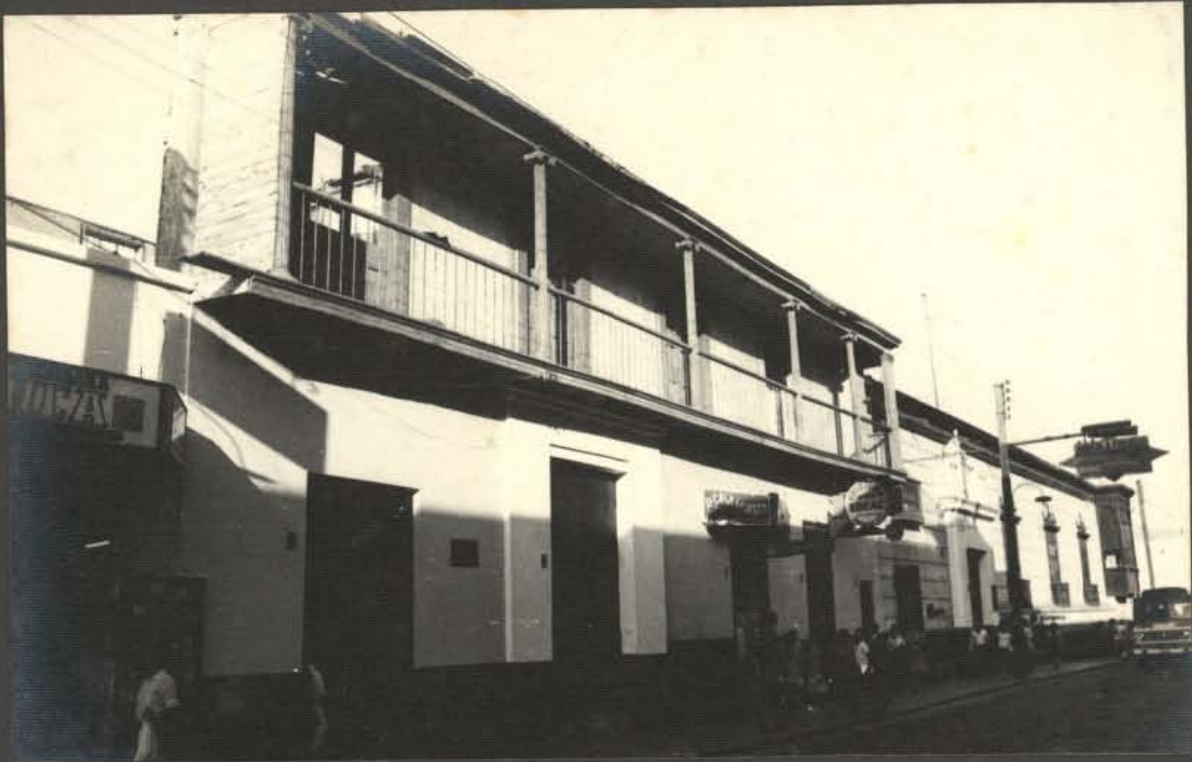
7.- Fachada de Antiguo Hotel "Italia" y Casa del Mariscal Frente calle Mariscal Orbegoso
