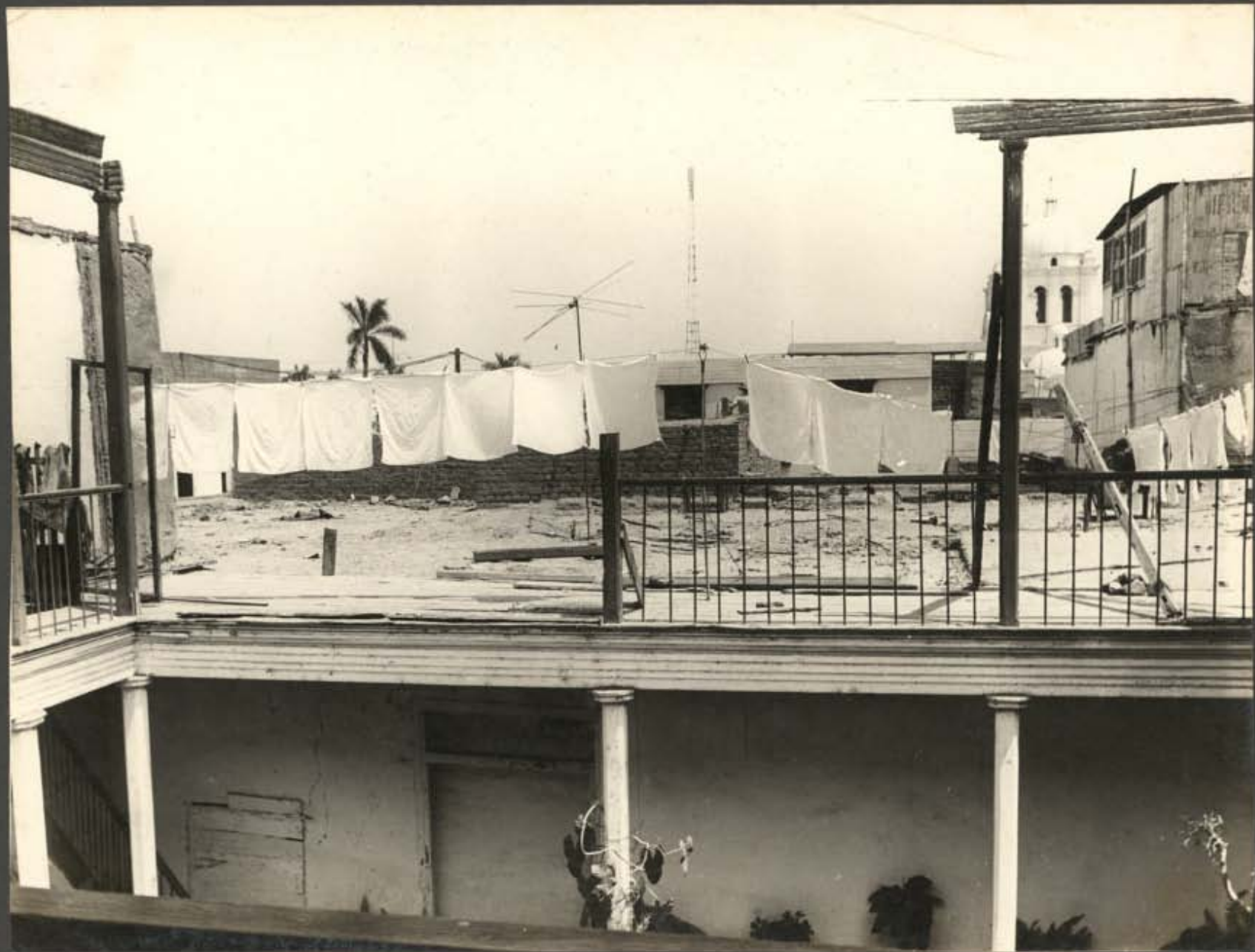
30.- antiguo hotel "Italia"- ratio- estado actual de los Corredores.
