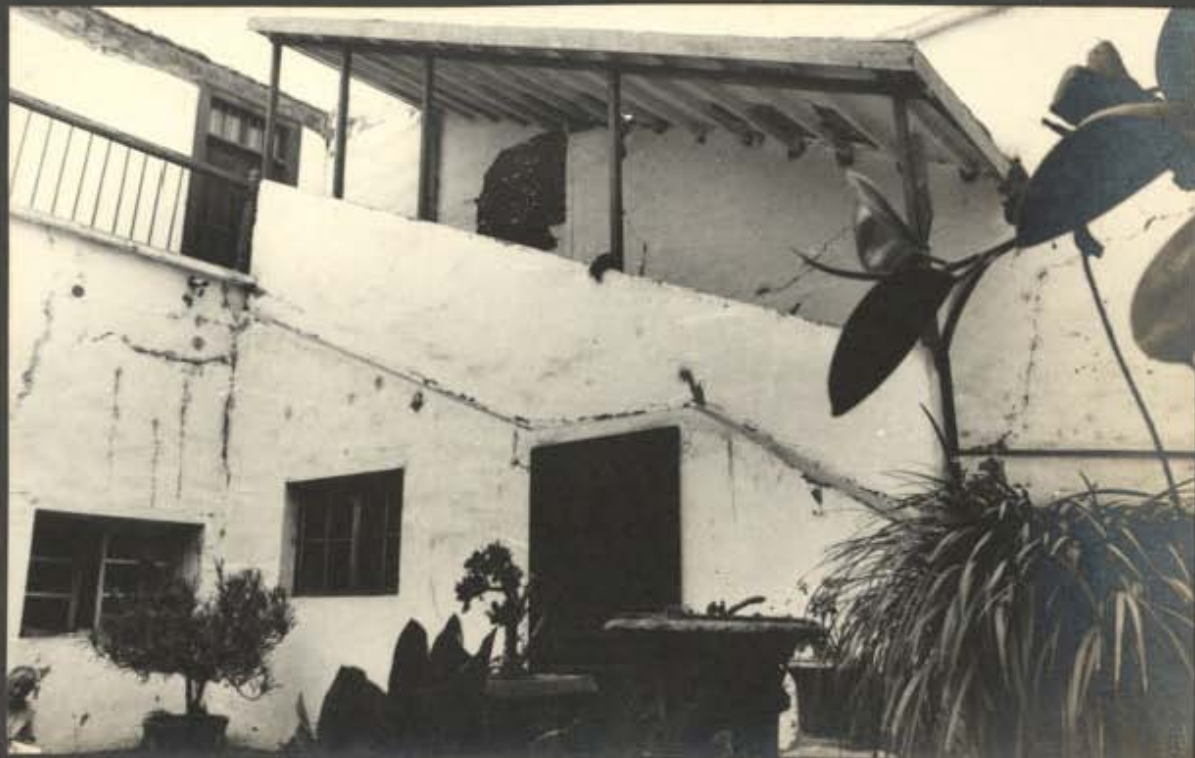
20.- casa Mariscal Orbegoso- Agregados del segundo patio
