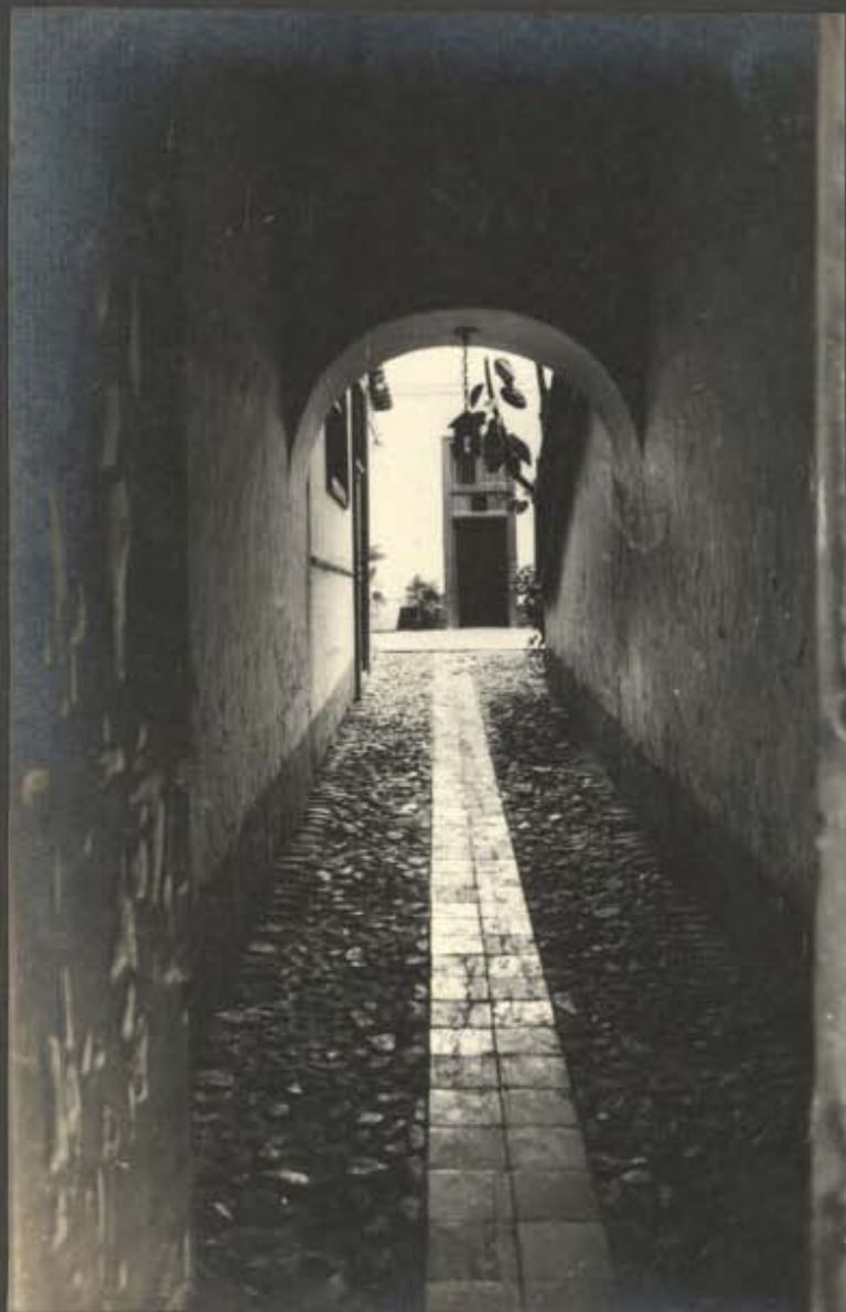
19.- casa Mariscal Orbegoso- Callejón- Al fondo segundo patio
