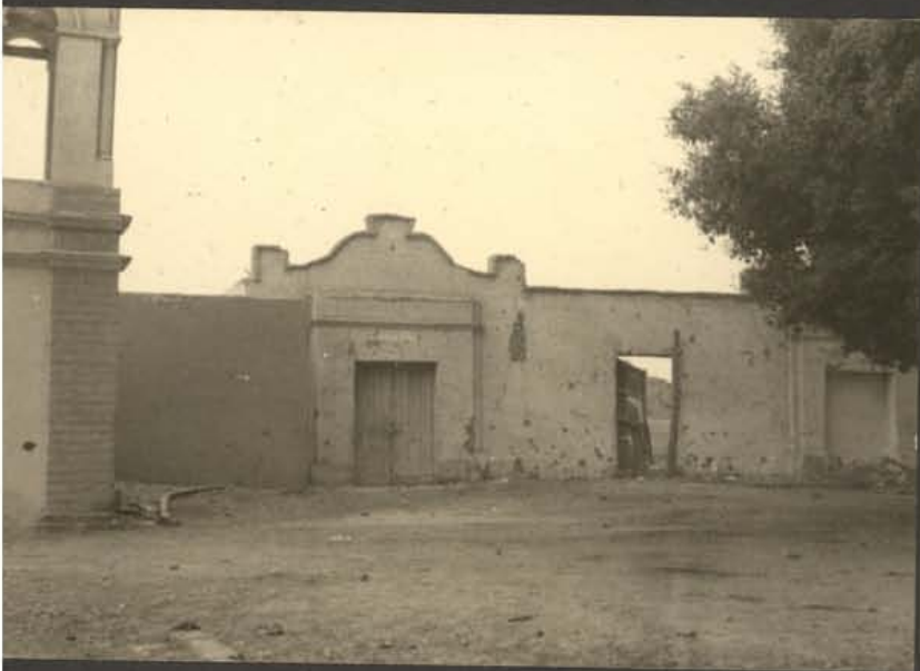
Casa Hacienda Sta. Rita de Tacaraca Dist. de Santiago- ICA
