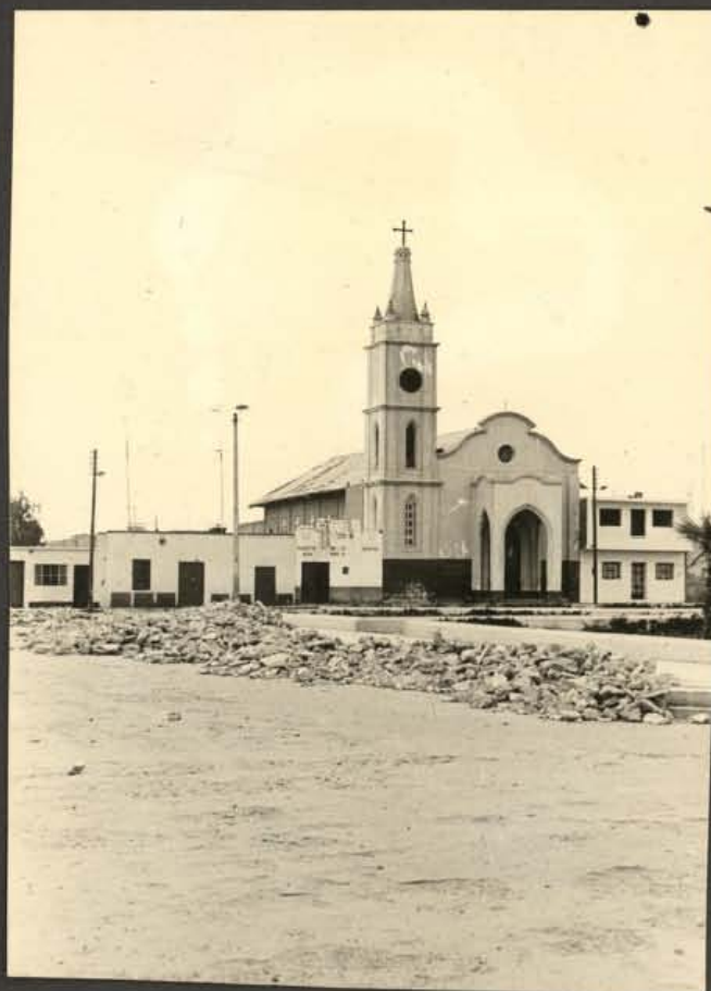
Iglesia del Puerto de SAN ANDRES Pisco -ICA
