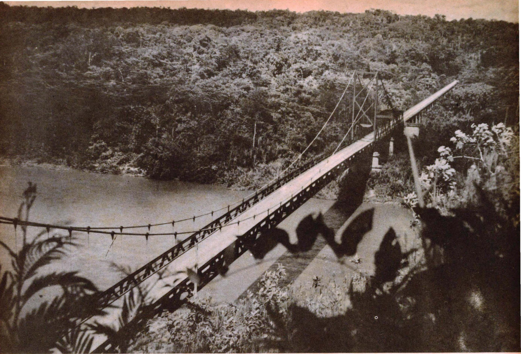
Puente metálico sobre el Río Aguaytía. Departamento de Loreto, Selva
