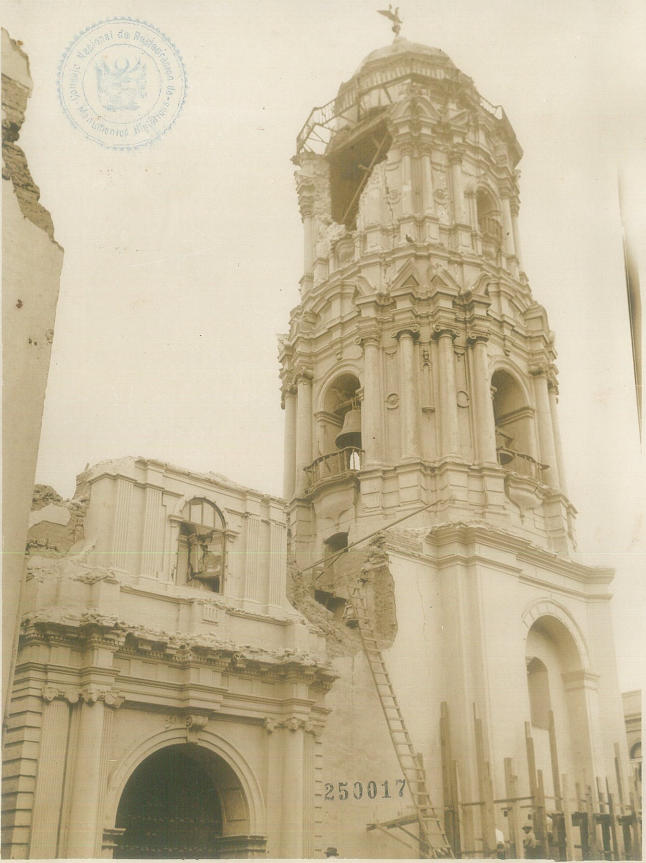
IGLESIA DE SANTO DOMINGO.- Lima.- Vista general de uno de los frentes de la torre, tal como quedó después del terremoto de 1940.- Foto: ( ? )
