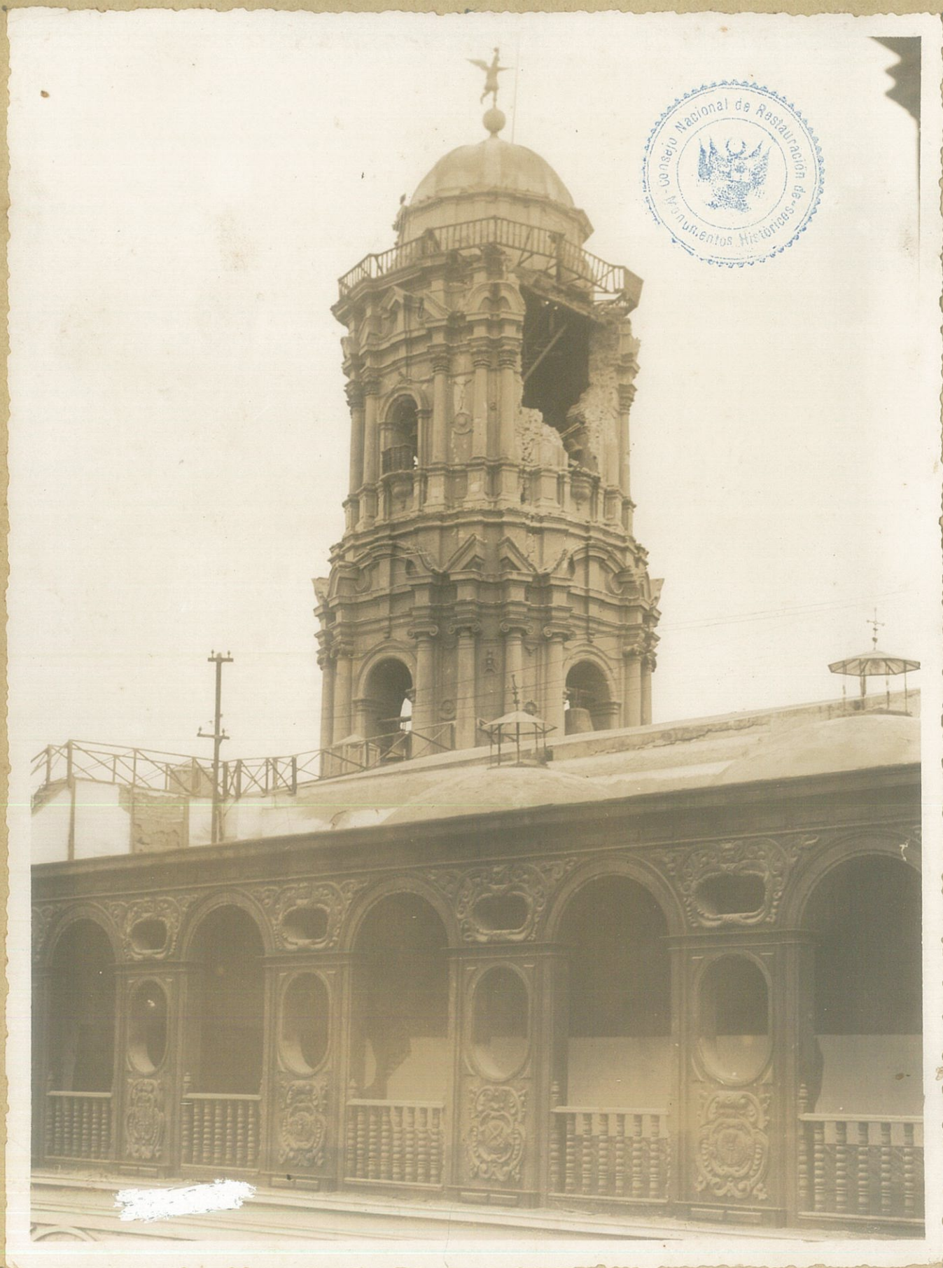
IGLESIA DE SANTO DOMINCO.- Lima.- Vista parcial de la torre tomada desde el primer claustro del Convento (observe los desperfectos causados por el terremoto de 1940).- Foto: ( ? )
