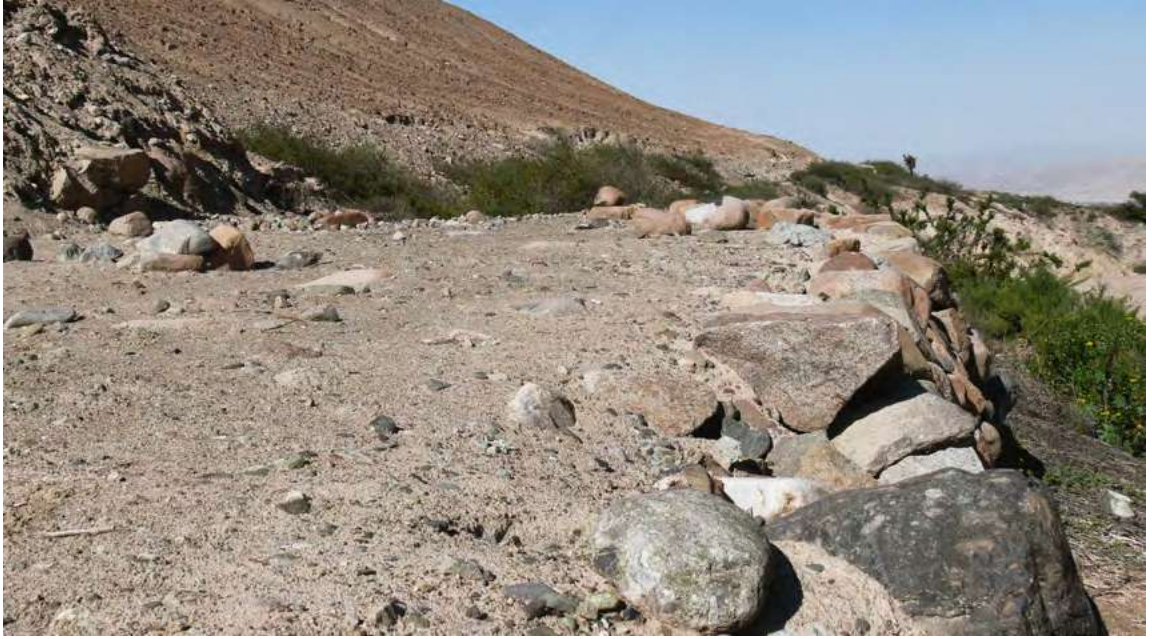
Foto 2. Vista del tramo Miculla – Apacheta. Cota: 1580 m s. n. m., vista este-oeste. El camino presenta un ancho promedio de 5 metros.
