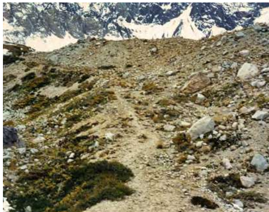
Foto 3. Contrafuerte construido para sustentar el camino inka en un segmento de la "Cuesta del Inca".
