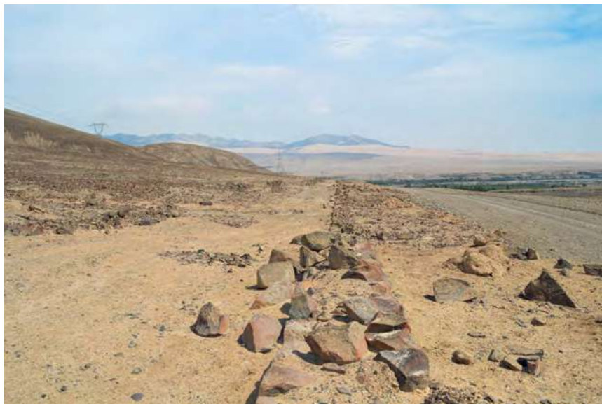
Foto 32. Detalle de muro del camino en Quebrada Río Seco, Pisco, Ica.
