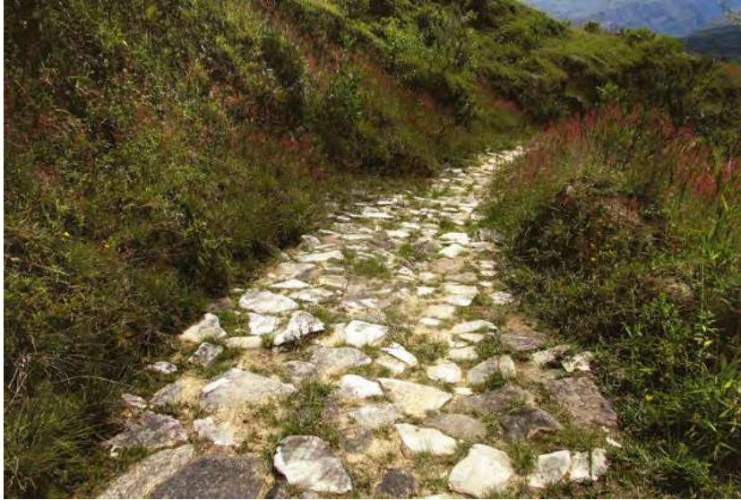
Foto 2. Desplazamiento del camino empedrado del Sub-tramo Levanto - El Molino - Chachapoyas.
