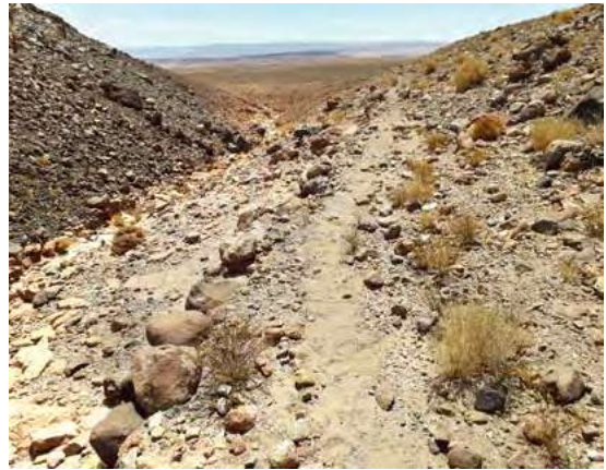
Foto 10. El camino “La Mano Derecha de Atacama” se angosta al ingresar al cordón de Loma Negra, adoptando la forma de una calzada de menos de 1 metro de ancho con nivelación de talud, muro de refuerzo y relleno interior.
