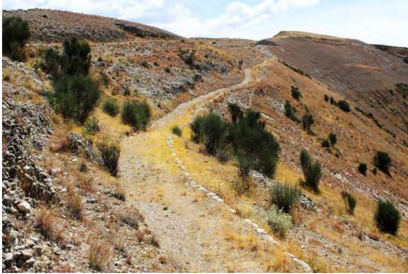
Foto 1. Segmento de la sección de camino Hatun Xauxa-Hatun Chaka entre los sitios arqueológicos de Chucchu y Puywan, después de los trabajos de conservación ejecutados por el Proyecto Qhapaq Ñan-Sede Nacional.
