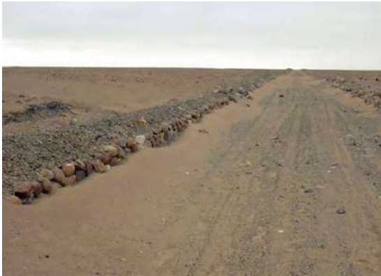
Foto 20. Vista del muro lateral construido para evitar arenamientos en Pampa de Layagache – Caplina (Archivo Proyecto Qhapaq Ñan).
