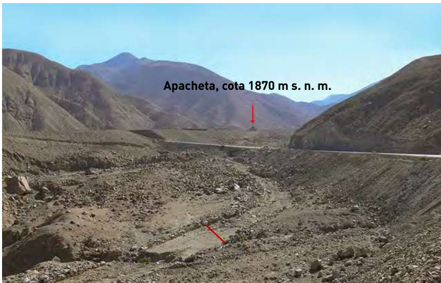
Foto 3. Vista del tramo Miculla – Apacheta. Cota 1845 m s. n. m., vista este-oeste. El camino presenta un ancho promedio de 6,5 metros.
