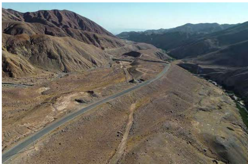
Foto 1. Foto obtenida con drone del tramo Miculla. Cota: 1565 m s. n. m., vista este - oeste (Proyecto Qhapaq Ñan, Ministerio de Cultura del Perú. Agosto 2019).
