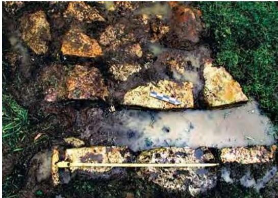
Foto 3. Subtramo Levanto - El Molino - Chachapoyas. Alcantarilla de drenaje, tipo abierto.
