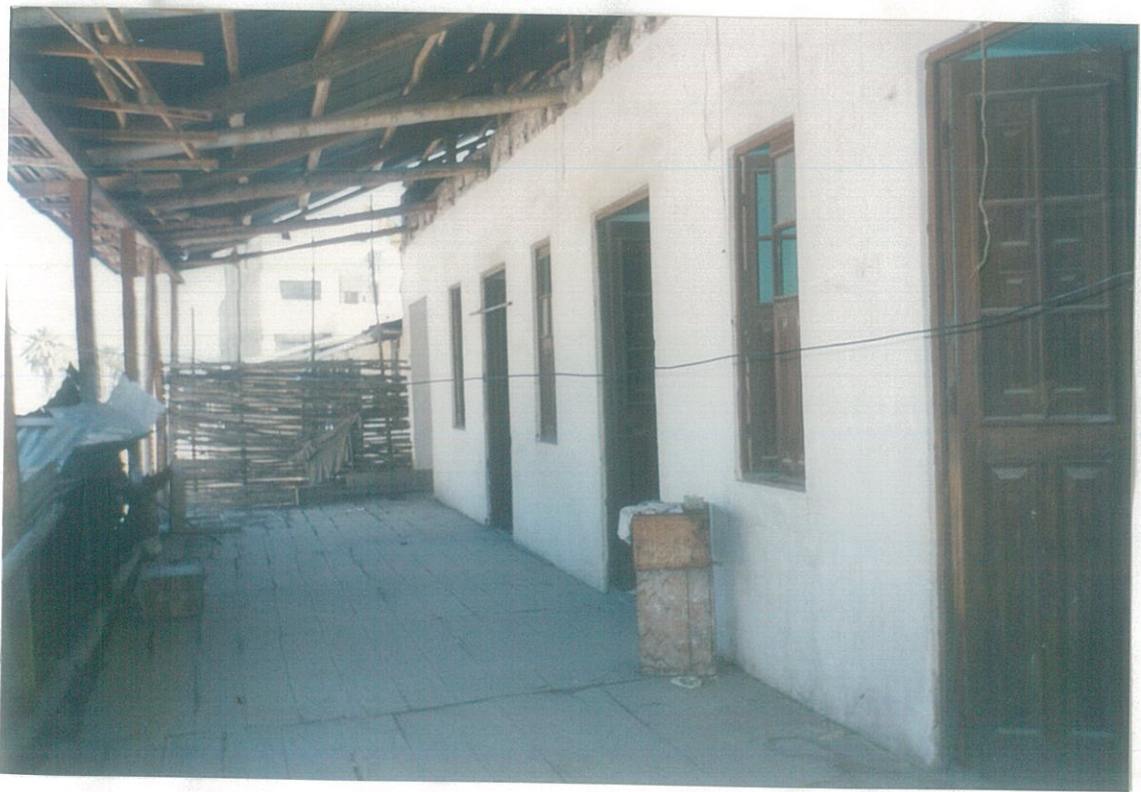
F10 HALL CORRESPONDE A LA VIVIENDA PISO DE MADERA
