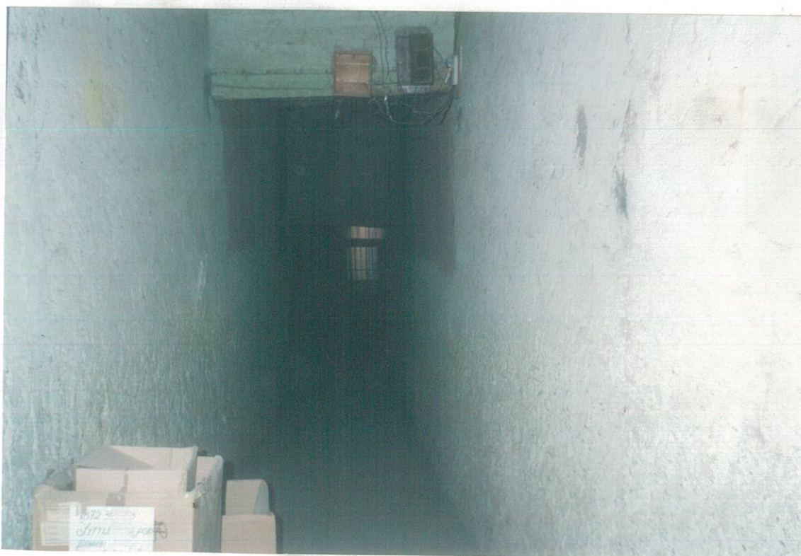
F8 UNO DE LOS AMBIENTES DE ACCESO AL SEGUNDO NIVEL
