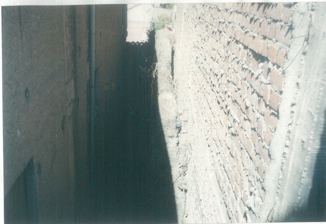
F7 PARED SECTOR OESTE Y CORREDOR EN UN LONGITUD DE 40M.L.
