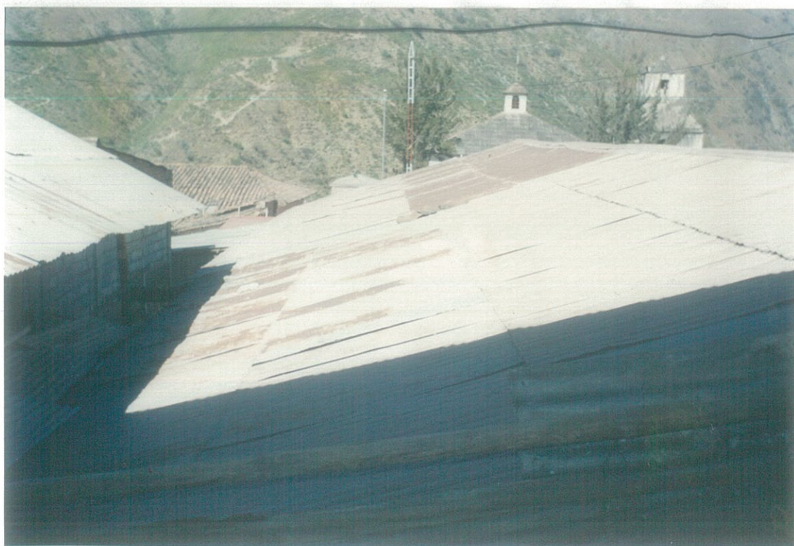
F22 COBERTURA ACTUAL DE DOBLE AGUA SECTOR DEL CINE TEATRO VISTA DESDE EL HALL DE LA VIVIENDA
