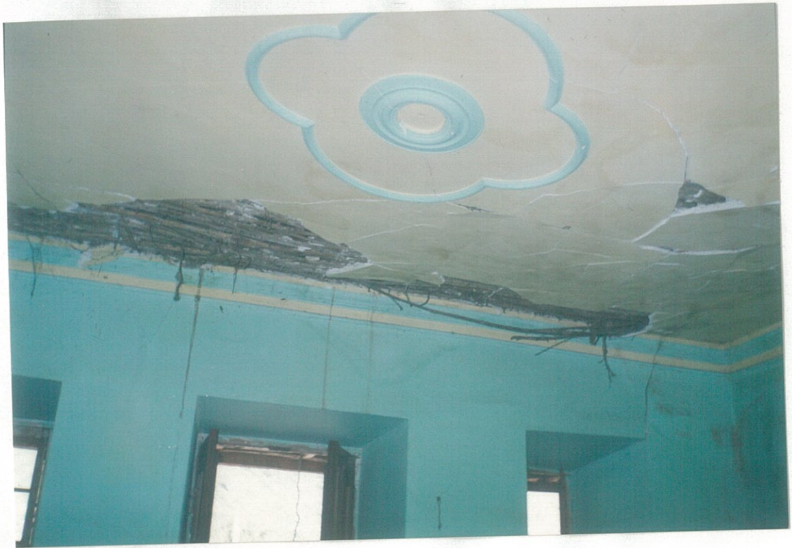
F 17 TECHO ORIGINAL DE LA VIVIENDA
