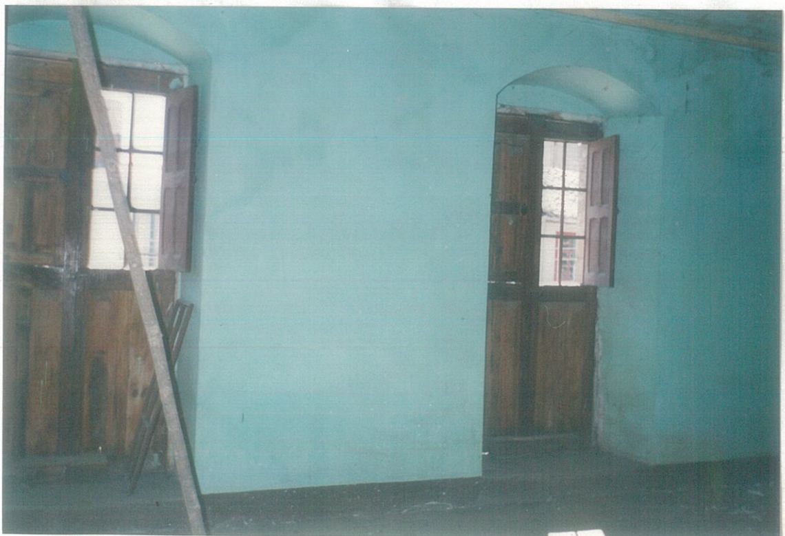
F 12 SECTOR INTERNO DE LA VIVIENDAS CORRESPONDEN A DORMITORIOS
