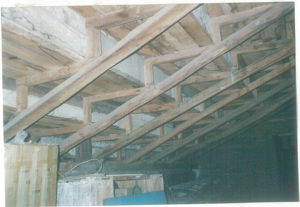
F 18 CONSTRUCCIONES DE MADERA DE LA GALERIA SOPORTE
