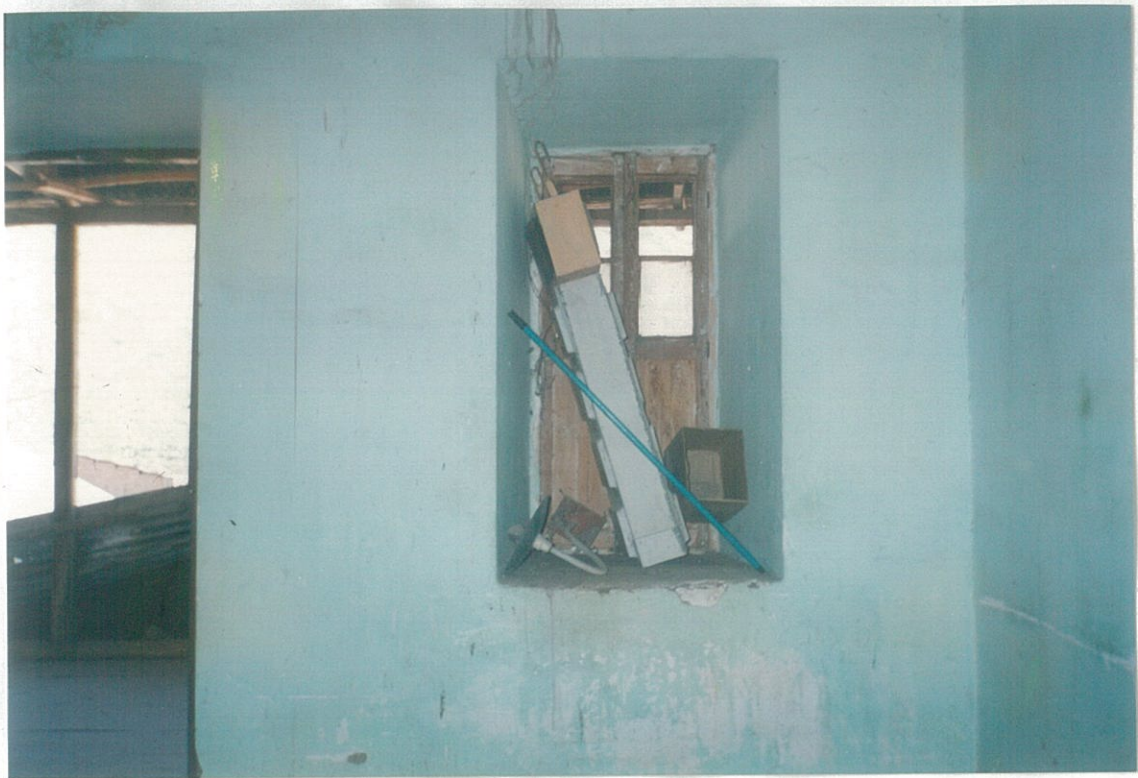
F 11 SECTOR INTERNO DE LA VIVIENDA : PUERTA Y VENTANA
