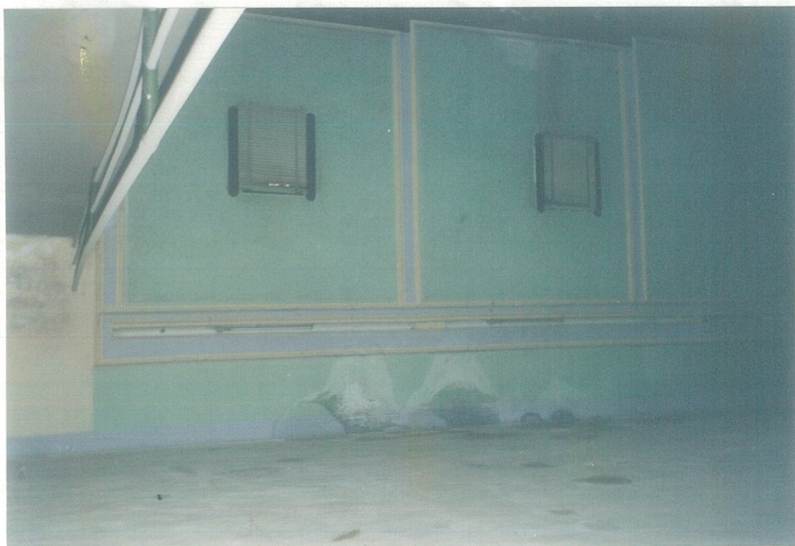
F14 SECTOR INTERNO DE LAS PAREDES DE SALA DEL CINE Y TEATRO
