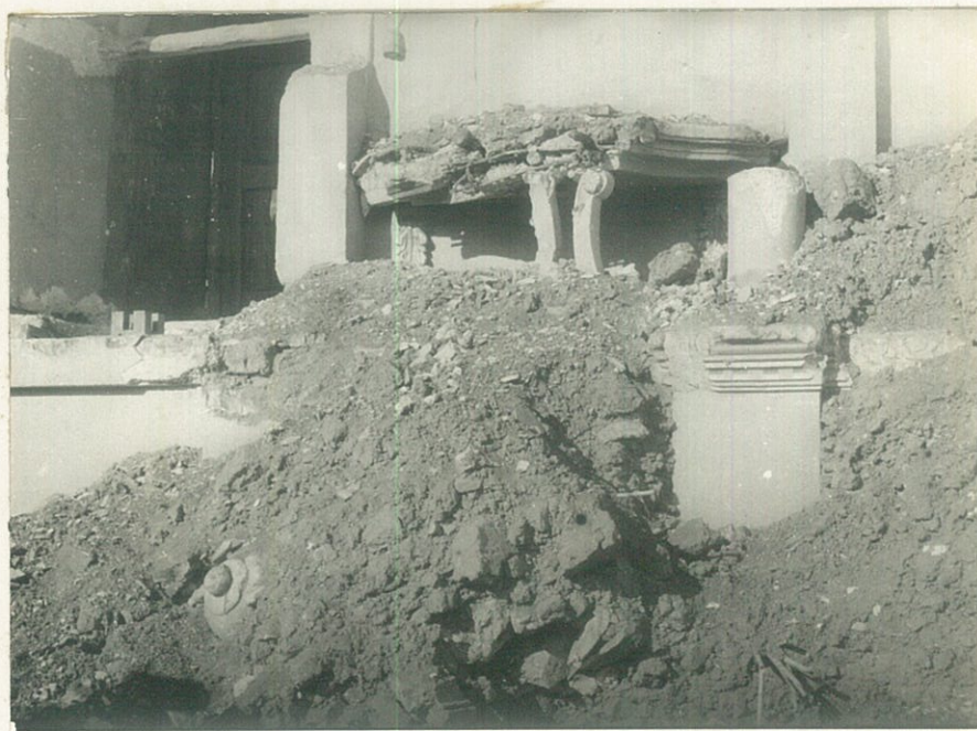
Detalle de la destrucción de la parte inferior derecha del muro testero.
