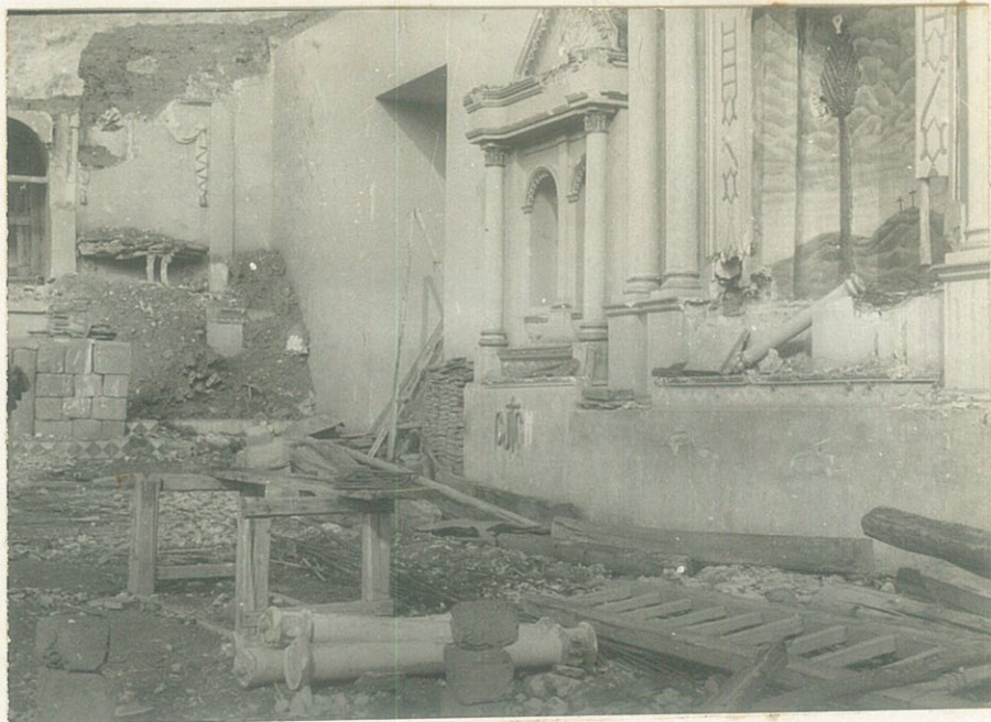
El muro norte y parte del muro testero totalmente destruido.
