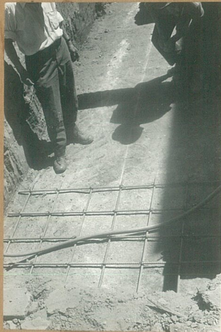
CIMENTACION TIPICA DE OBRA NUEVA EJECUTA- DA POR LA PRELATURA.
