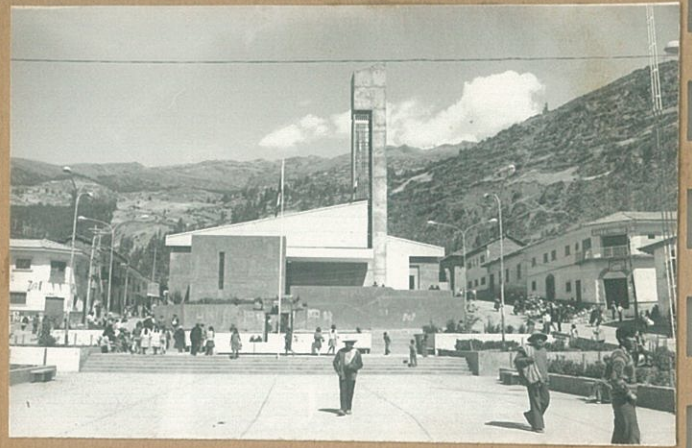
VISTAS DE LA CATEDRAL DE HUARI CONSTRUCCION DE OBRA NUEVA.
