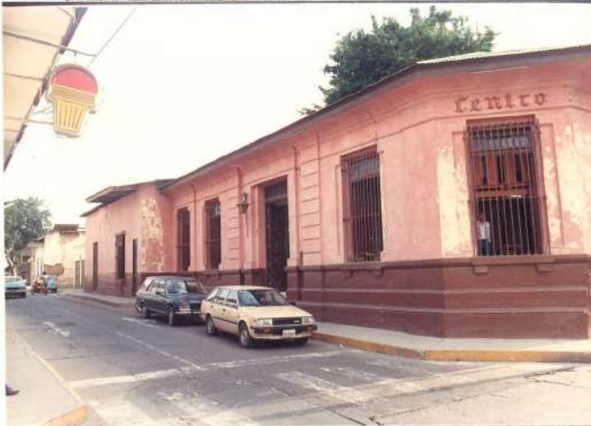
Vista de la fachada principal en el jr. Libertad
