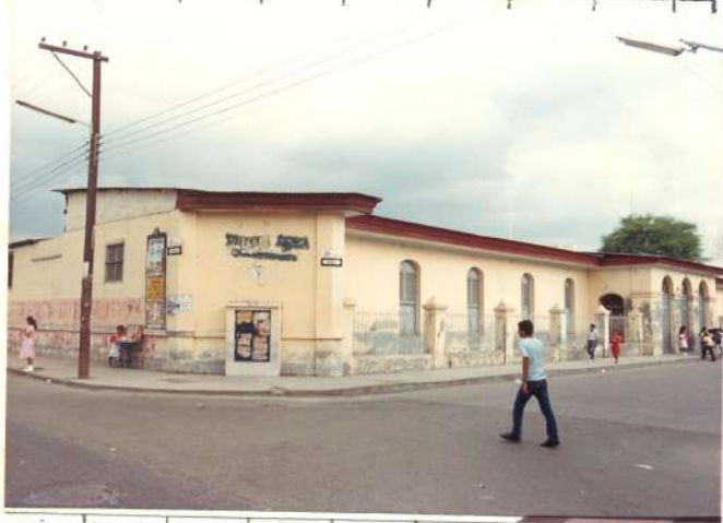
Vista de la fachada, avenida Sanchez Cerro-Jirón Cusco.
