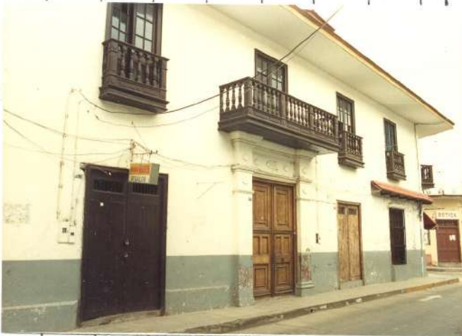
Vista de la fachada principal, Jirón Tacna
