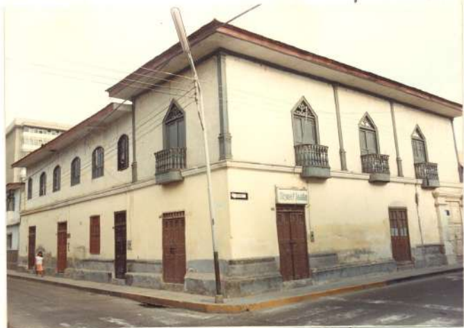
Vista completa de la fachada, calle Ayacucho.
