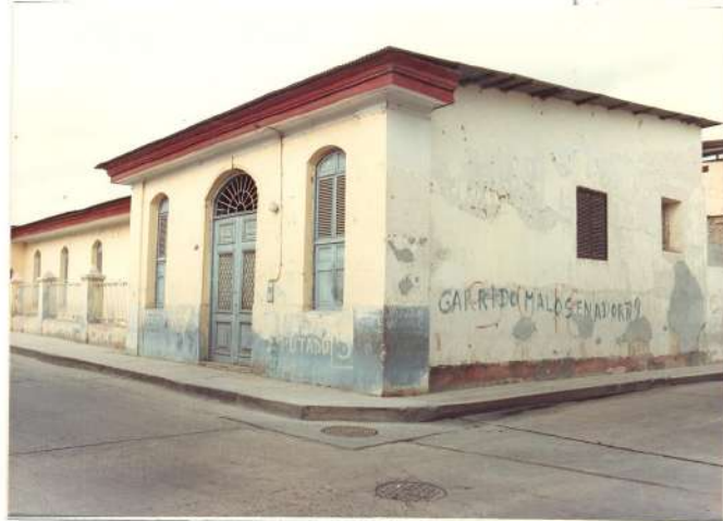
Vista de la fachada, jirón Cusco y jirón Huánuco.
