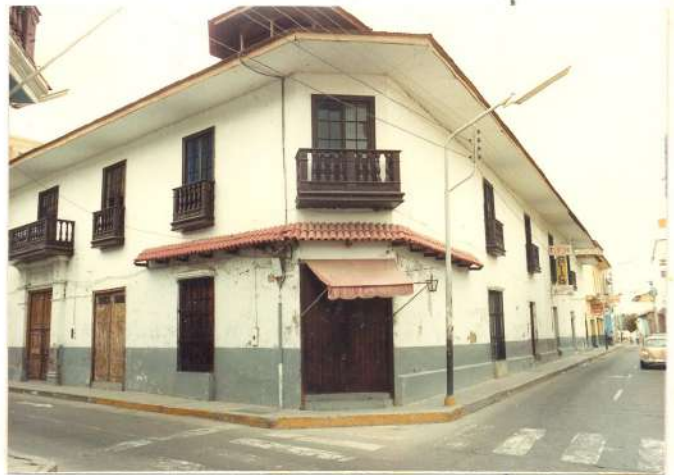
Vista de la fachada, jirón Callao
