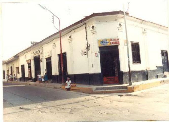
vista del inmueble con el jirón Ayacucho.
