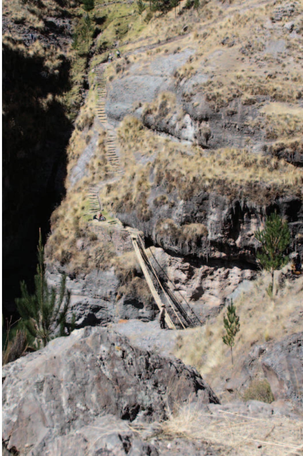
Panorámica del puente Q'eswachaka, provincia de Quehue, Cusco
