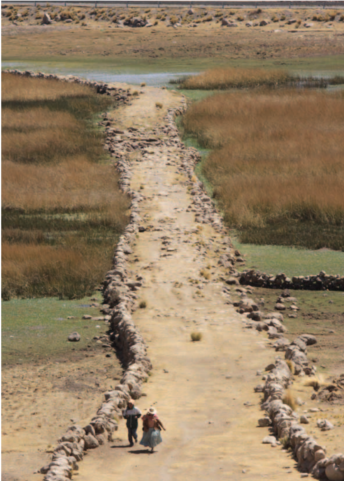
Calzada elevada a las orillas del Lago Titicaca, en Pomata, Puno | Tramo Cusco - Desaguadero (Bolivia)
