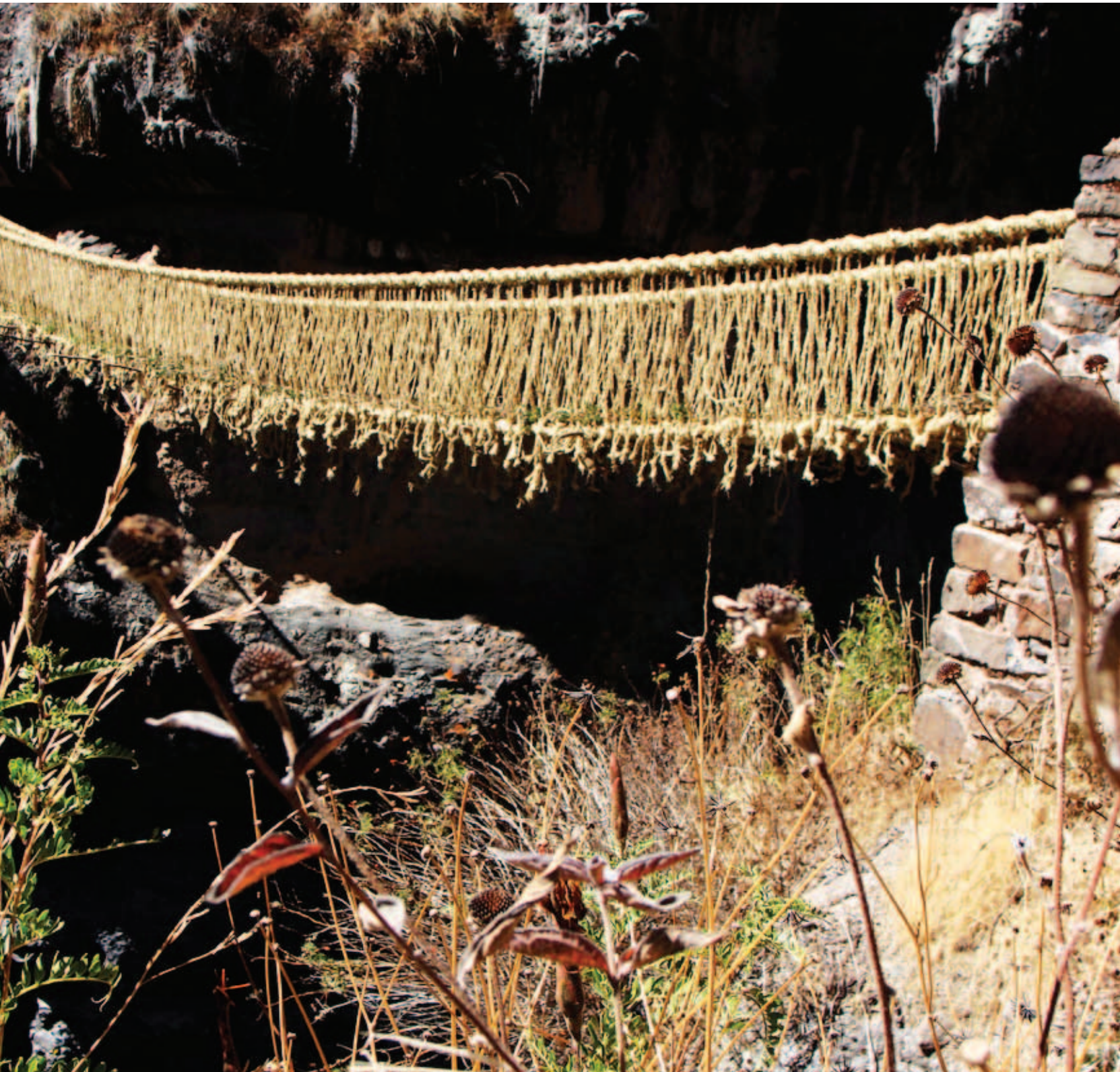
Puente colgante Q'eswachaka sobre el río Apurímac, provincia de Quechua, Cusco
