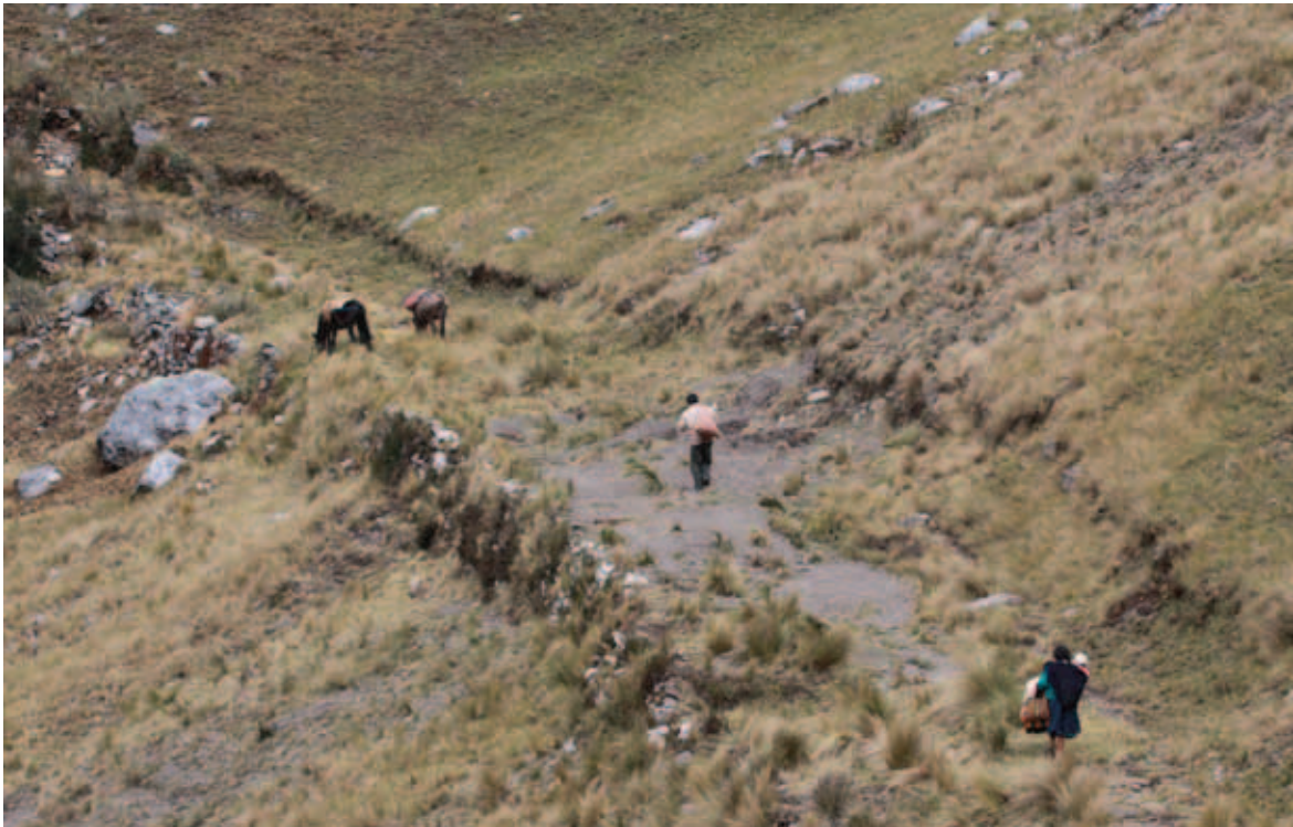
Camino con muro de contención, Cerro Huaylillas, provincia de Huamachuco, La Libertad | Tramo Huánuco Pampa - Huamachuco
