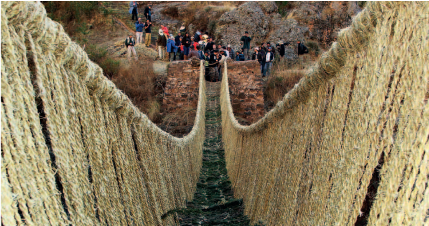
Puente colgante terminado, distrito de Quehue, Canas, Cusco
