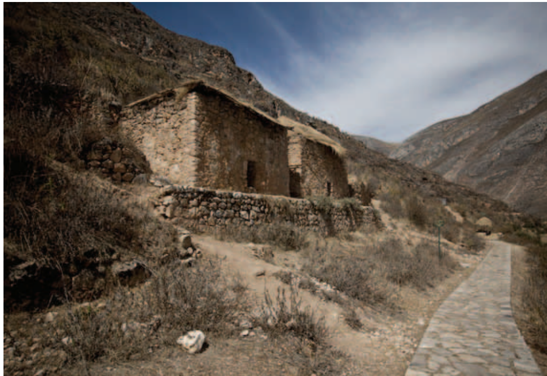
Kollcas , o almacenes en el sitio arqueológico Tarmatambo, Tarma, Junín | Tramo Acostambo - Huánuco Pampa
