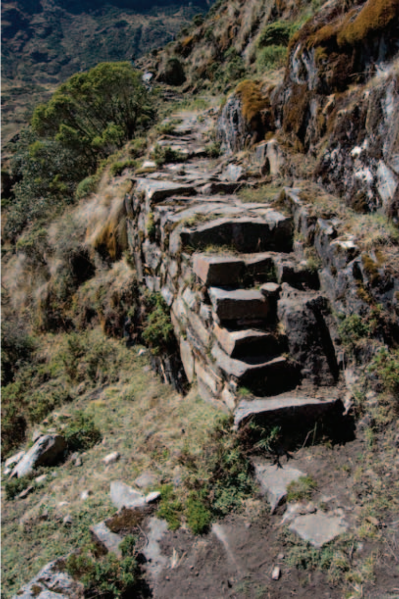
Caminos con muro de contención y escalinatas, La Convención, Cusco | Tramo Vitkos - Choquequirao
