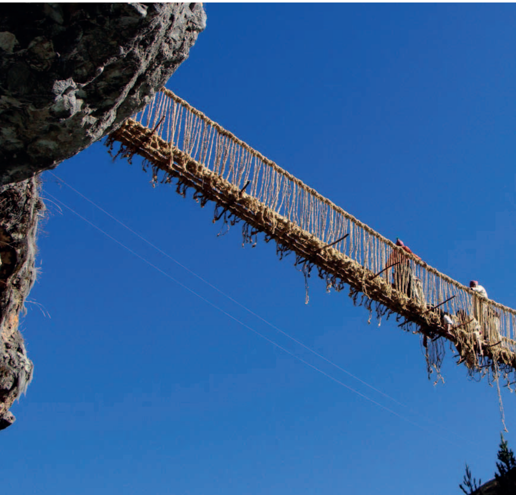
Chakaruwaq a punto de culminar el tejido del puente, distrito de Quehue, Canas, Cusco
