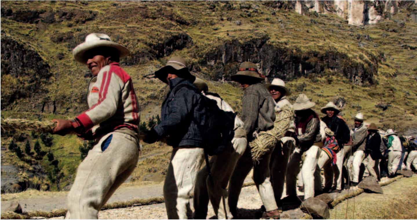
Comuneros en primer día de construcción del puente colgante Q'eswachaka, distrito de Quehue, Canas, Cusco
