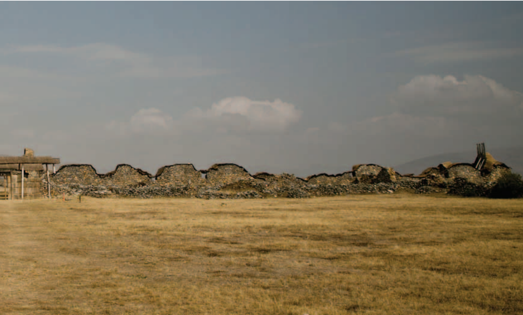
Sitio arqueológico Huánuco Pampa, La Unión - Huánuco. Se puede apreciar parte de los trabajos de restauración. | Tramo Huánuco Pampa - Huamachuco
