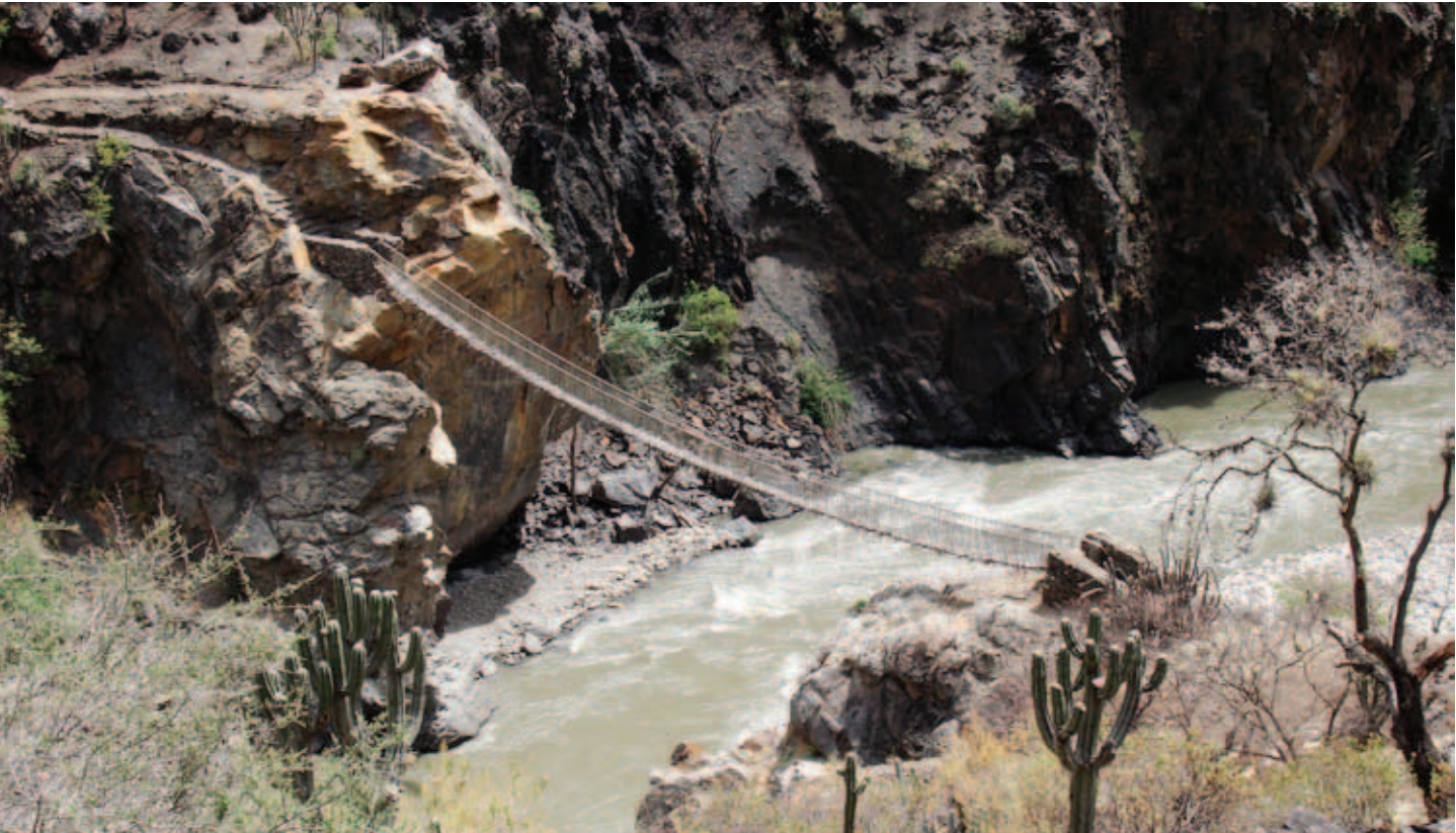
Puente Pukayaku sobre el río Yanamano, 42 metros de largo, provincia de Canrash, Áncash
