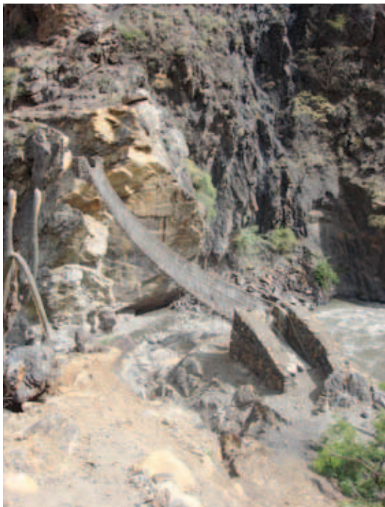
Puente Pukayaku elaborado con fibras vegetales, Canrash, Áncash
