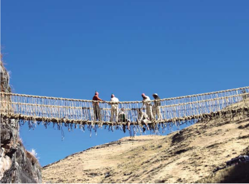
Ambos tejedores se encuentran a la mitad del puente, concluyendo así su labor.
