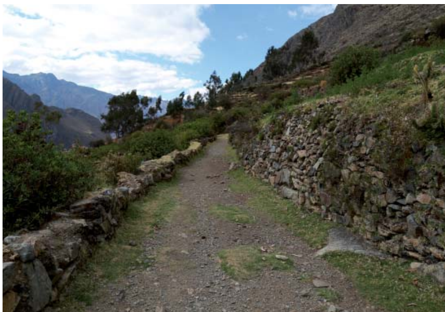
Camino Inca que conduce al complejo de Huamanmarca, en Yauyos, Lima. Nótese las lajas de piedra oscura, características de la región, usadas en sus construcción (imagen superior) y el muro de contención (imagen inferior)
