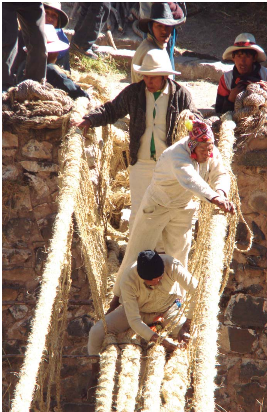
Tercer día. Los chakaruwaq suelen terminar la construcción del puente hacia la mitad de la tarde.
