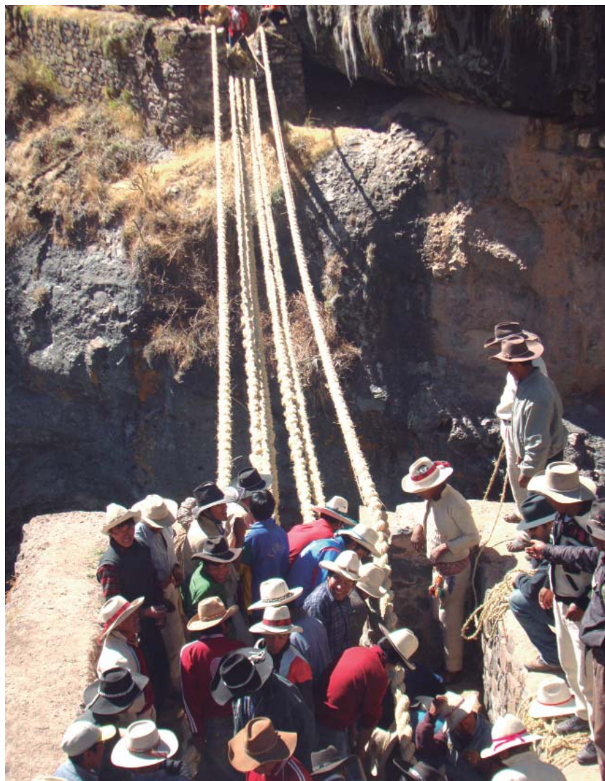
Segundo día. Es necesaria la participación de gran cantidad de comuneros para estirar y atar las sogas a los estribos de cantería del puente.
