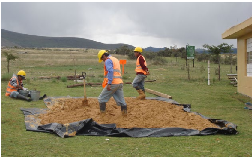
Preparación de nuevo mortero para las intervenciones de conservación de los muros incas. (Foto: Pino, 2008)
