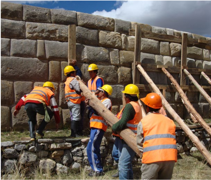
Trabajos de apuntalamiento de muros en riesgo de colapso.
