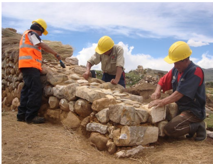
Comuneros de Aguamiro realizando trabajos de conservación en uno de los muros del Subsector IIB. (Foto: Castro, 2013)
