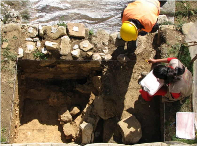
Trabajos de registro arqueológico en el ushnu. (Foto: Pino, 2007)
