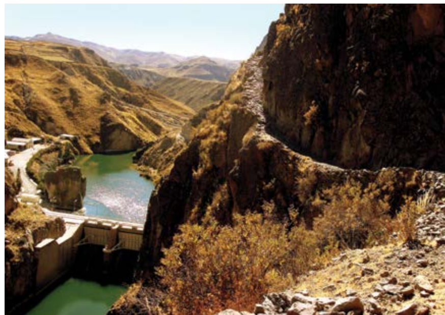
Figura 61. Camino con muro de contención. Se ha cortado el talud para habilitar la vía compuesta por un muro y escalinatas.
