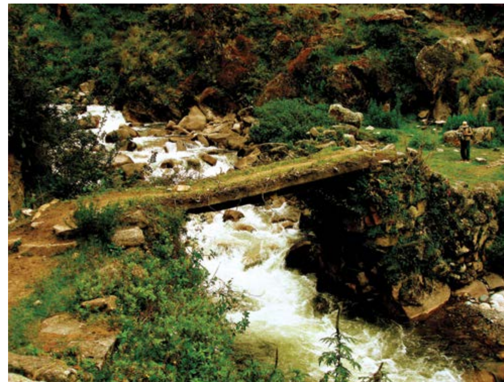
Figura 19. Puente de madera sobre estribos de piedras en quebrada Pumacancha. Tramo Chupaca - Tupe (foto por T. Campos).
