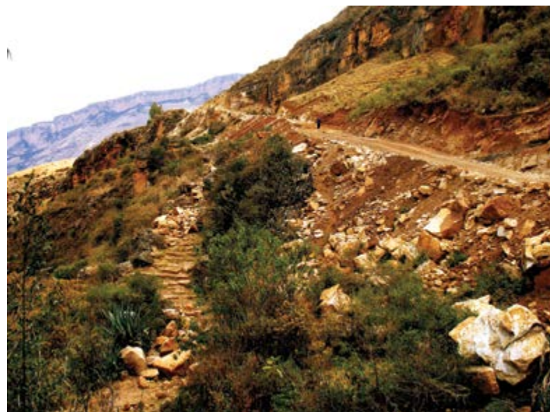
Figura 79. El desmonte generado por la construcción de la carretera ha sepultado y cortado parte del camino en el tramo Ticapampa - Paucas. Paucas, Huari, Ancash (foto por A. Bar).
