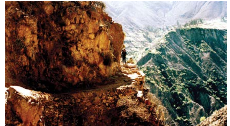
Figura 36. Camino transversal tallado en la roca con muro de contención en la quebrada Infiernillo, Tupe, Yauyos. Tramo Tupe - Catahuasi (foto por M. Cabrera 2004).
