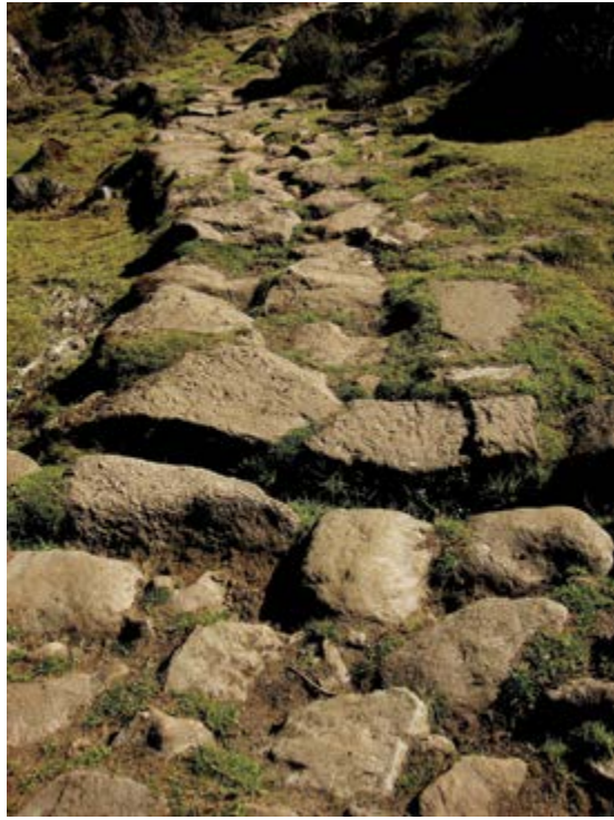
Figura 64. Camino empedrado y canal superficial. Tramo Jauja - Monobamba, subtramo Quero - Curimarca, Junín (foto por T. Campos).
