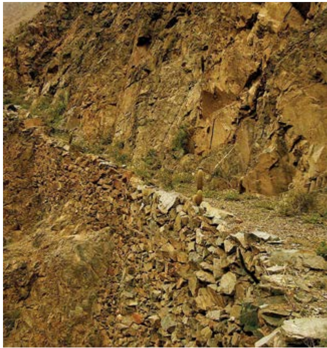
Figura 60. Camino con muro de contención en Antioquia, valle de Lurín. Tramo Xauxa - Pachacamac. (foto por G. Casaverde)
