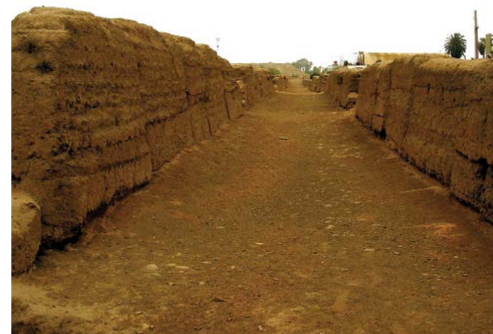
Figura 29. El camino con muros laterales de tapia dentro del campus de la Pontificia Universidad Católica del Perú, Lima. El camino se dirige hacia la Huaca Tres Palos en el Parque de Las Leyendas (foto por F. Ugaz).
