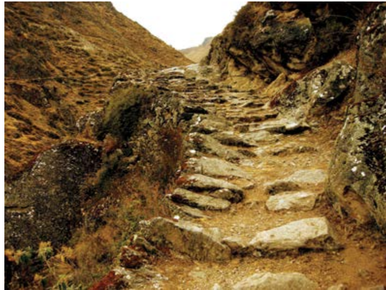
Figura 69. Camino excavado en roca con muro de sostenimiento de plataforma y escalinata (archivo Proyecto Qhapaq Ñan)
