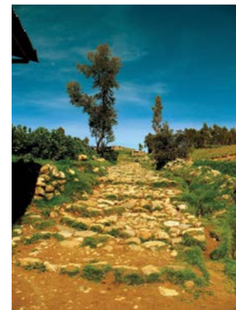
Figura 63. Camino empedrado y cerco lateral de piedras. Tramo Huaraz - Casma. Independencia, Huaraz, Ancash (foto por A. Bar).
