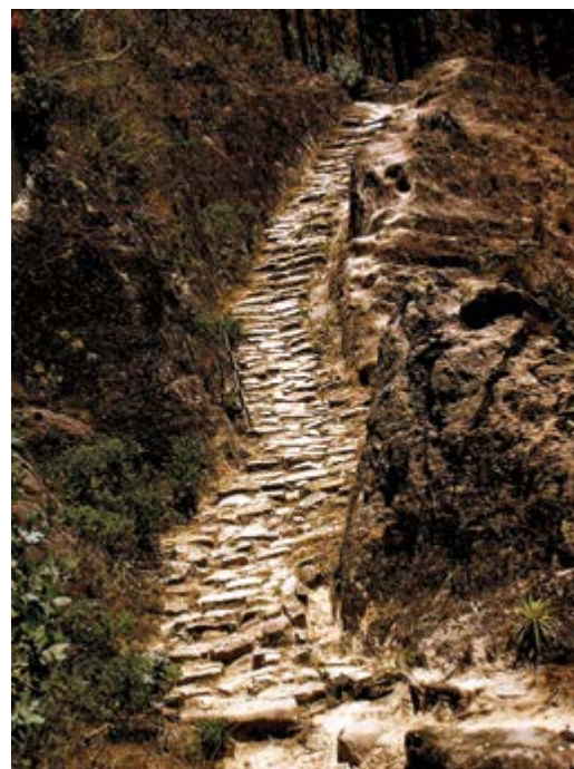
Figura 70. Camino escalonado excavado en roca entre Cundechaca y Levanto, Amazonas (foto por M. Montoya).
