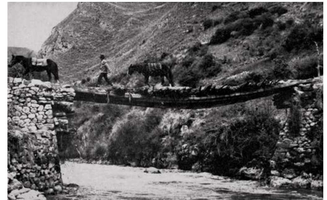
Figura 20. Puente de troncos sobre bases de piedra en Huánuco (Thompson y Murra).
