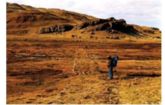
Figura 72. Calzada elevada y empedrada con canales superficiales que atraviesa un bofedal en la provincia de Oyón, Lima. Tramo Huayllay - Huaral (foto por M. Cabrera).
