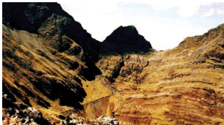
Figura 12. Camino con muro de contención en ladera del cerro Huaylillas, Santiago de Chuco. Tramo Huánuco Pampa - Huamachuco (foto por J. Fernández).
