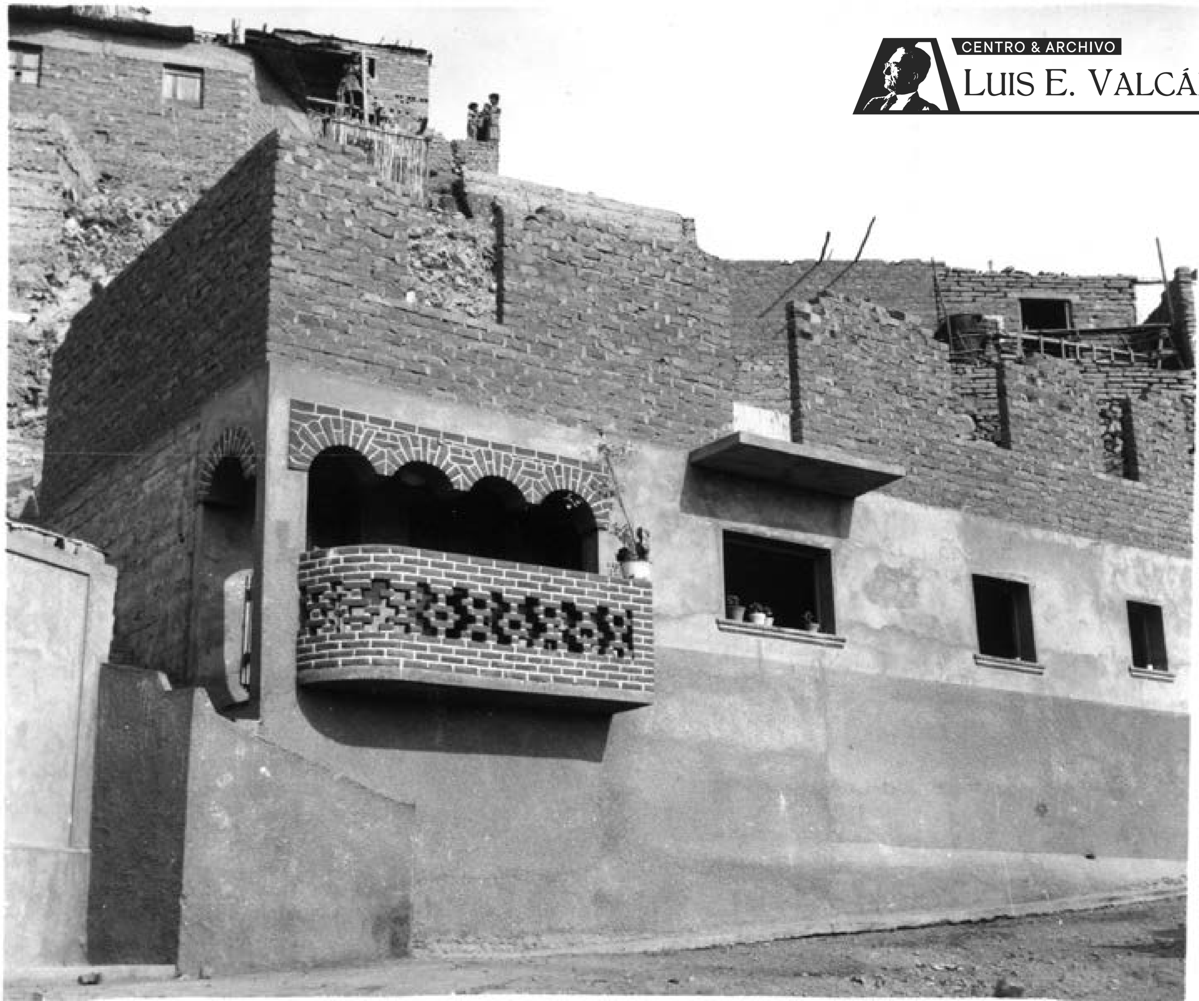
Balcón de ladrillos
