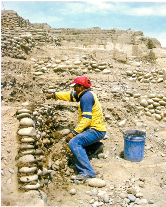
Trabajos de conservación ■
