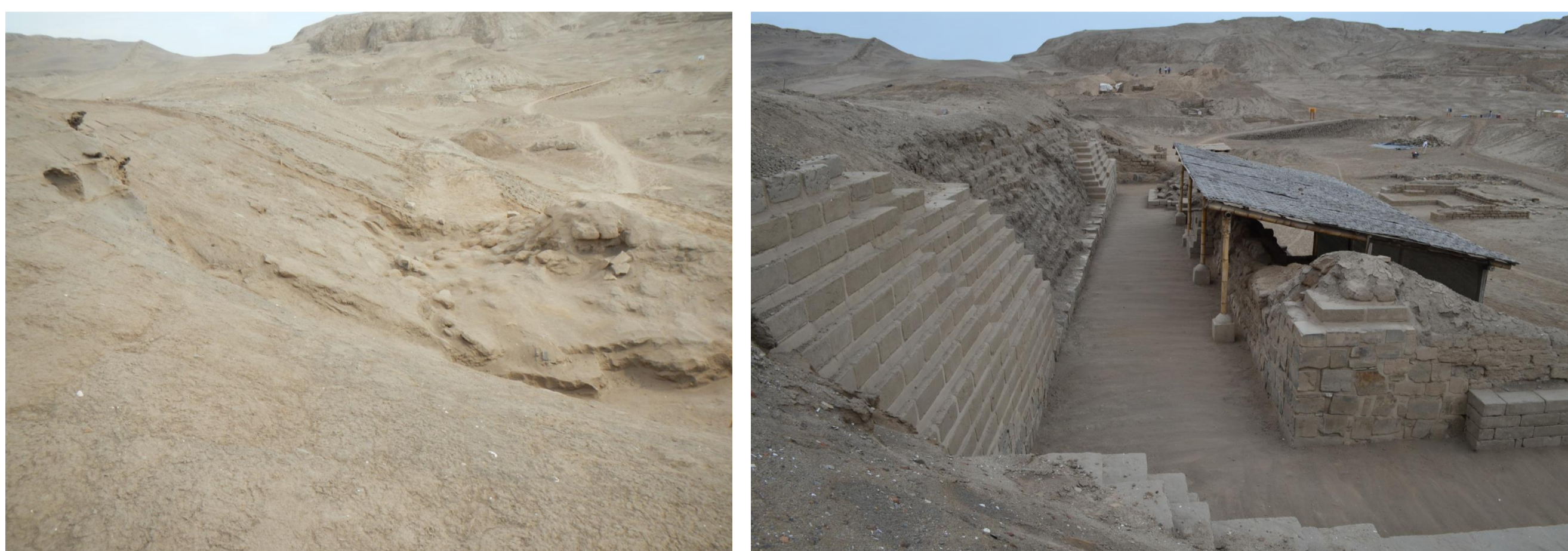
Trabajos de conservación del Pasadizo este; antes y después de las intervenciones
