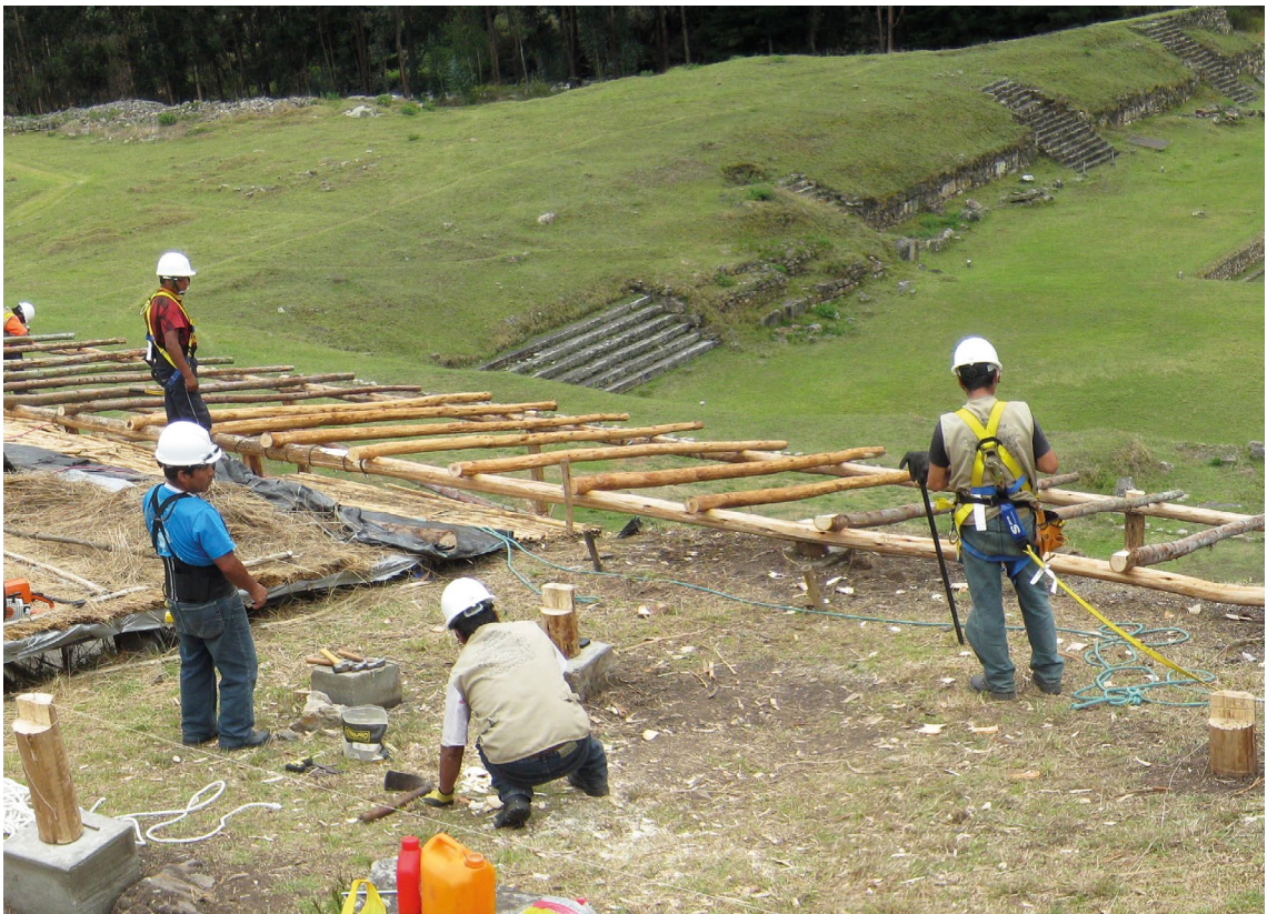
➤ Colocación de cobertura en Sitio Arqueológico Chavín
