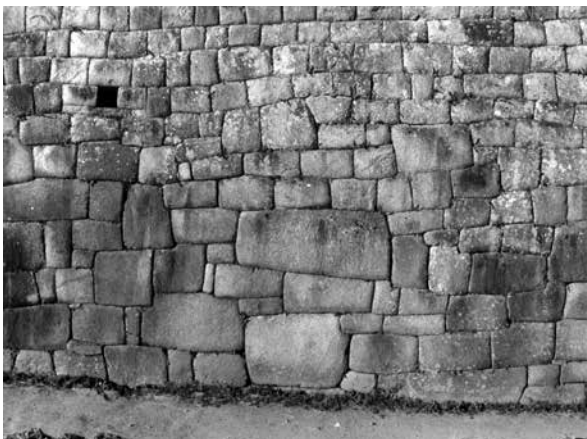
Figura 20. Salidas de drenaje del sector urbano situadas en 129 lugares en todo Machu Picchu; ellas aseguraban la buena eliminación de la escorrentía. La salida de drenaje de la izquierda está en el Muro de los Artesanos.
