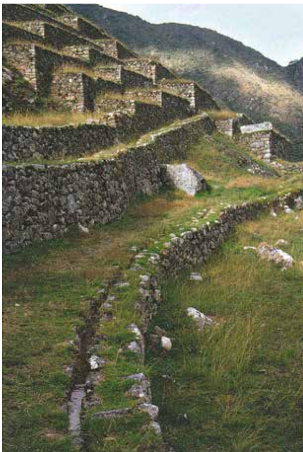
Figura 10. Canal principal conduciendo agua desde la fuente natural hacia el complejo de palacios de Machu Picchu (fotografía: Richard L. Burger).
