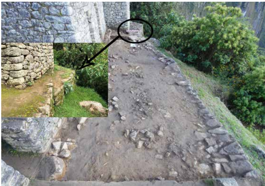
Figura 17. Vista general de la UE20, donde se observa una modificación estructural que corresponde a una segunda etapa del proceso constructivo.
