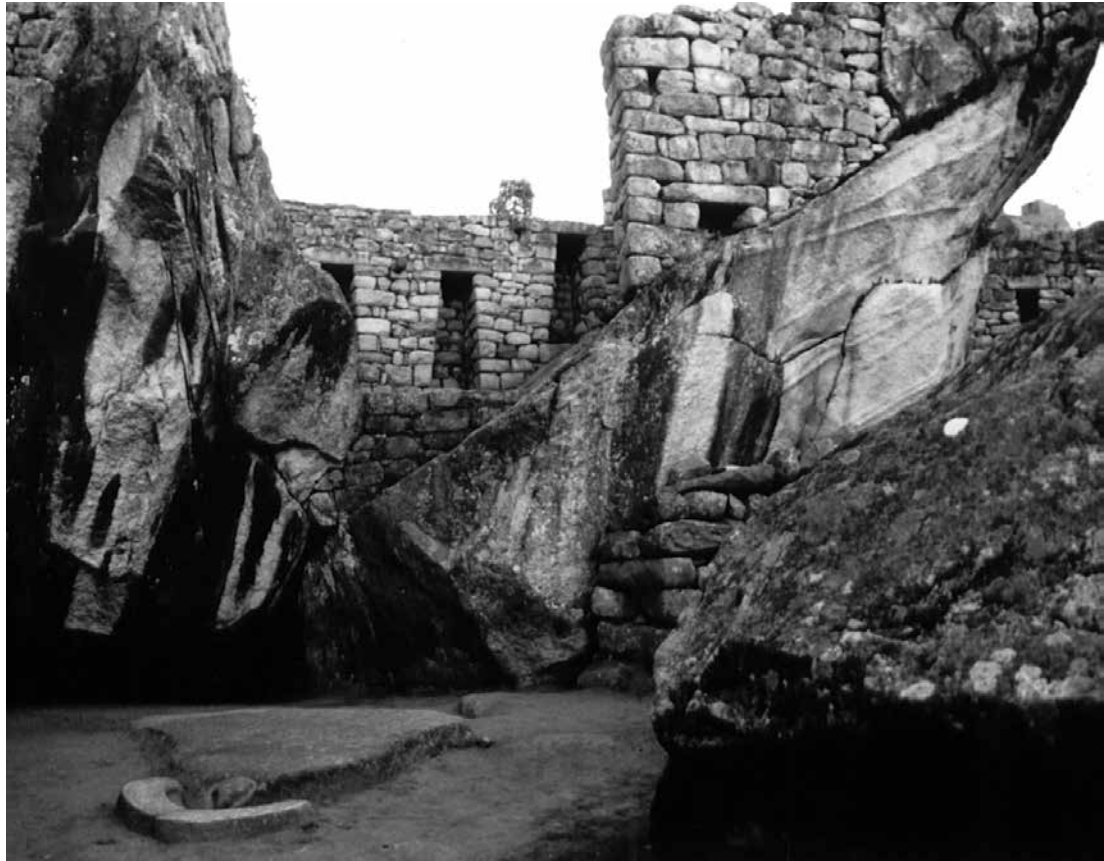
Figura 11. La integración de rocas de granito natural y de murallas de piedra cuidadosamente construidas en el Templo del Cóndor tiene el aspecto de grandes alas. Muchos visitantes de la actualidad hallan al templo especialmente importante por la existencia, en ese lugar, de cavernas subterráneas, nichos y varios cuartos.
