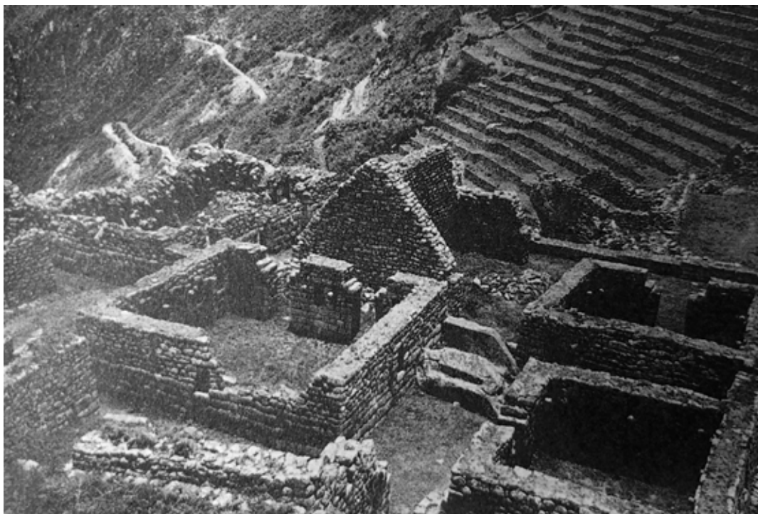
Figura 3. Grupo 9. Barrio Ingenioso antes de los trabajos de restauración.
