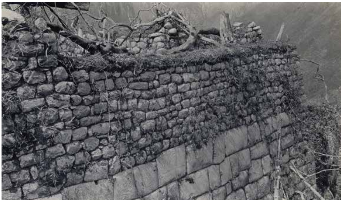
Figura 3. Muro del conjunto 35, donde se aprecia la diferencia entre los mampuestos del muro (fotografía: EPY; cortesía de la National Geographic Society).
