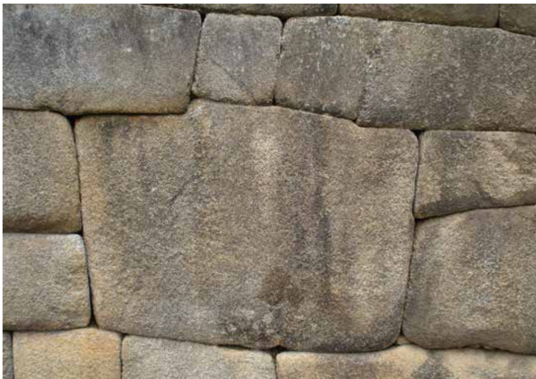
Figura 14. Detalle del paramento del muro anterior: líticos de textura granular que muestran la optimización del uso de rocas de diferentes tamaños.
