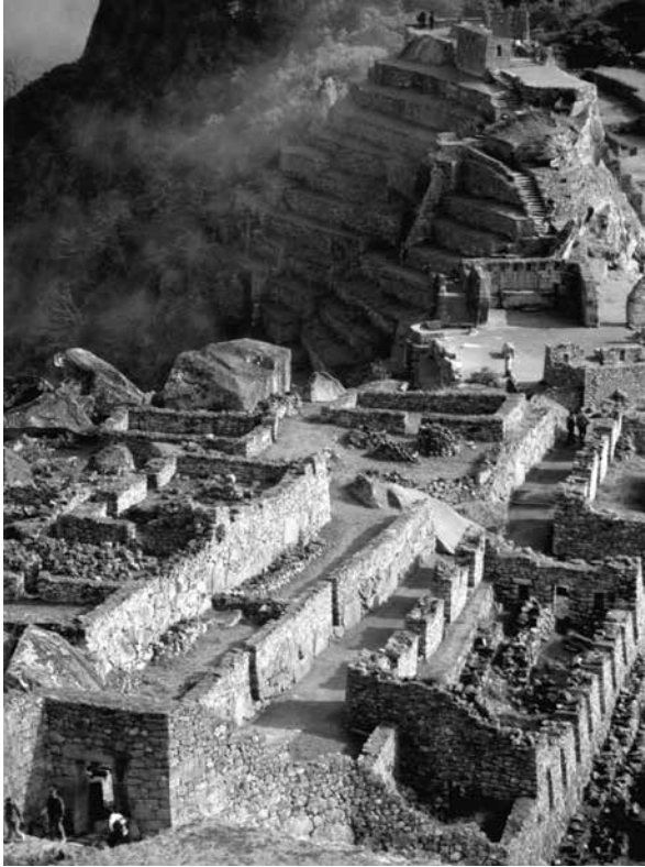
Figura 2. La única puerta de entrada a Machu Picchu se muestra abajo a la izquierda. Hay dos aberturas estrechas localizadas más allá de la puerta que dirigen a espacios para el cuidado de las llamas que servían como bestias de carga, en tanto que a lo largo del sendero se encuentran depósitos para el despacho y almacenaje de alimentos.
