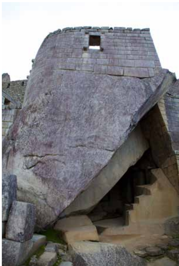
Figura 10. El Torreón, sin duda alguna, fue un templo solar y un observatorio. Esta construcción se levanta sobre una gran roca bajo el principio de adaptación de la arquitectura a la naturaleza. En la parte inferior del Torreón se aprecia una gruta cuyas paredes interiores han sido ricamente trabajadas en forma de escalera.
