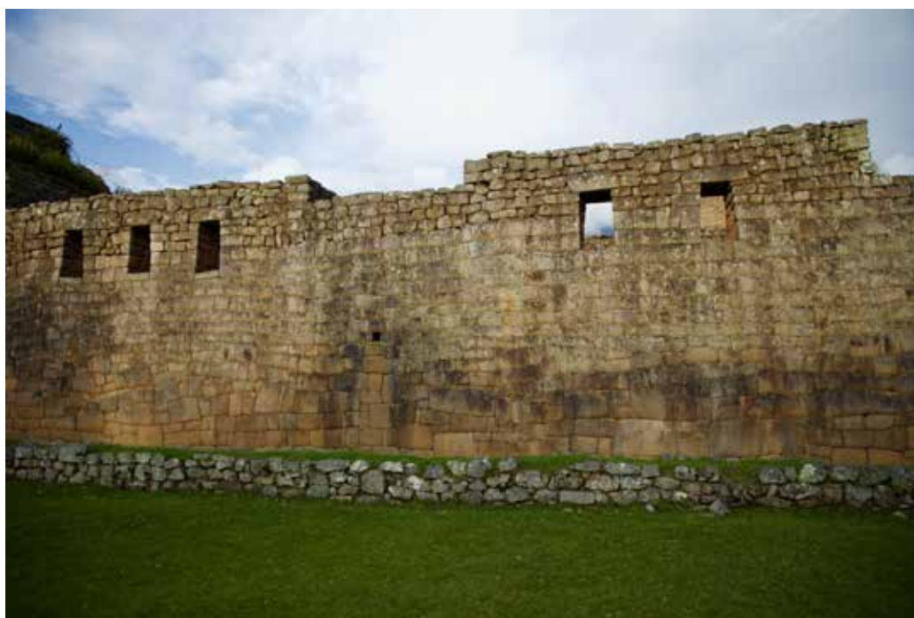
Figura 43. Los recintos de la parte superior estuvieron enlucidos con arcilla rojiza; nótese la coloración del muro externo, que coincide principalmente con el nivel del piso de los recintos superiores (fotografía: José M. Bastante).
