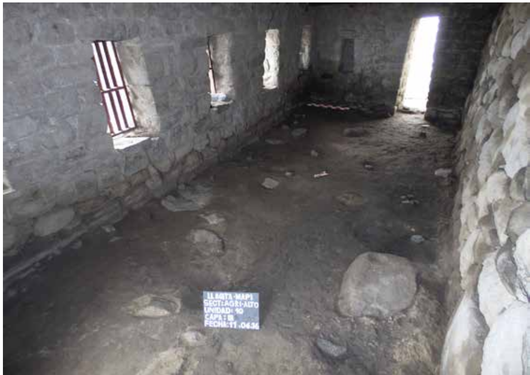
Figura 16. Vista interna del recinto 1-UE10.
