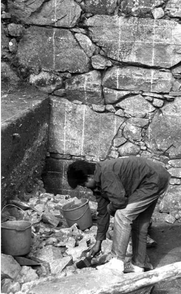
Figura 19. Miles de fragmentos de roca provenientes de los trabajos de corte de piedras que se efectuaron en Machu Picchu proporcionaron drenaje al subsuelo de una forma muy parecida al moderno drenaje francés.
