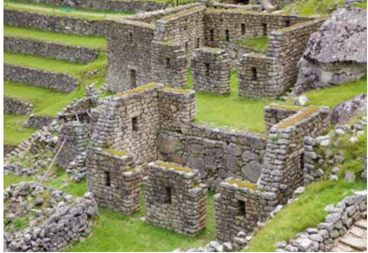
Figura 5. Se observan los recintos del conjunto 40, cuyos muros de sostenimiento y laterales no presentan amarre (fotografía: José M. Bastante).
