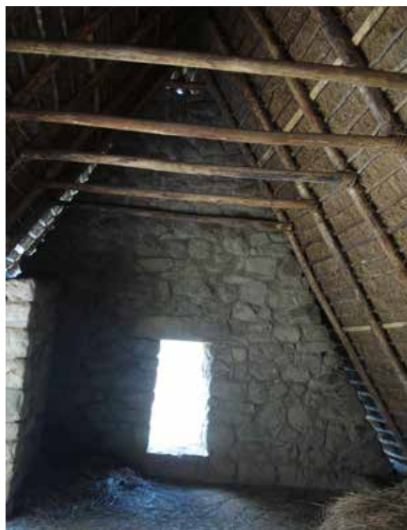
Figura 23. Techo a dos vertientes; corresponde a una edificación de dos pisos ( markawasi ) en la que se aprecia el mojinete y las vertientes de diferentes longitudes.
