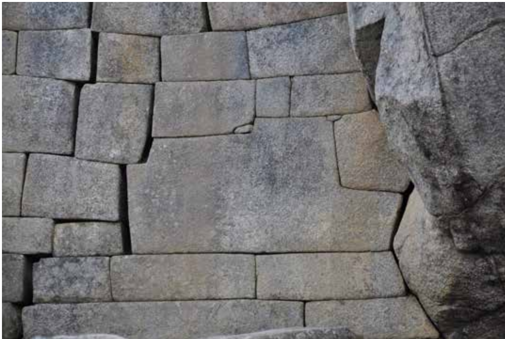
Figura 6. Roca de cantera inka ; se aprecia las líneas de los clivajes o disyunciones, lo que facilita la extracción de los trozos de roca (fotógrafo: Manolo Chávez).
