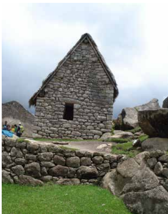
Figura 40. Techo a dos vertientes de diferentes longitudes laterales. Se muestra el perfil de una wayrana simple, próxima a la Roca Sagrada. Es posible considerar este diseño para el techo del Templo Principal.
