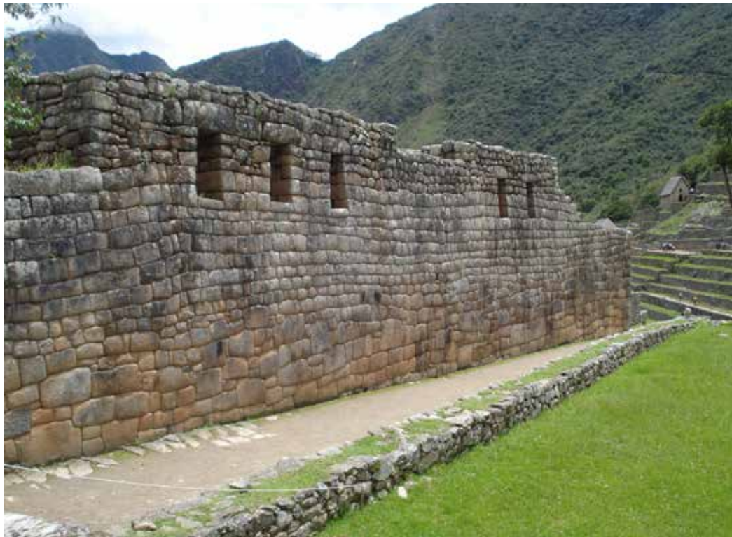
Figura 13. Muro que integra el conjunto Los Morteros; en su paramento se observan líticos diversos de diferentes tamaños y formas y de fina cantería.
