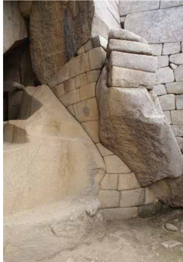
Figura 26. Aparejo que actúa como una cuña para dar estabilidad a las rocas laterales del Mausoleo Inka.
