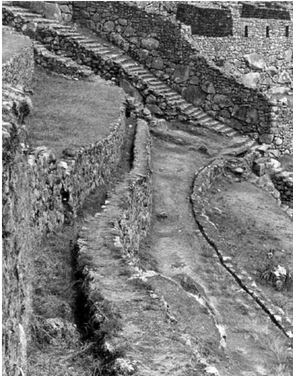
Figura 24. Este largo canal de drenaje de gran capacidad, que iba hacia el drenaje principal, fue construido en un área donde los ingenieros incaicos sufrieron un temprano deslizamiento de tierra que fue satisfactoriamente estabilizado. El Canal del Inca está a la derecha.
