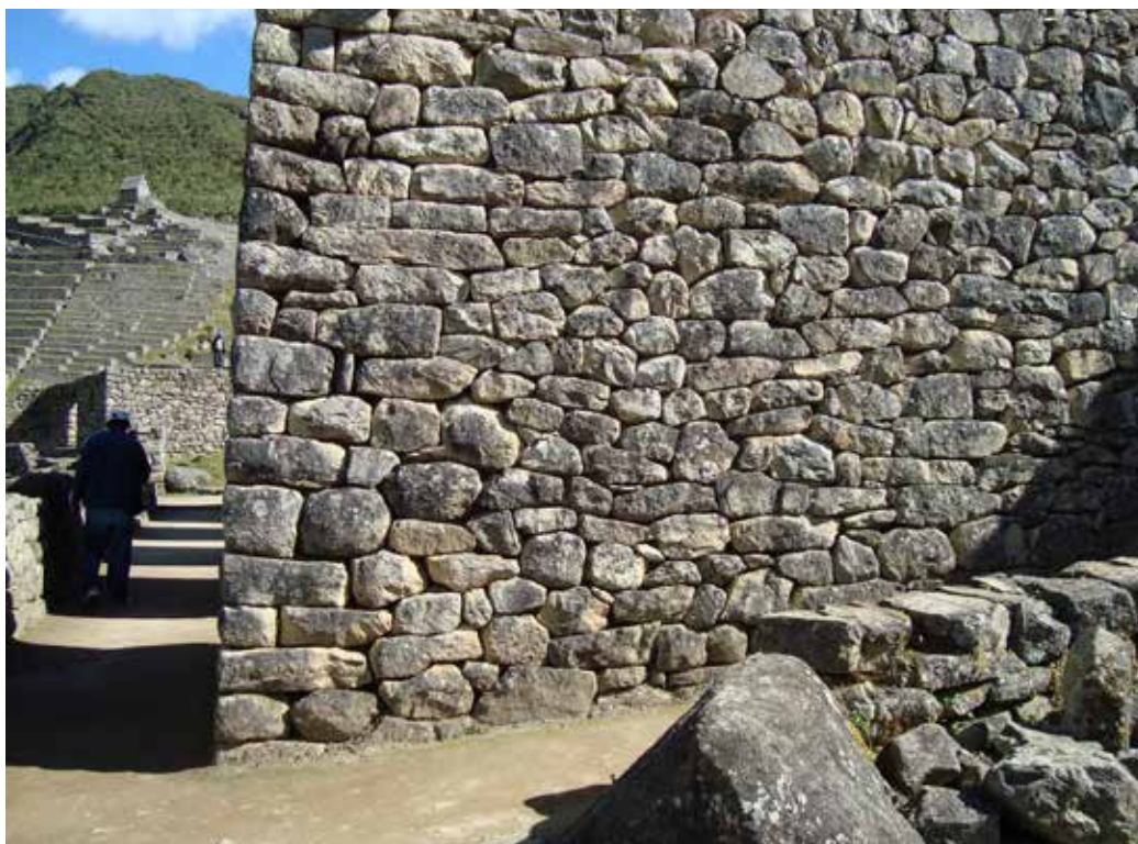
Figura 10. Estilo de aparejo celular simple sin mortero.
