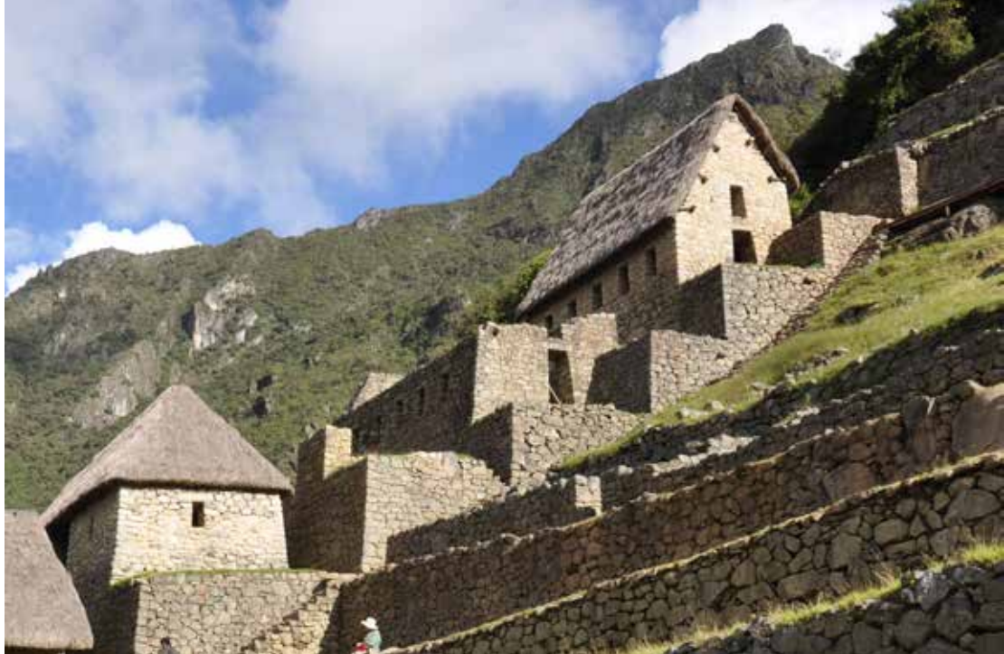
Figura 24. Cobertura de techos; arriba: la edificación del markawasi a dos vertientes; abajo: el recinto de la qolqa a cuatro vertientes.
