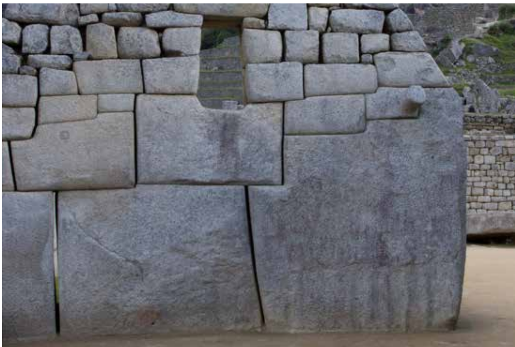
Figura 16. Planos helicoidales en las uniones de los elementos líticos del Templo de las Tres Ventanas (fotografía: José M. Bastante).
