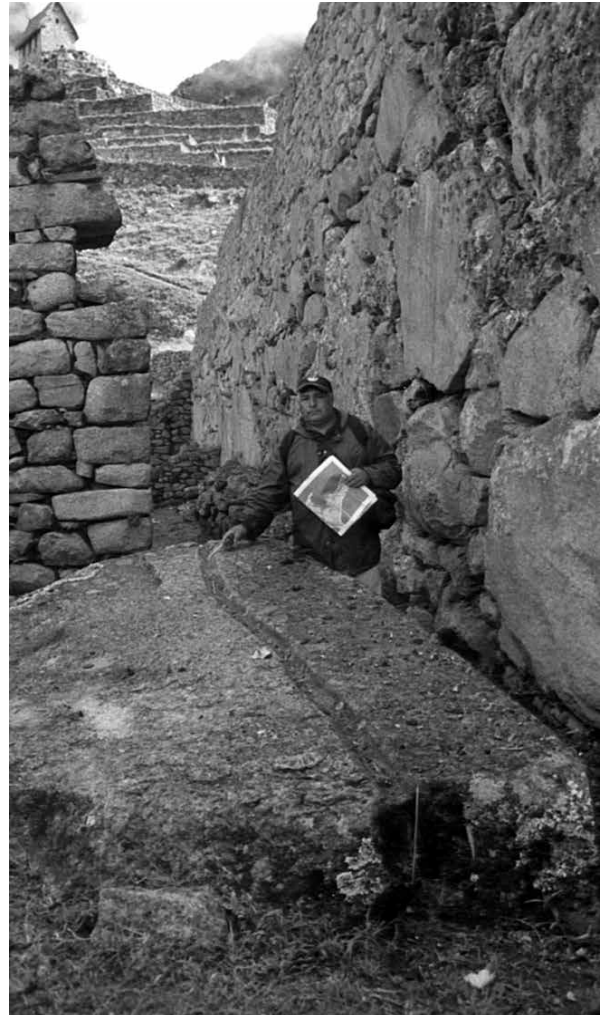
Figura 15. El agua que caía de los techos de paja era a veces captada por canales de piedra a lo largo de la línea de goteo, canales análogos a las canaletas para lluvia. El doctor Valencia Zegarra señala el alineamiento que tuvo el borde del techo de paja. La Casa del Guardián, con techo de paja, se ve en la parte superior de la foto.
