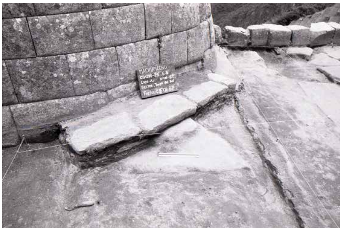
Figura 30. Goterones en la base del muro elíptico del Templo del Sol (fuente: Ramos 1987).
