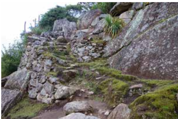
Figura 12. Muro asentado al afloramiento rocoso del borde del precipicio en la zona Andenes Orientales (fotografía: Alicia Fernández).
