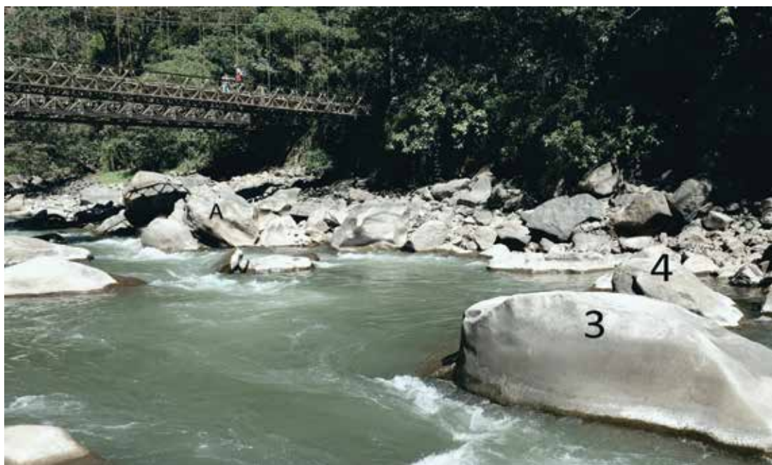
Figura 6. Ubicación del lugar de la foto anterior, en relación al Puente Ruinas (fotografía: José M. Bastante).
