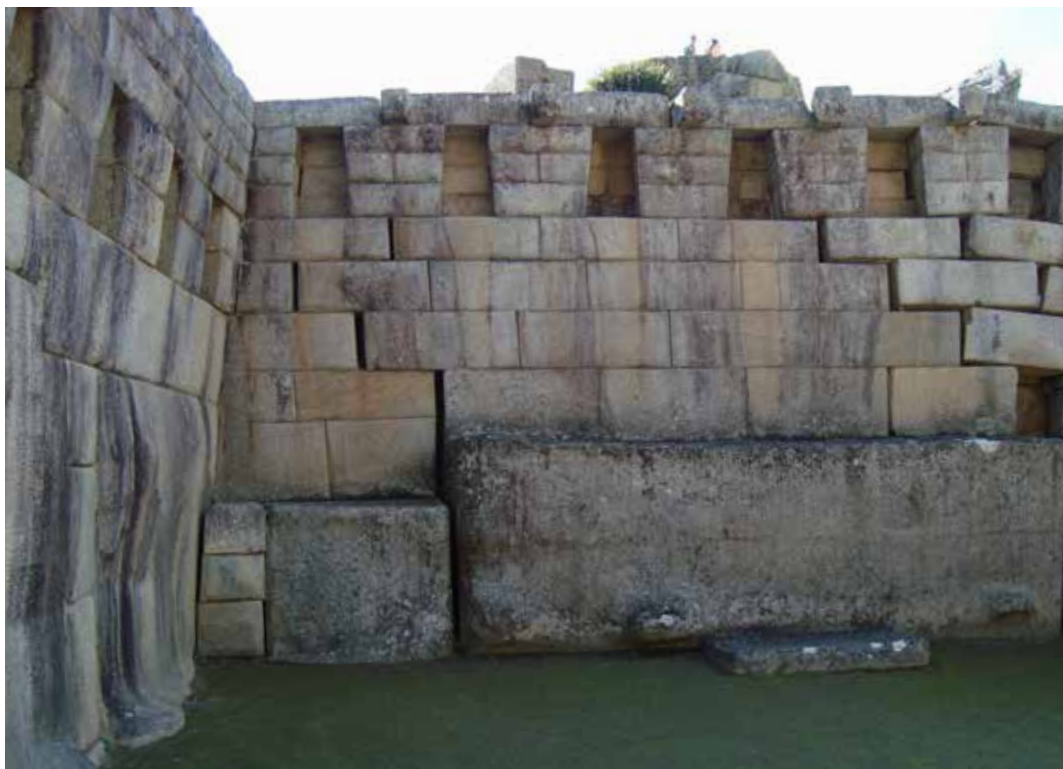
Figura 36. Detalle del Templo Principal: dos piezas líticas, la primera tiene 1.00 m de altura; la segunda 4.25 m de largo, 1.40 m de alto y 1.00 m de espesor y pesa 16 toneladas. Ambas soportan parte del muro; se percibe un asentamiento diferencial permisible.
