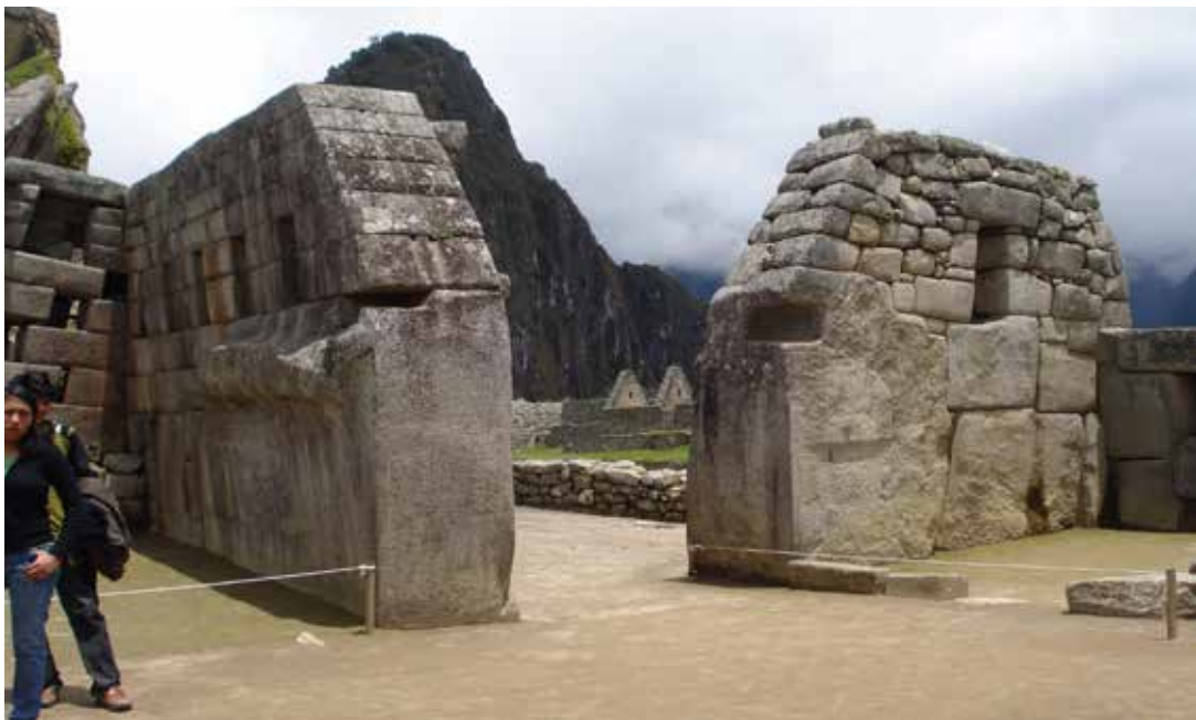
Figura 39. Piezas megalíticas de los muros laterales del Templo Principal y del Templo de las Tres Ventanas; cajuelas para el empotramiento de vigas de madera y, además, proyección inclinada de los mojinetes. En ambos casos, la solución al tipo de techo es a dos vertientes.
