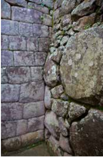
Figura 4. Muro de la plataforma y muro de recinto en la Casa del Inka (fotografía: José M. Bastante).
