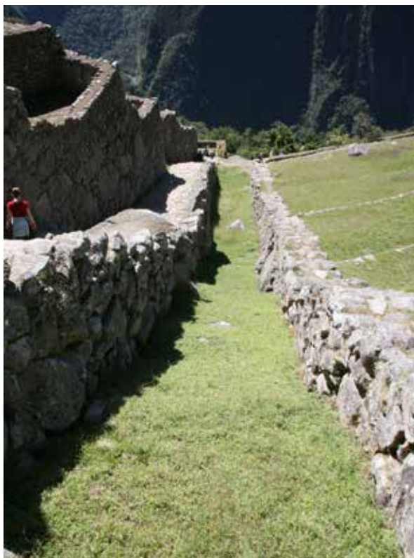
Figura 2. Se aprecia el foso seco, que divide las zonas agrícola y urbana. Es coincidente con una falla geológica, conocida por los constructores inka , por lo que no existe edificación alguna (fotografía: Ruperto Márquez H.).
