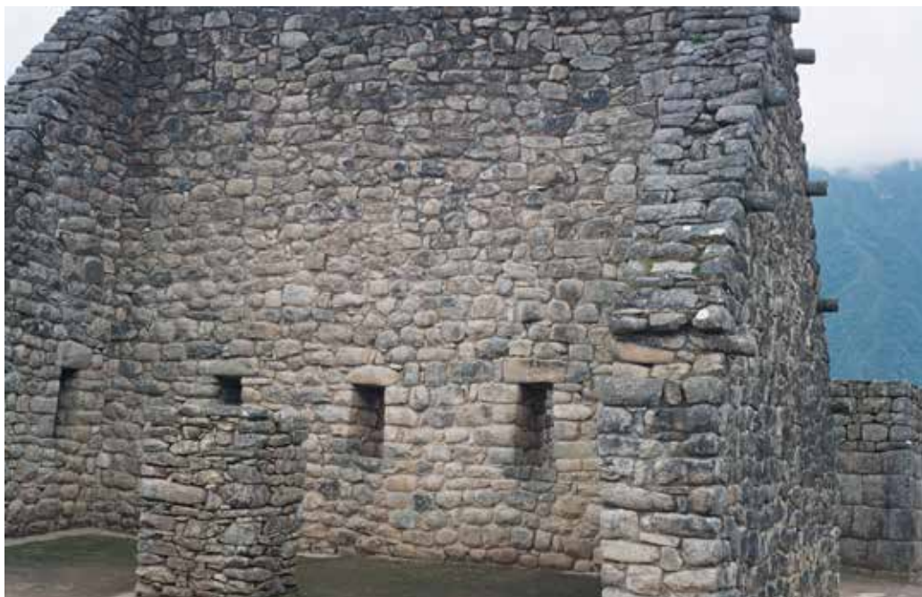
Figura 31. Wayrana doble, constituida por dos recintos simples unidos por el muro divisorio del fondo; ver, además, la pilastra central para apoyo de la viga de madera y el techo.
