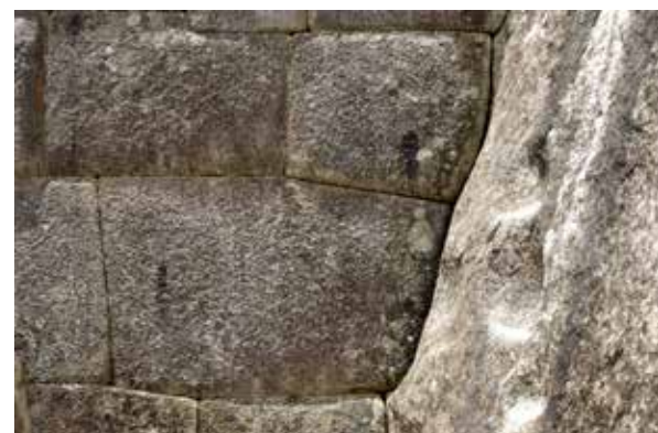
Figura 27. En el lado derecho, una roca de granito de gran tamaño; en el izquierdo, el muro de contención para dar estabilidad a la roca.
