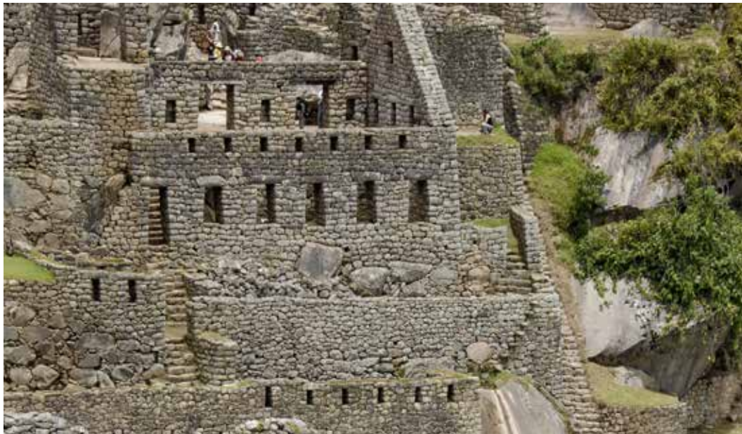
Figura 8. Edificación de dos pisos de uso múltiple ubicada en el entorno del conjunto El Cóndor. Se observa el diseño arquitectónico adecuado a la topografía y las ventanas y accesos orientados al este, con fin bioclimático (fotografía: Teo Allain Chambi).
