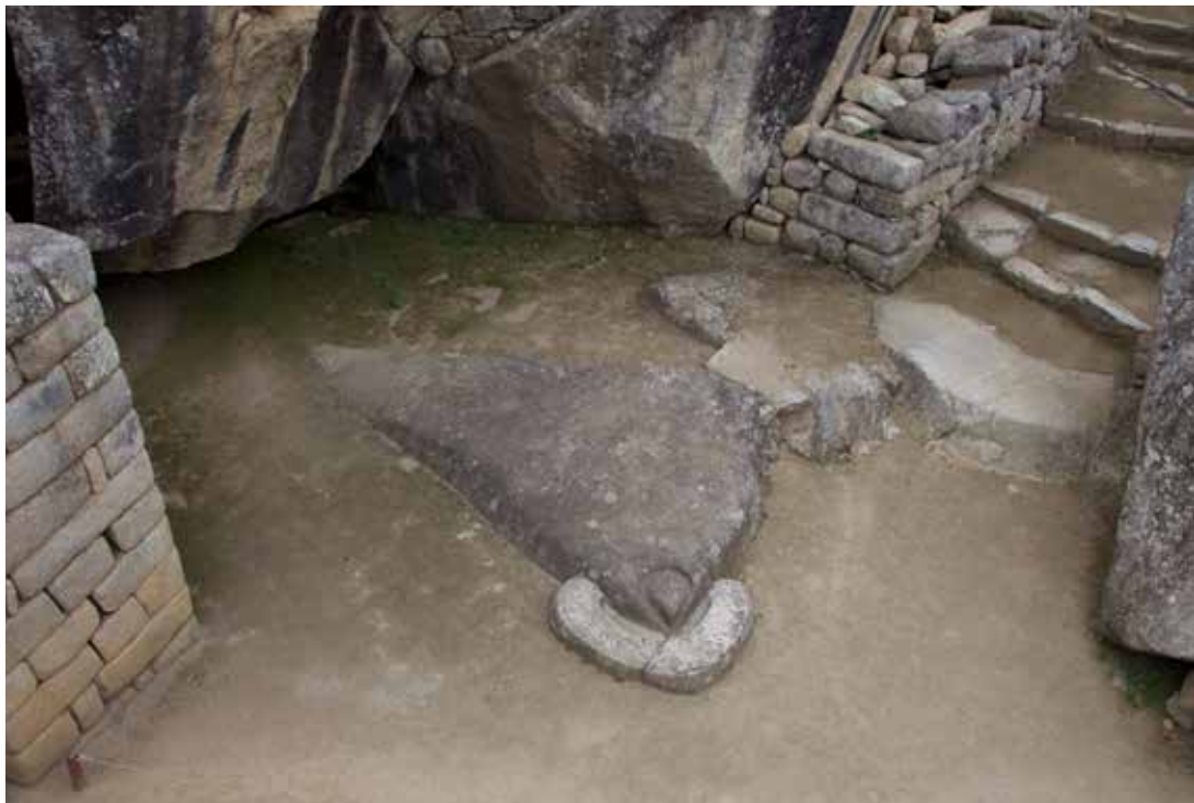
Figura 17. La adaptación de la creación humana al medio geográfico es ostensible en varios espacios de Machu Picchu en los que la arquitectura cerrada se relaciona con el exterior mediante puertas y ventanas o por la prescindencia de muros completos, respondiendo a las exigencias del clima tropical.
