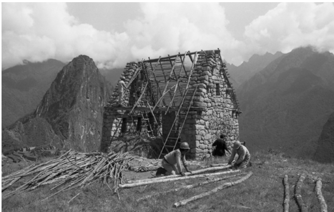
Figura 28. Acondicionamiento del techo de la denominada Casa del Guardián (recinto 4, conjunto 9) (fuente: San Román 1986).
