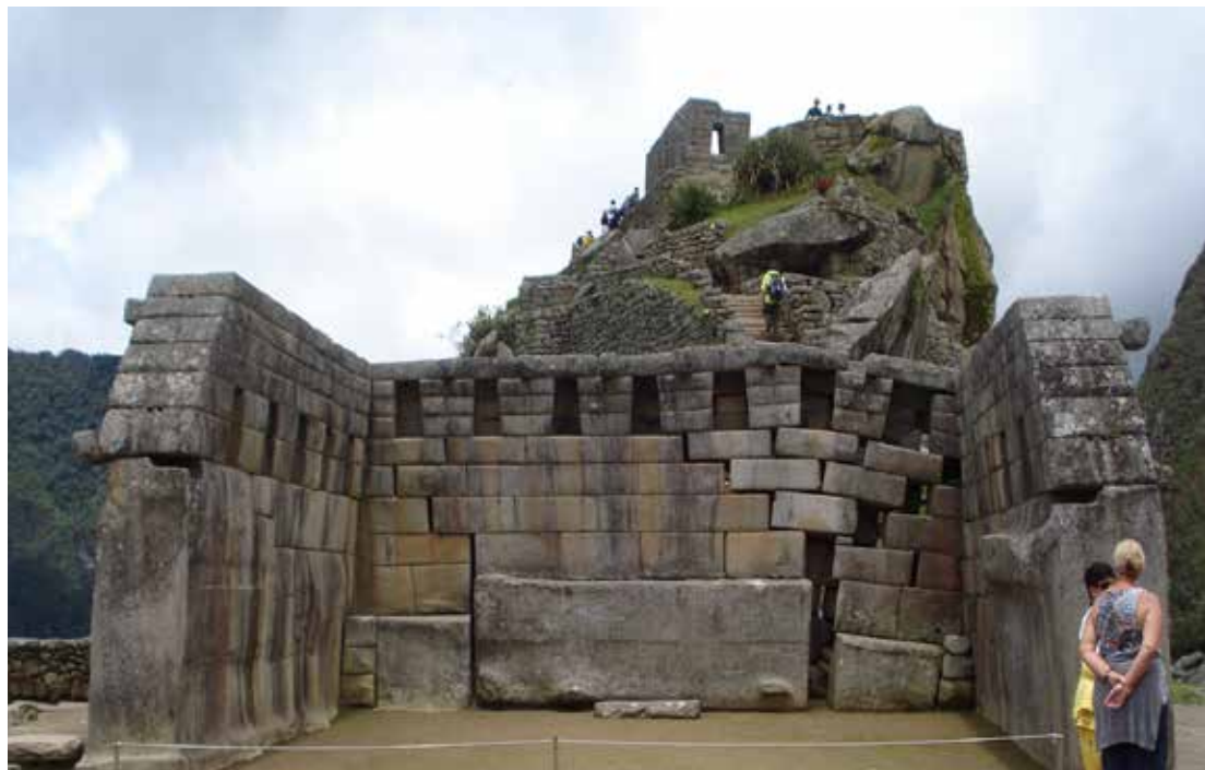
Figura 35. Templo Principal; al fondo se observa una piedra megalítica central; a ambos lados otras dos piezas líticas del mismo tamaño y estilo de unión con los muros laterales. En la esquina derecha, al fondo, se alteró el alineamiento horizontal y vertical de las juntas.
