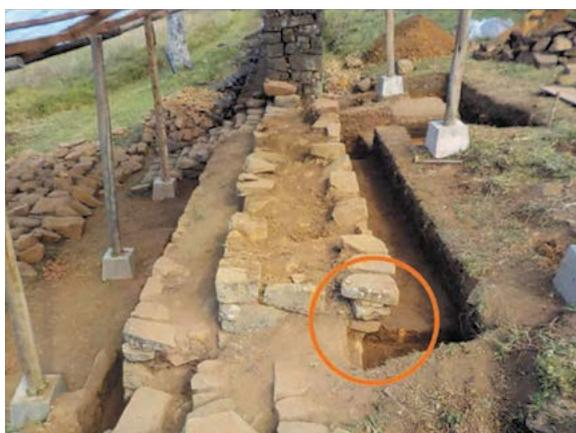
Foto 11. Extremo noroeste y parte interna con desfase de 24 centímetros y fuera del eje
