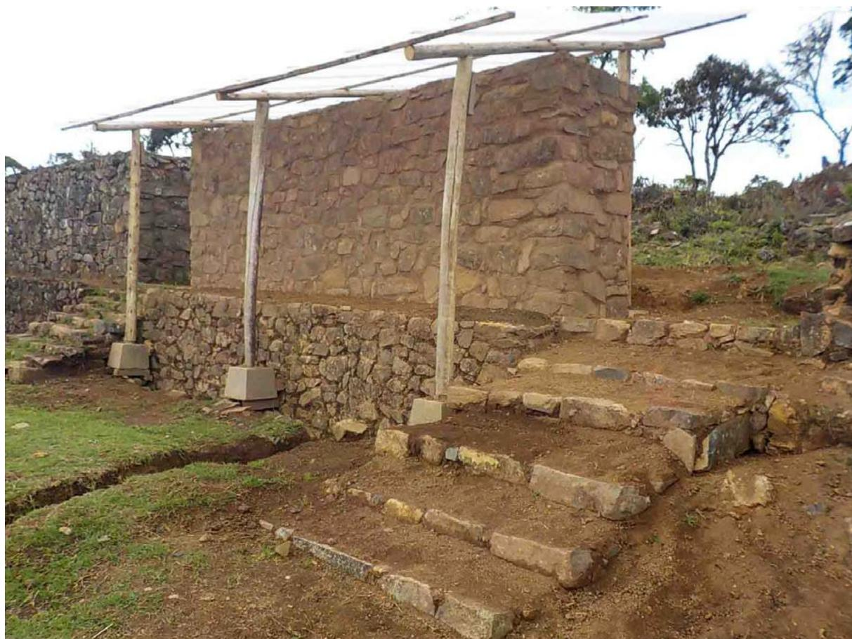
Foto 15. Muro 7 restaurado y con cobertura de protección
