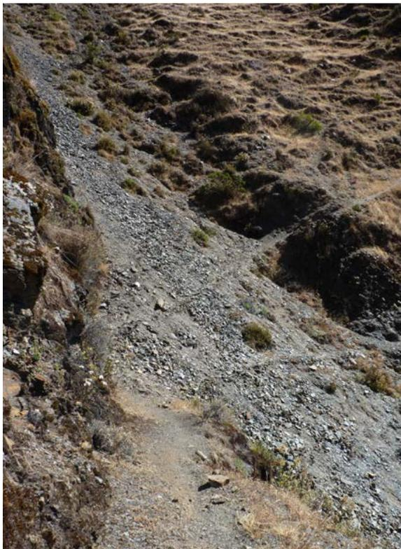
Foto 20. El camino ha sufrido los efectos de la erosión y la falta de mantenimiento. En lugares críticos como las quebradas, el camino está prácticamente borrado
