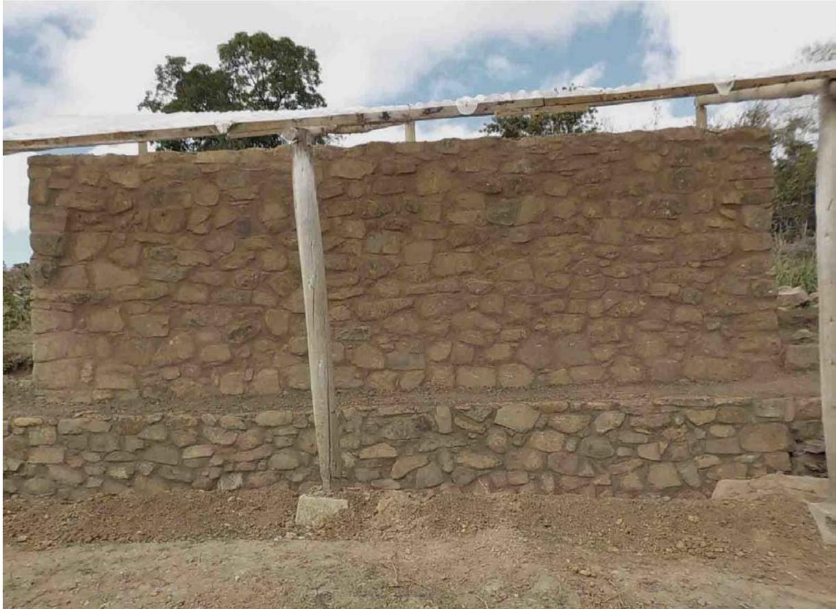
Foto 10. Muro 2 restaurado y con cobertura de protección
