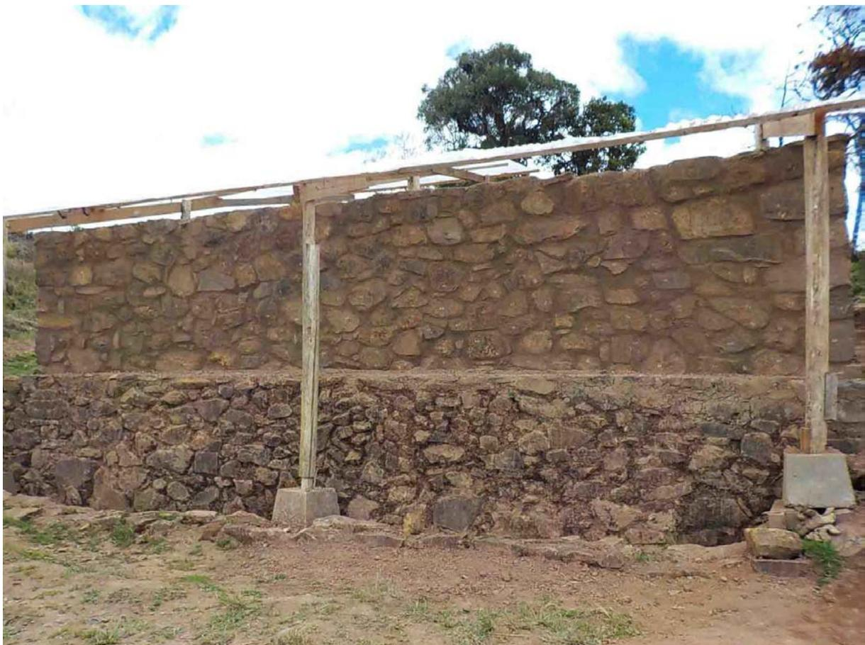
Foto 18. Muro 14 restaurado y con cobertura de protección
