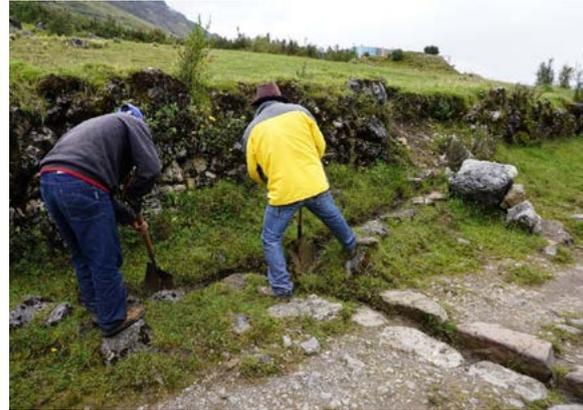
Foto 2. Limpieza de drenes y descolmatación de canales para evitar los desbordes e inundaciones
