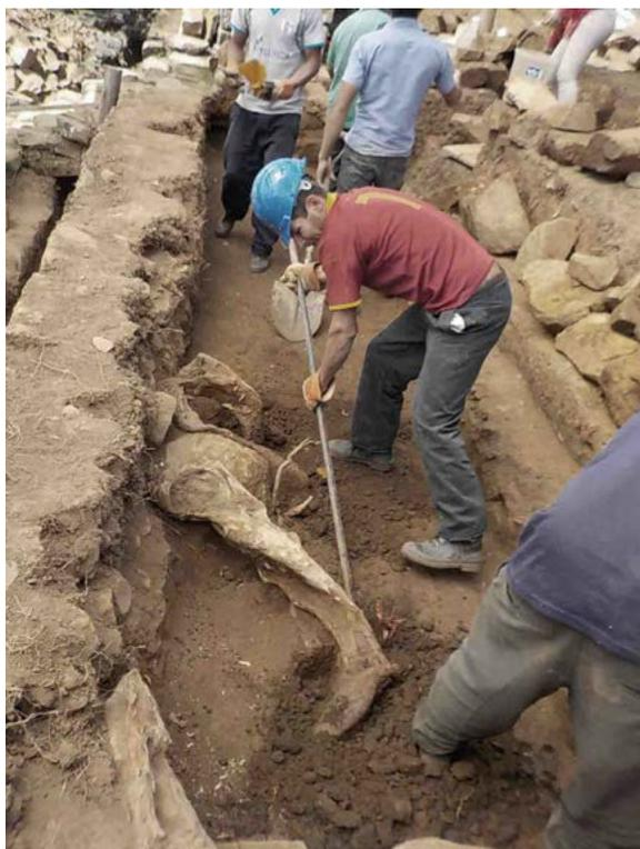
Foto13. Vista del retiro de las raíces vivas del "rapraguero", en la base del Muro 7
