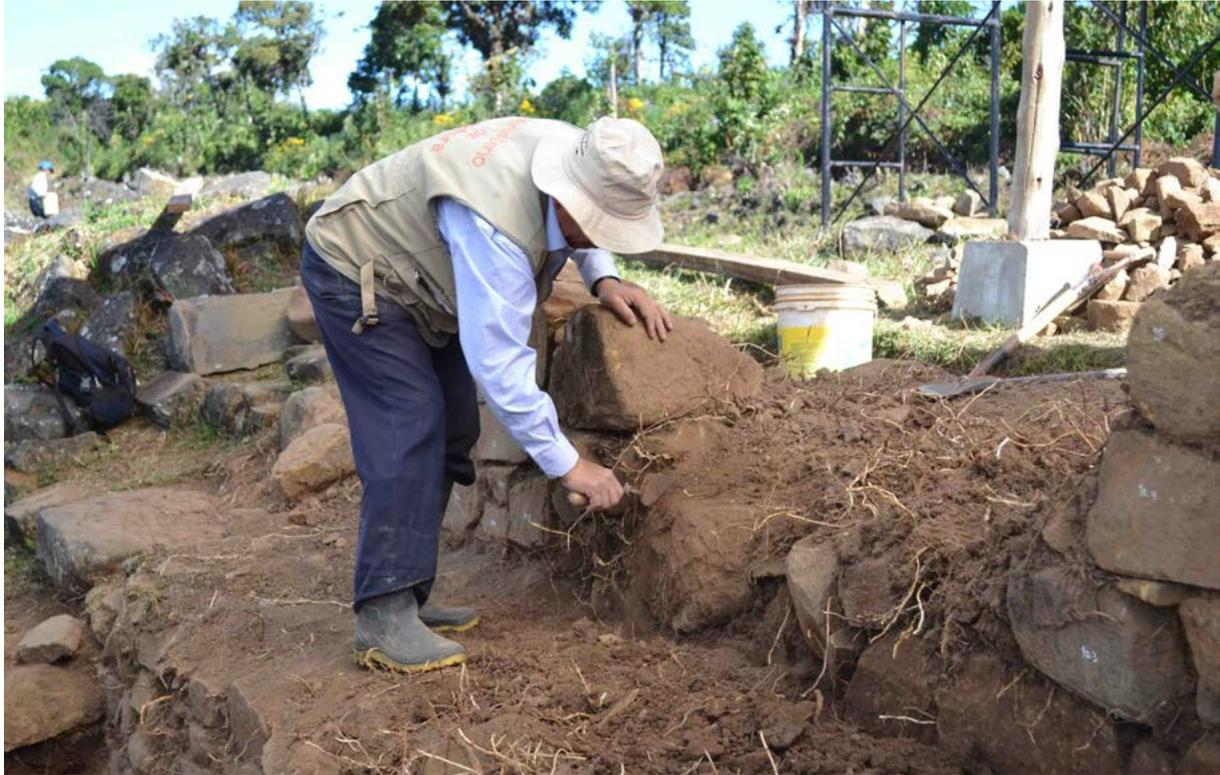
Foto 9. Proceso del desmontaje del Muro 2. Se observa abundante presencia de raicillas de vegetación herbácea
