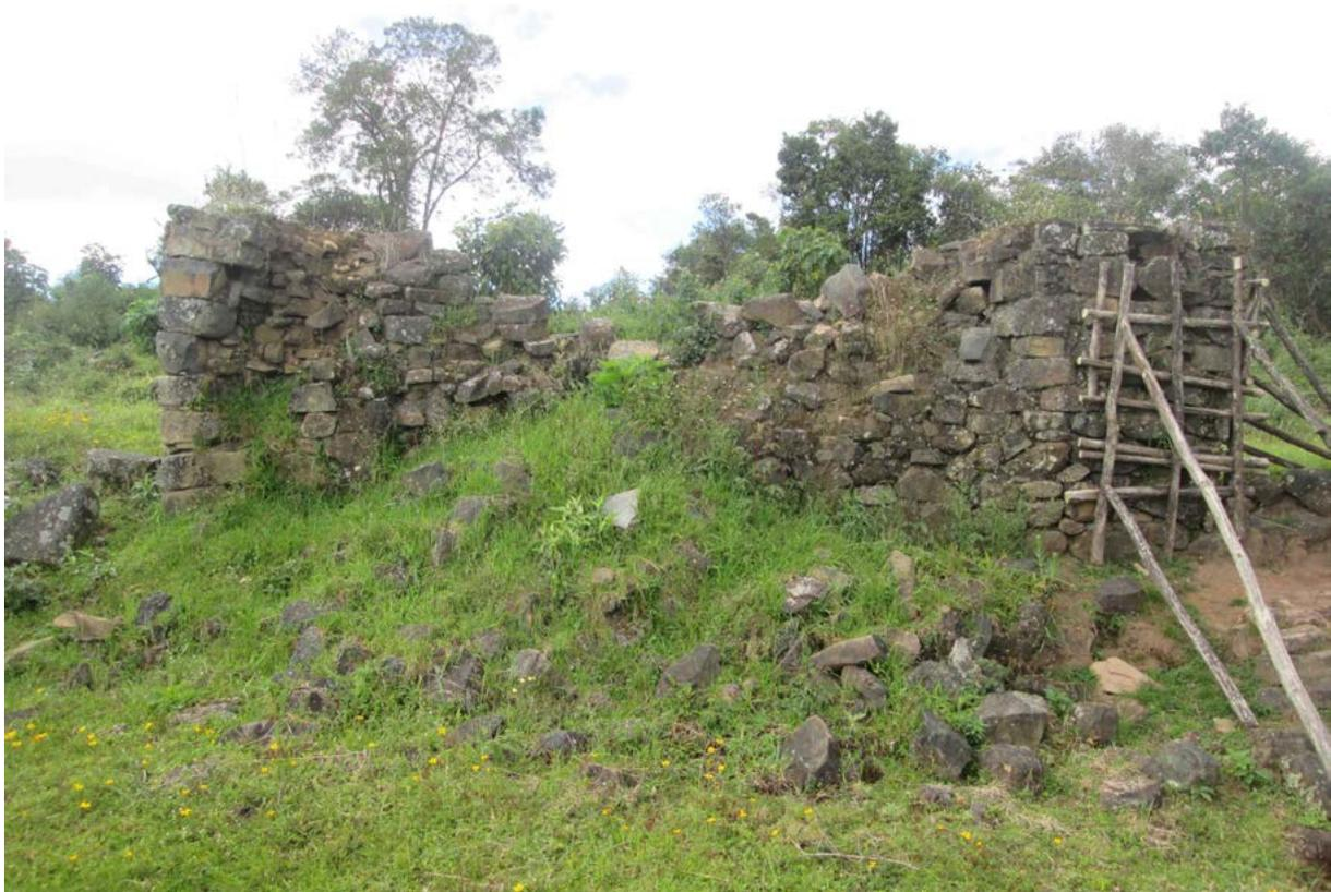
Foto 8. Colapsado, con alto grado de pandeo y agrietamiento (antes de su intervención)
