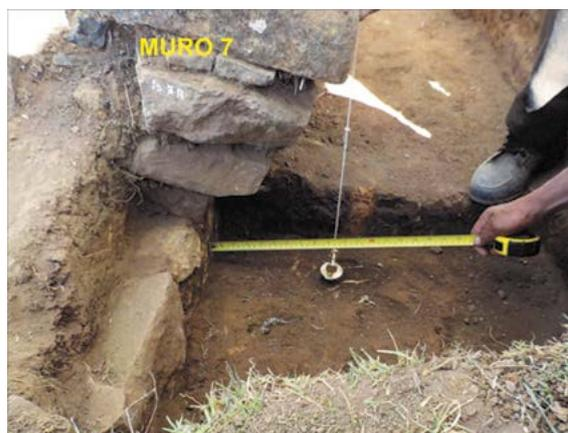
Foto 12. Extremo noroeste y parte interna con desfase de 24 centímetros y fuera del eje
