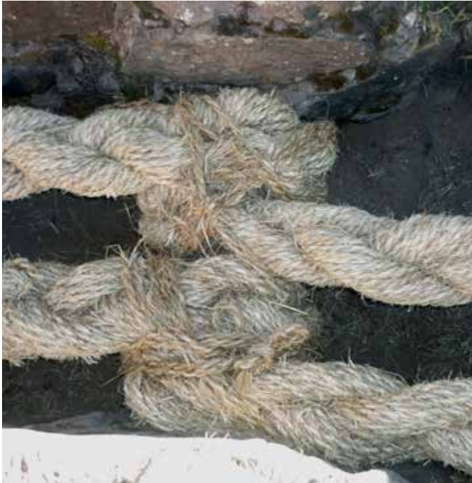
Las sogas se sujetan a las bases de piedra del puente.
