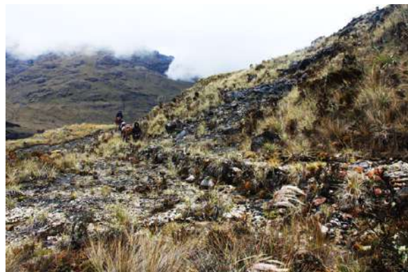
Parte del camino empedrado con muros de contención entre la cueva Manachaqui y Laguna Empedrada, del sub tramo Chirimachay - Gran Pajatén. Fotografía: Proyecto Qhapaq Ñan.
