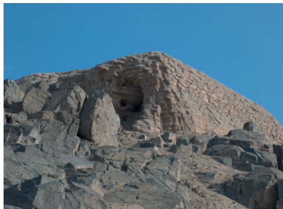
Foto 4. Detalle de la esquina noreste del edificio inca. Nótese los muros elaborados con pequeños adobes paralelepípedos (el forado es producto del saqueo). Vista hacia el suroeste (foto por José L. Matos/Rodolfo Peralta)
