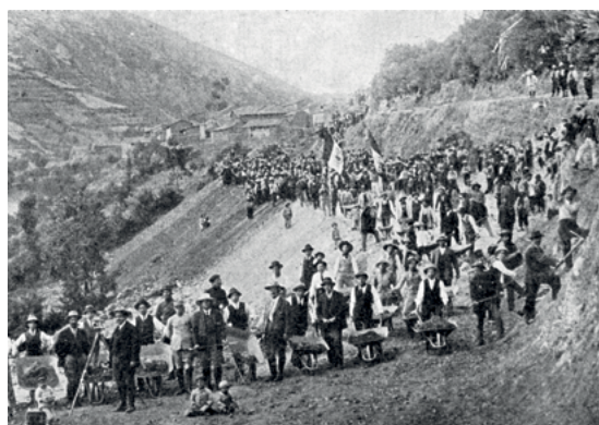
Fotos 2 y 3. El proceso de construcción de carreteras durante los años 1919-1930, labor que fue asumida mayoritariamente por las comunidades indígenas. Obsérvense los cortes de ladera a fin de nivelar el terreno para el trazado de las nuevas vías (Anónimo 1921: 1864-1865)
