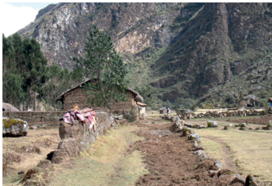
Fotos 8 y 9. Trabajos de reconstrucción del camino que va entre Conín y Huallanca. Este camino fue descrito por Middendorf en 1880 (fotos: Proyecto Qhapaq Ñan)
