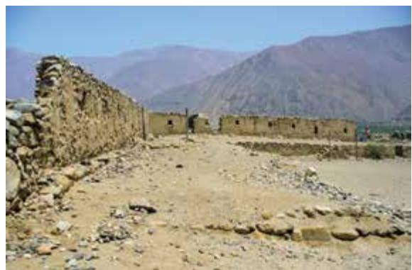
Foto 18. Plataforma en L perteneciente a la Estructura I de Huaguil
