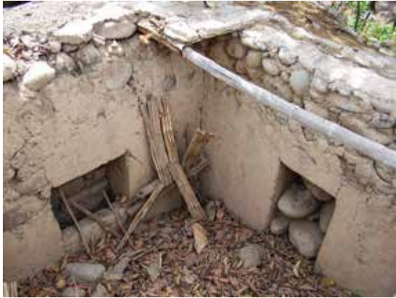
Foto 10. Detalle del interior de la estructura rectangular con sus vanos de acceso
