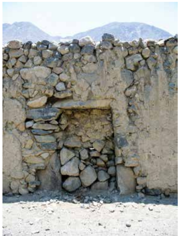
Foto 20. Vano de acceso sellado en el muro sur de Huaguil
