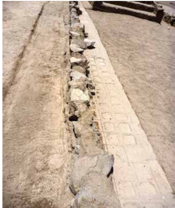
Foto 15. Fragmento de franja elevada en buen estado de conservación al estar cubierta por el relleno constructivo del camino elevado
