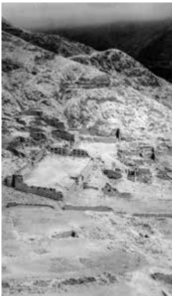
Sector provisto de recintos con ventanas cuadrangulares y triangulares en el sitio Incahuasi de Lunahuaná (tmx-f-1074)
