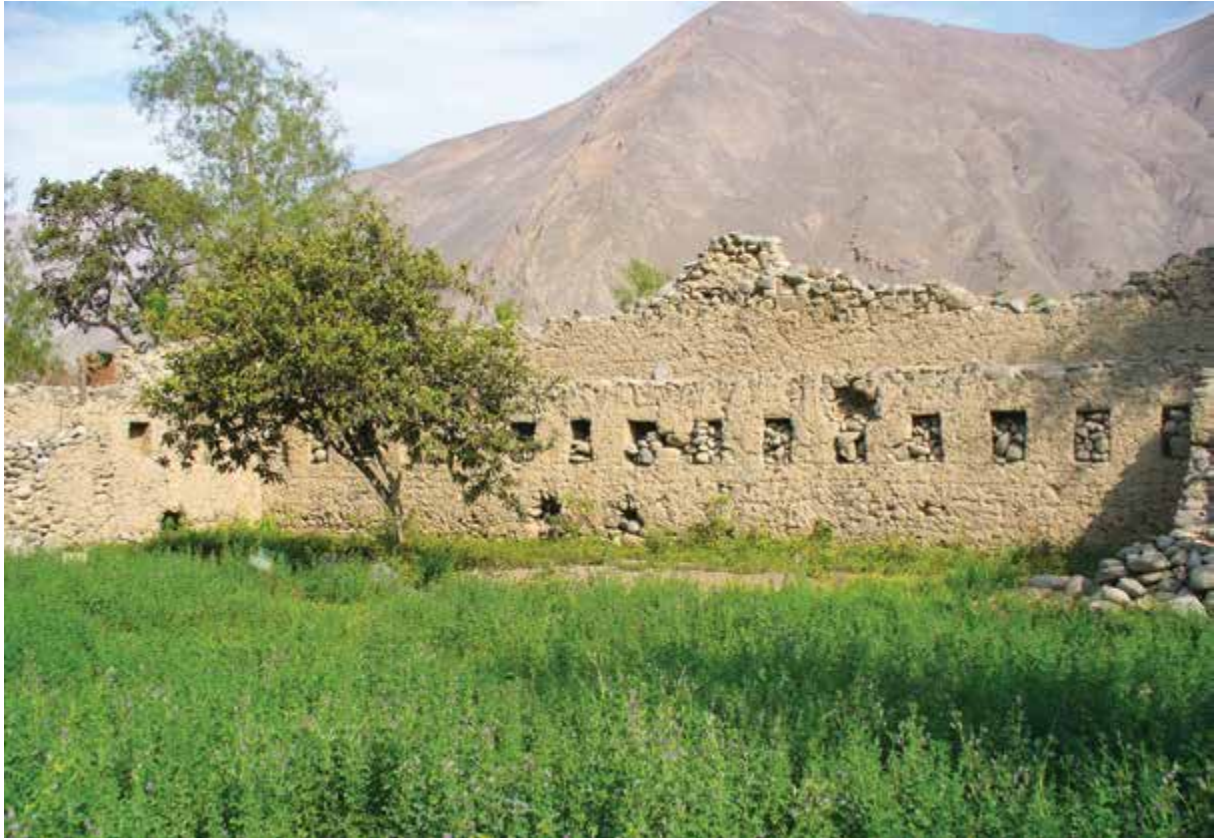
Foto 1. Vista de uno de los ambientes con hornacinas rectangulares
