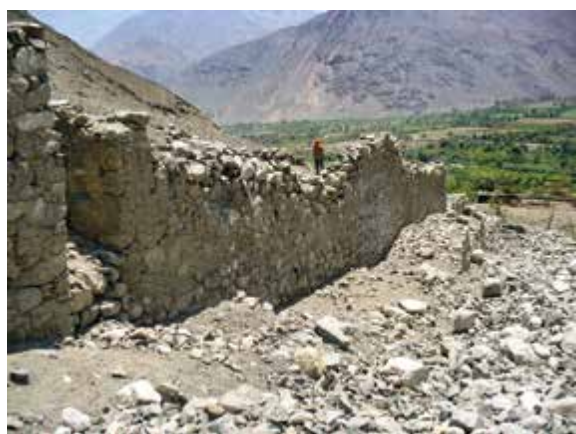
Foto 24. Muro noreste de la Estructura IV
