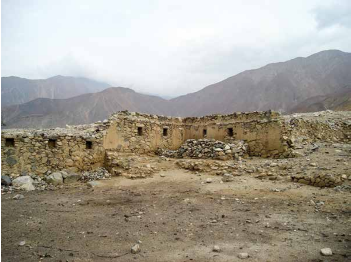
Foto 22. Muros del recinto N°2 de la Estructura II de Huaguil
