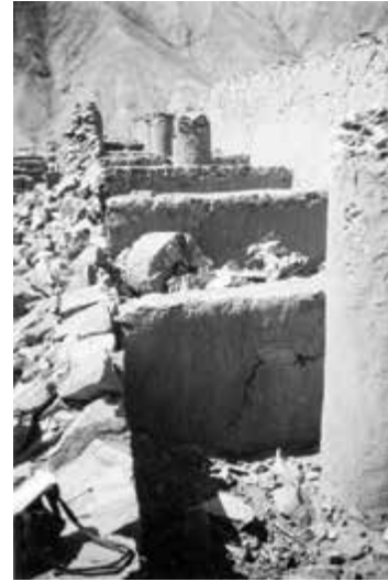
Vista de columnas cilíndricas localizadas al interior de las colcas de Incahuasi de Lunahuaná (tmx-0910)
