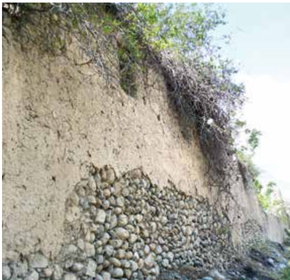
Foto 6. Muro con ventanas rectangulares
