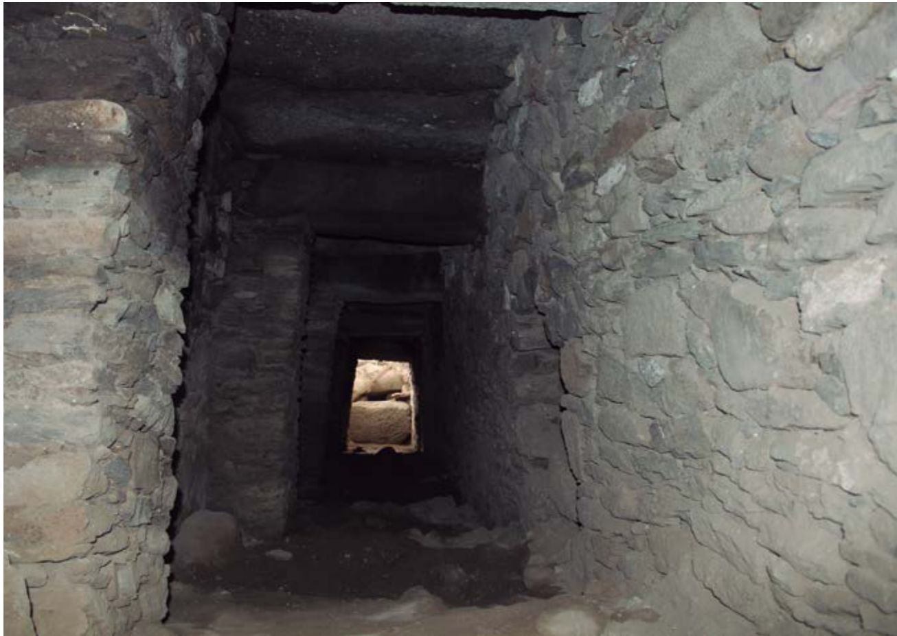
Fig. 1. Vista de las galerías subterráneas de corte trapezoidal con lajas de piedra en los dinteles.
