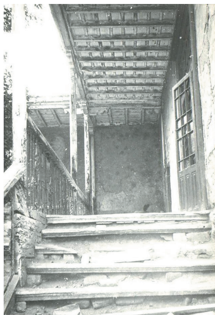
Detalle de escaleras.
