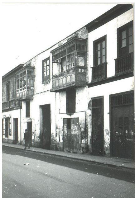
Fachada del inmueble Jr. Ancash 935-937.
