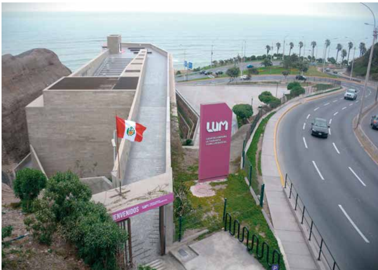
Vista exterior del ingreso peatonal LUM, por Bajada San Martín.
