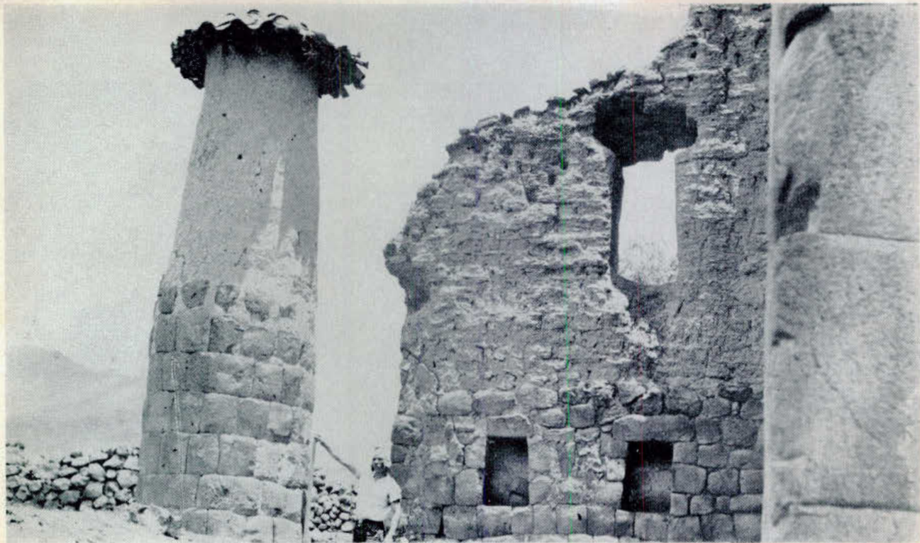
La única columna de las 22 que existían en el Templo de "Wiracocha", a razón de 11 a cada lado de un muro central. El fin de las columnas era sostener un segundo piso y el techo. También se observa la cara interior del muro lateral Sur, con sus nichos y ventanas.
